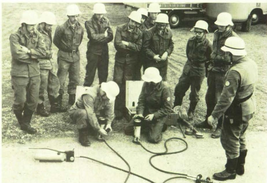
Links: Vielseitig ist die Verwendung von Leitern als Hilfsmittel zur Bergung aus Höhen. Am Trümmerobjekt in Mülheim erlernen Lehrgangsteilnehmer das Ablassen von Verletzten mit dem Leiterhebel. — Rechts: Ausbildung im Umgang mit schweren hydraulischen Hebern (20 t). Zwei solcher Hydropressen gehören zu jeder Ausrüstung eines Bergungszuges.
