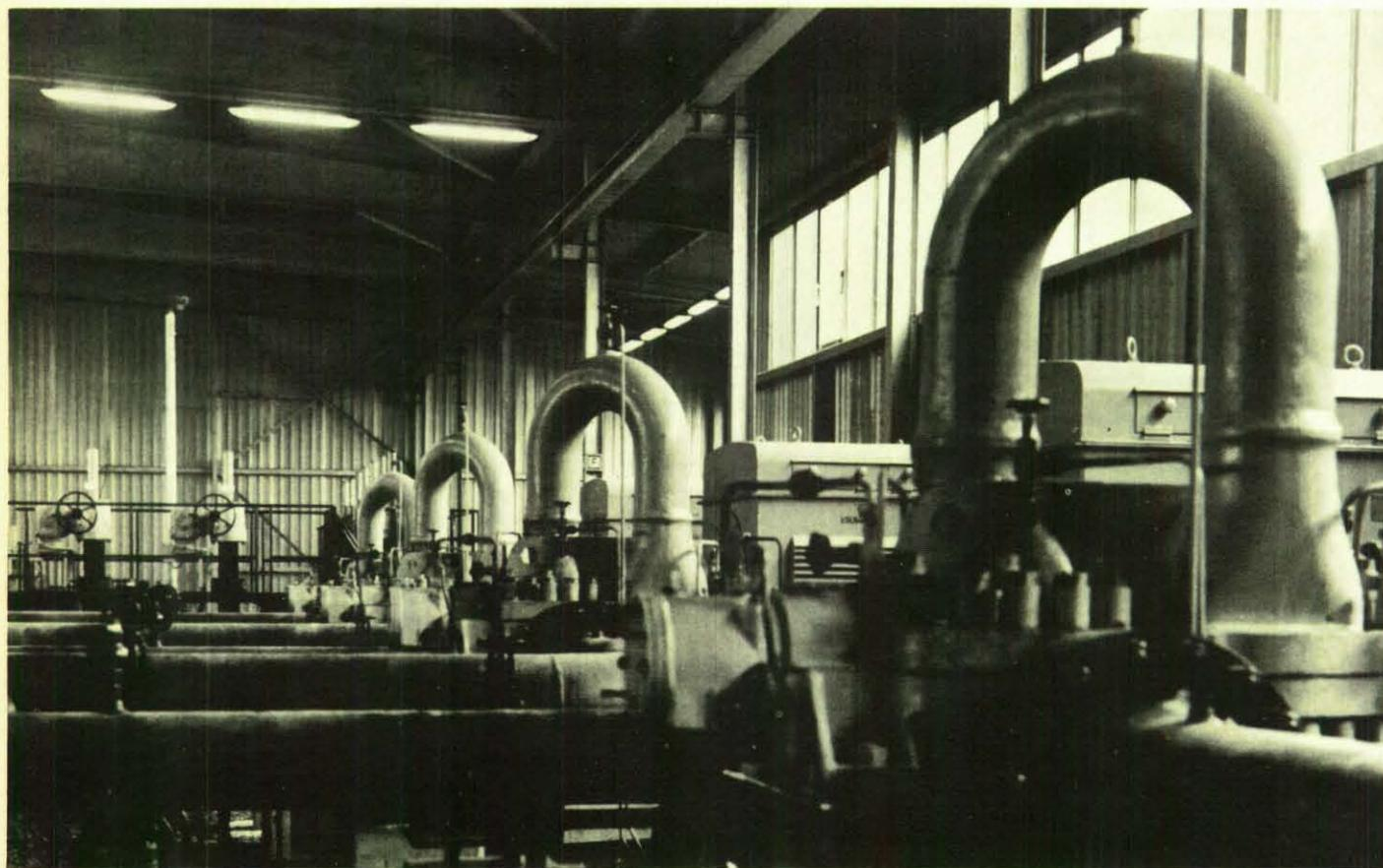
**Blick in die große Pumpenhalle. Auch hier sieht man keine Beschäftigten. Alle Elektromotoren und Pumpen werden vom Leitstand aus bedient. Bis der vorgesehene Speicherraum an Mineralöl erreicht ist, werden noch viele Kubikmeter Sole und Öl durch diese Rohre fließen.**
