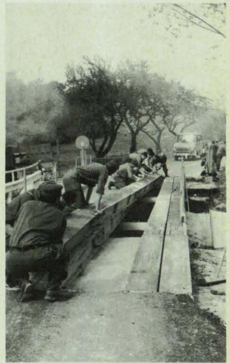
Die Brücke wird für größere Belastungen verstärkt, anschließend wird der Belag aufgetragen.
