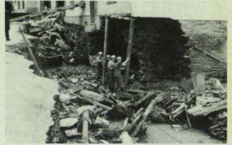
Helfer des OV Lahnstein bei der Abstützung eines beschädigten Wohnhauses. Die Fundamente des Hauses wurden vom Wasser unterspült.
