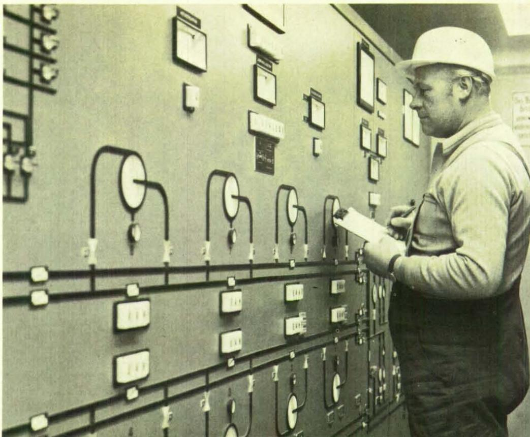
**Blick in den Leitstand der Hauptpumpstation. Alle Pumpvorgänge zwischen Löschrücke und Kaverne werden von hier aus vollelektronisch gesteuert. Zur Kontrolle der Instrumente ist nur noch eine Person erforderlich.**
