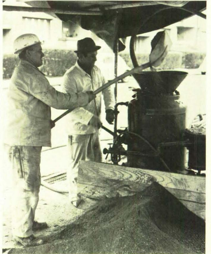
Mit dieser Maschine wird torkretiert; ein Mehr an Baustelleneinrichtungen ist nicht erforderlich.
