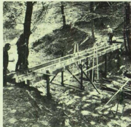
**Der OV Trier beim Bau einer Fußgängerbrücke von 12,00 m Länge.**
