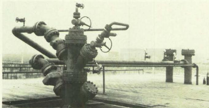
**Die Kaverne ist fertig gebohrt, die Bohranlage abgebaut. Als einzig sichtbares Zeichen der unterirdischen Anlage ist jetzt nur der Kavernenkopf zu sehen, der nun fertig zur Einlagerung von Öl ist.**
