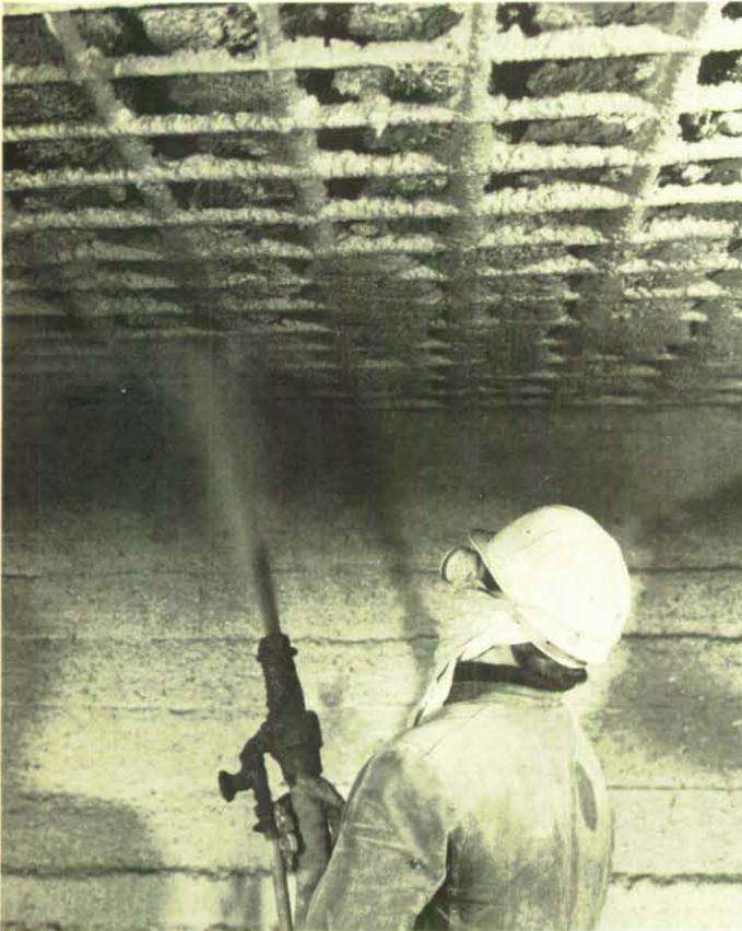
Der Torkretbeton wird an Decke und Bewehrung gespritzt.
