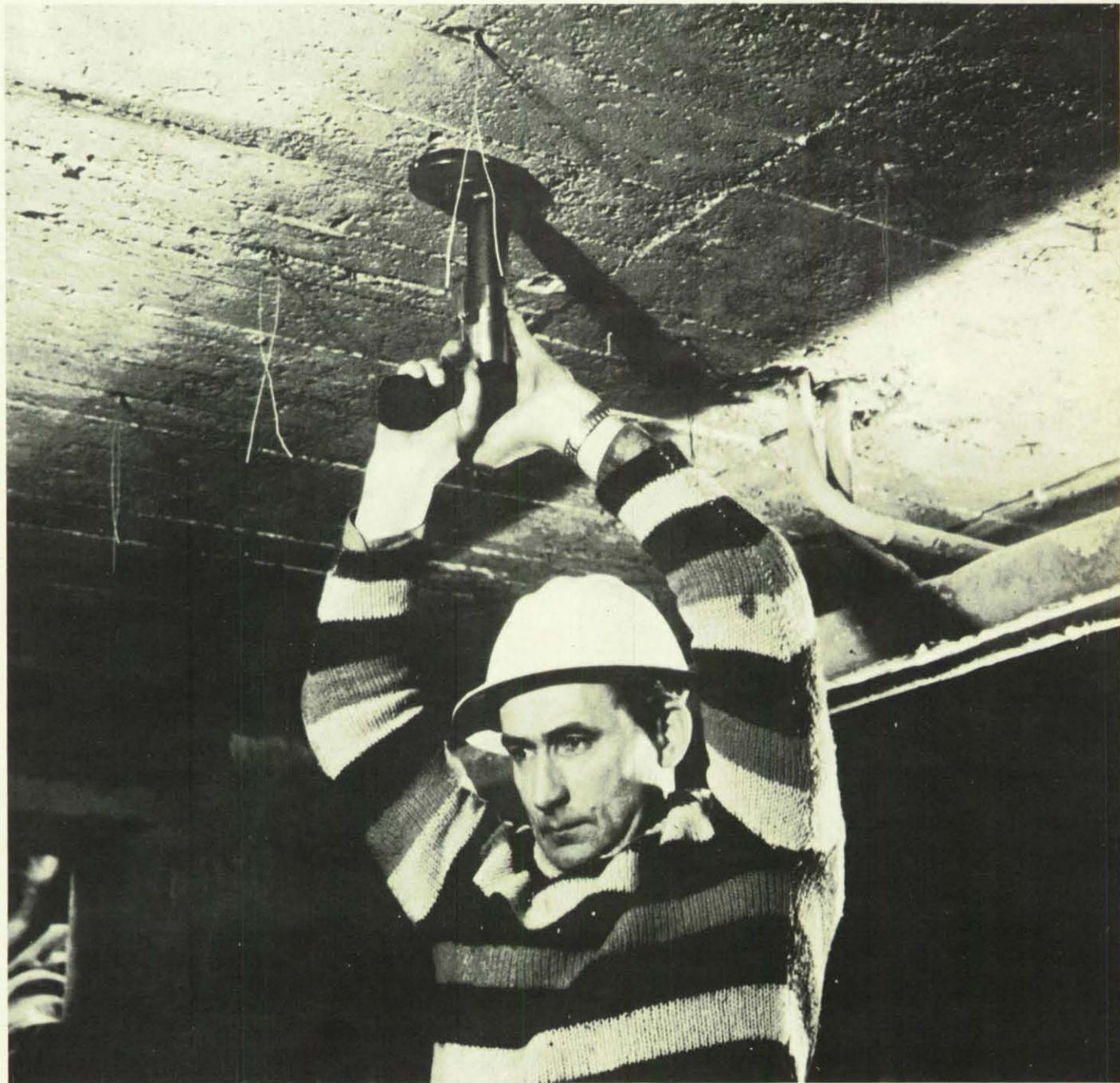
1. Die Dübel zur Befestigung der Bewehrung werden in die vorhandene Betondecke geschossen.
