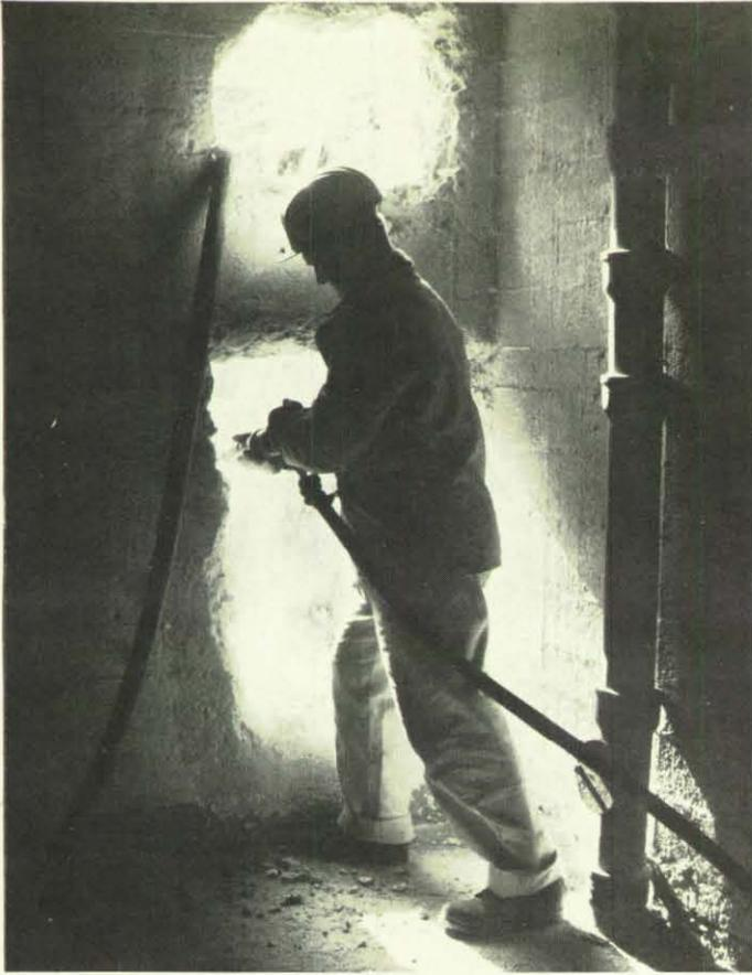
Öffnungen für Notausstieg und Entlüftung werden gebrochen.
