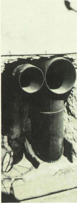
Entlüftungsrohre werden in die ausgestemmte Öffnung verlegt.
