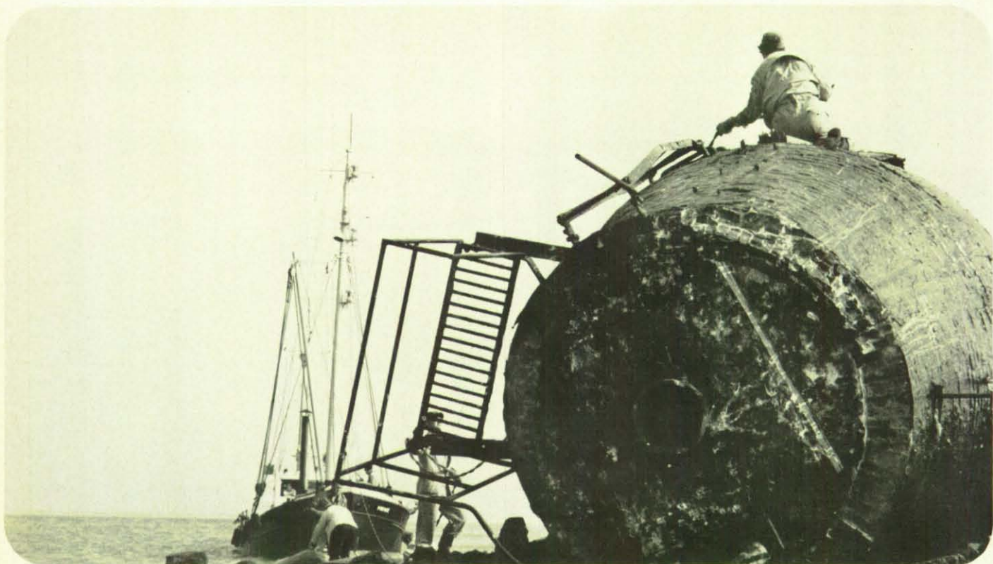
Blick auf den Turmkopf, in seiner Mitte der Pegelschacht; im Hintergrund die „Möwe“. Durch seitlich angebrachte Bohrlöcher wurde der Turm zur letzten Sprengung vorbereitet.
