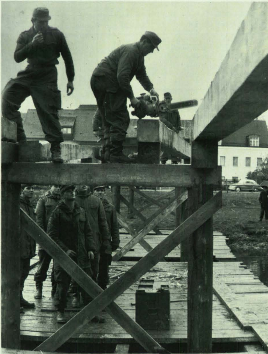
Bau einer Behelfsbrücke auf festen Stützen mit Arbeitsgerüst.
