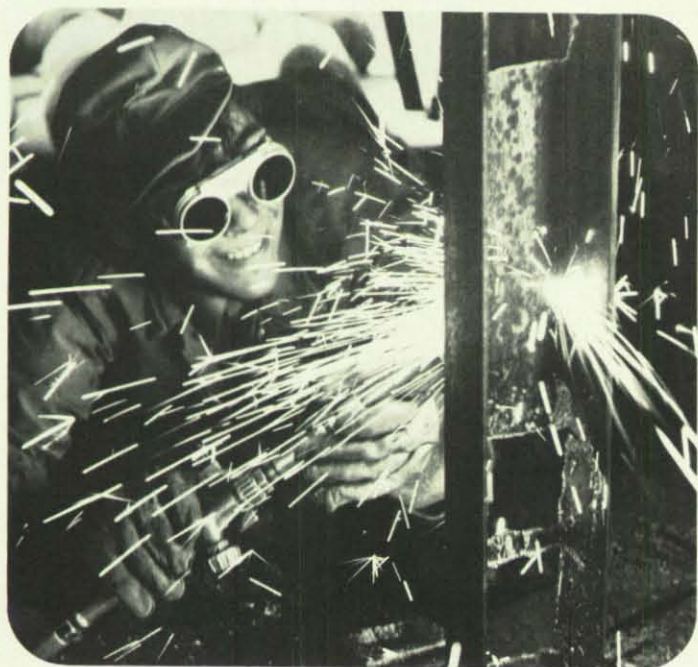
Beim THW oder an den Katastrophenschutzschulen werden Bergungsdienst-Helfer im Brennschneiden ausgebildet.
