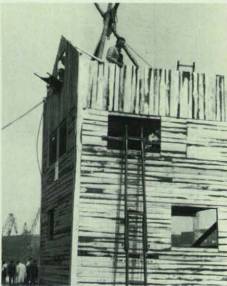
Die vom Ortsverband Neunkirchen errichtete Hausfassade.
