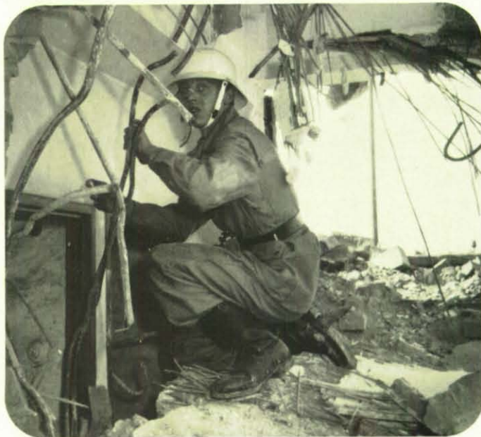
Helfer des Bergungsdienstes stoßen beim Vordringen in beschädigte Gebäude oft auf sperrige metallene Gegenstände, die mit Hilfe des Brennschneidegerätes beseitigt werden können.
