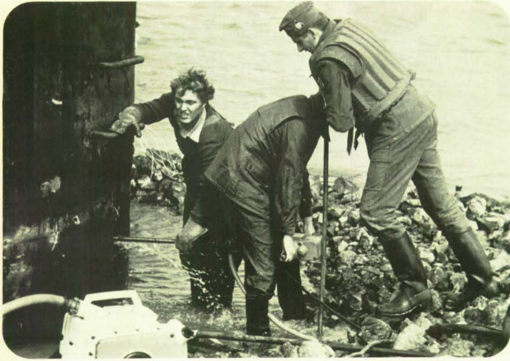
Die Bohrarbeiten für die Sprenglöcher dauerten länger als vorgesehen war. Alle Arbeitsphasen mußten während der Ebbe erledigt werden.
