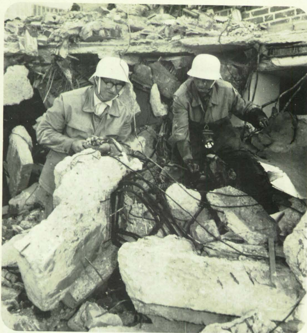
Erst wenn die Armierungseisen durchgetrennt sind, können die sperrenden Trümmer- teile einzeln aus dem Wege geräumt werden.
