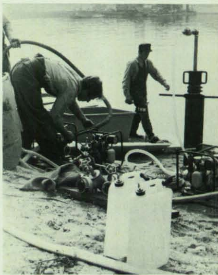
Heidelberg und Wiesloch bauten die Trinkwasseraufbereitungsanlage.
