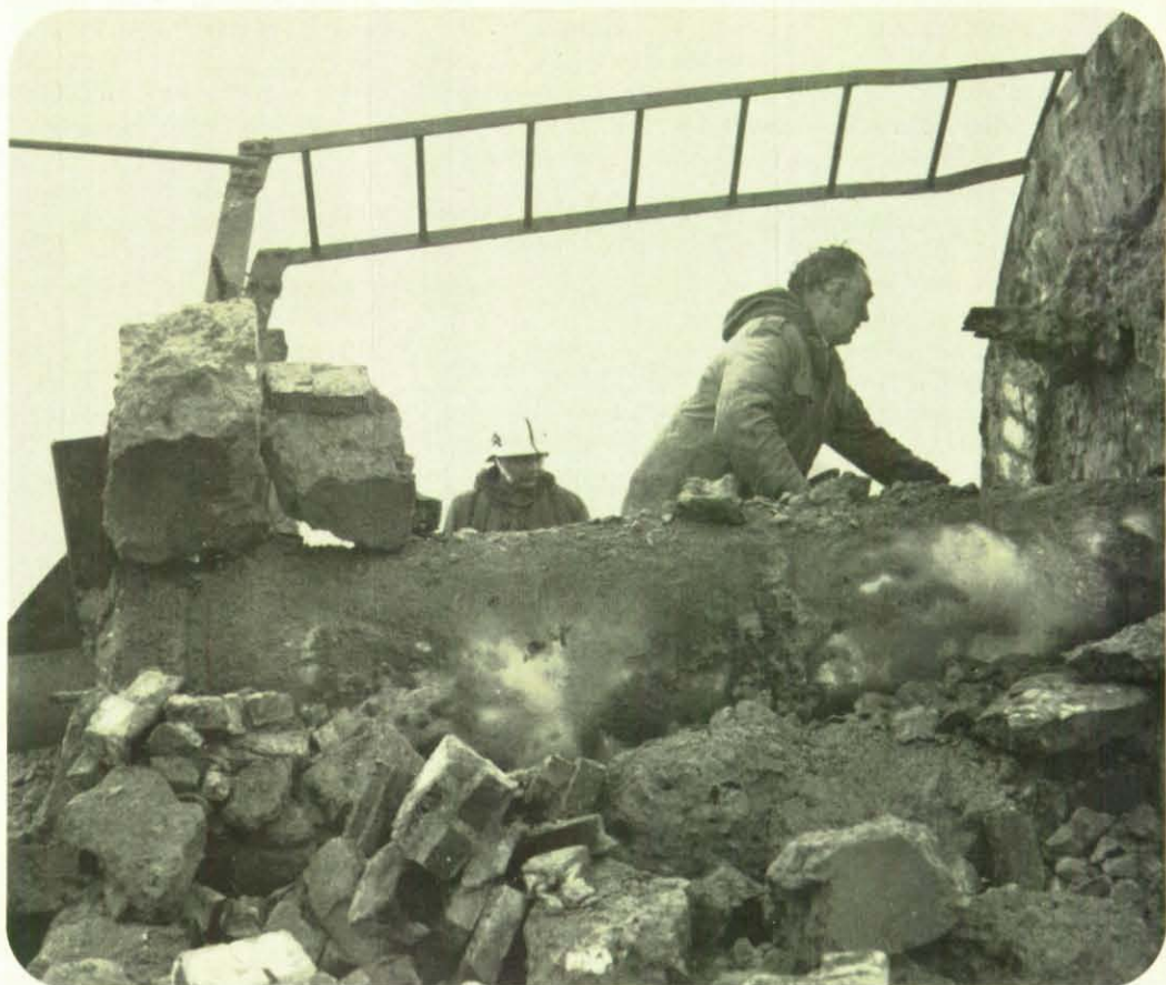
Nach der dritten Sprengung bot sich ein Bild der Zerstörung. Jetzt müssen die THW-Sprengmeister Bohrlöcher und Ladungen neu festlegen.
