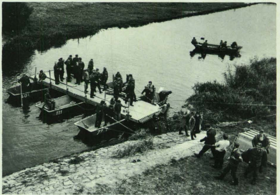
Die von Helfern der Ortsverbände Heide, Meldorf und Büsum gebaute 4-t-Personen-Fähre.
