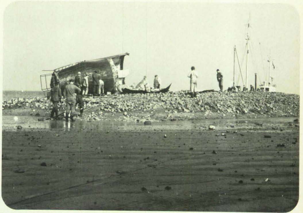
Nach der ersten, sehr erfolgreichen Sprengung war eine weitere notwendig. Die Männer waren mit dem Fortgang der Arbeit zufrieden.
