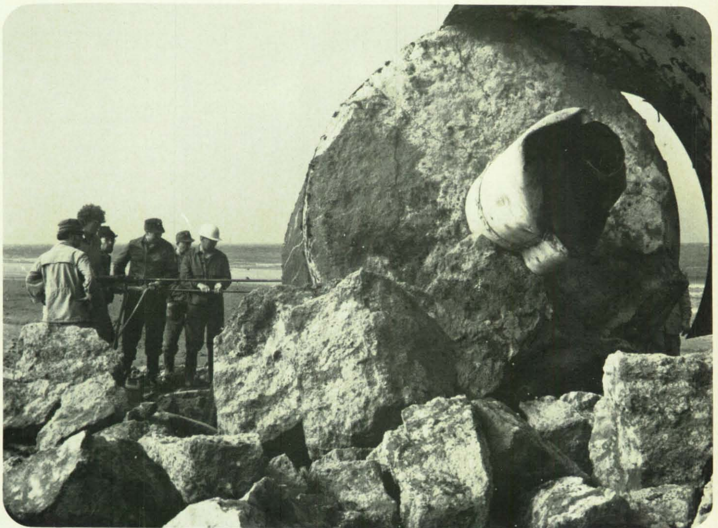
Bohrarbeiten für die dritte Sprengung. Im Vordergrund sieht man die Wirkung der vorausgegangenen Sprengungen. Bei Seezeichen ist Beton Gewichtsmasse, Festigkeit ist weniger wichtig.
