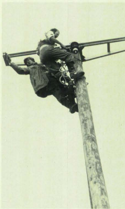
Der Ortsverband Ulm bei der Montage der Freileitung.
