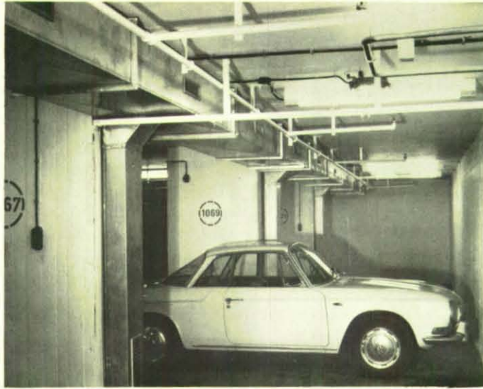
Diese Tiefgarage zeigt dem Benutzer nur wenig von ihrem Zweck, gleichzeitig als Schutzraum zu dienen.
