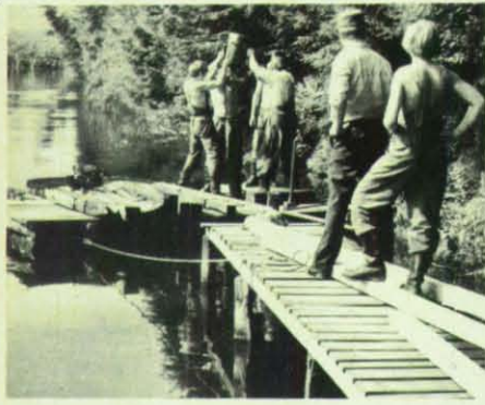
Das Rammen von Pfählen erfordert Kraft und kostet Schweiß.
