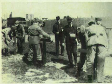
Binden eines Kreuz- und Bockschnürbundes
