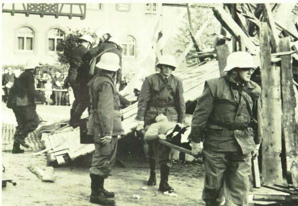
... und Verletzte aus Trümmerkegeln geborgen werden. Die richtigen Handgriffe zur richtigen Zeit bedeuten schnellste Hilfe in Gefahrensituationen.
