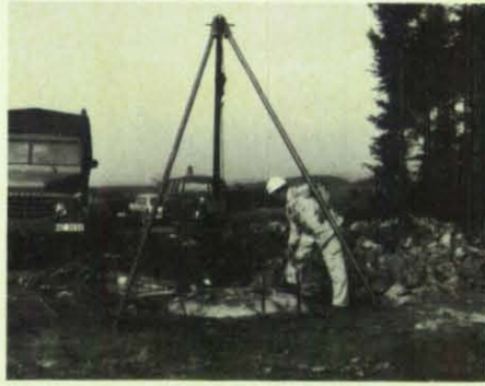
Mit Dreibock und Halteleinen wird das Material in den Brunnen abgelassen.
