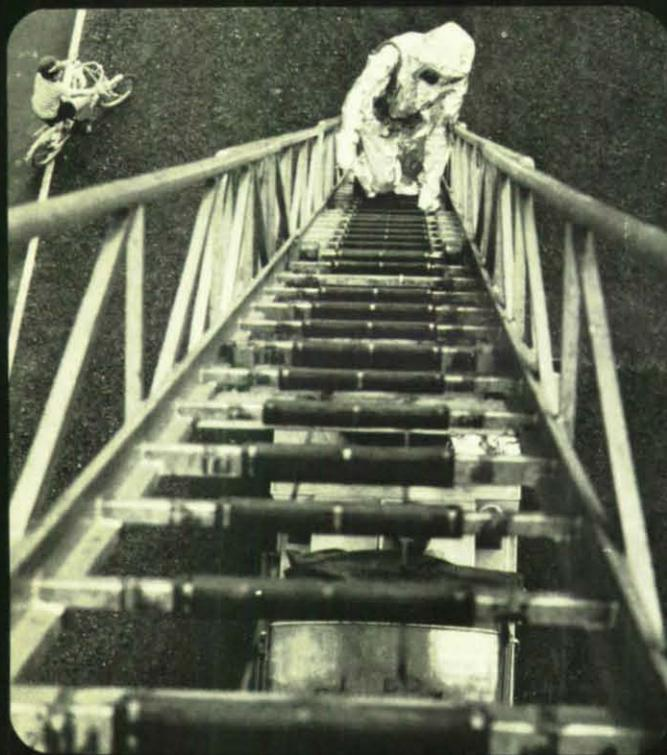
Manche Hitzeschutzanzüge sind auf dem Rücken mit einer Hülle versehen, die das Mitführen eines Atemschutzgerätes ermöglicht. Es gibt jetzt auch Rettungsdecken, gefertigt aus einem nicht entflammaren, hitzebeständigen Material, einflächig oder aus einem mehrschichtigen Verbund, mit Trageschlaufen. Damit ist auch den Rettern die Möglichkeit gegeben, den zu Rettenden gegen intensive Strahlungshitze und direkte Flammenberührung zu schützen.
