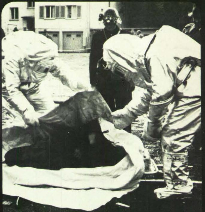
Die Trage, auf der hier zu Demonstrationszwecken eine durch eine Rettungsdecke geschützte Person wird, ist die deutsche Einheitstrage nach DIN 13024 aus Leichtmetall. Der Bezug ist aus hitzebeständigem und mechanisch festem Gewebe. So bietet die Hitzeschutz-
