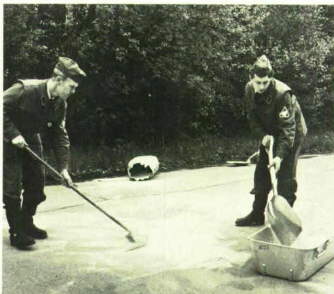
**Mit Ölbindemitteln kann man z. B. Ölsuren auf Wasser oder auf Fahrbahnen beseitigen. Hat sich das Mittel voll Öl gesaugt, wird es wieder zusammengefeßt, in Behältern abtransportiert und verbrannt.**
