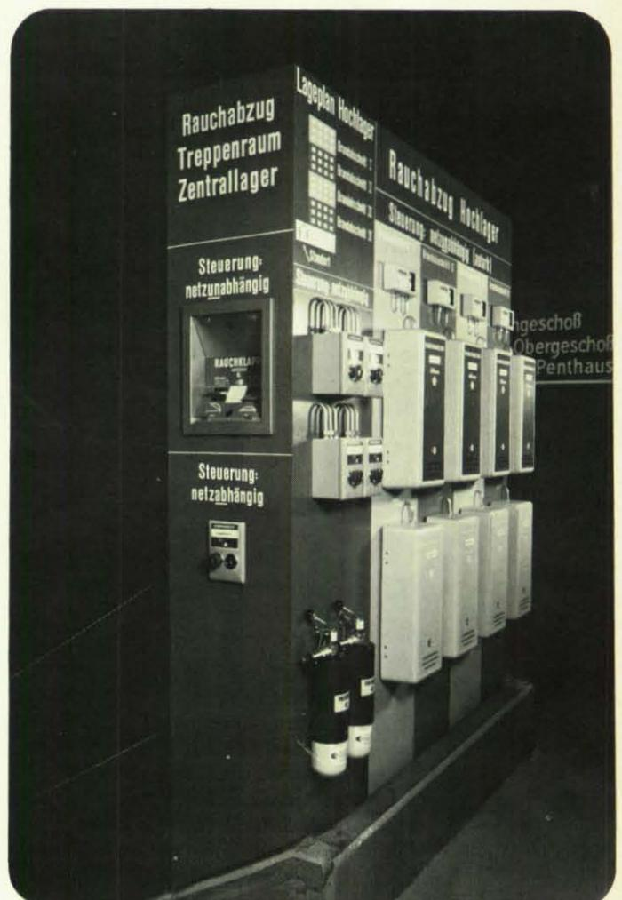
**Bedienungselemente für Rauchabzug und Lüftung in einer Großanlage.**
