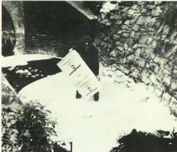
Hier war Öl nach einem Unfall in einen Bachlauf geraten. Es wurden Sperren errichtet, um das auf der Oberfläche schwimmende Öl zu stoppen. Dann wurde das Öl mit wasserabweisenden Mitteln gebunden und abgeschöpft.
