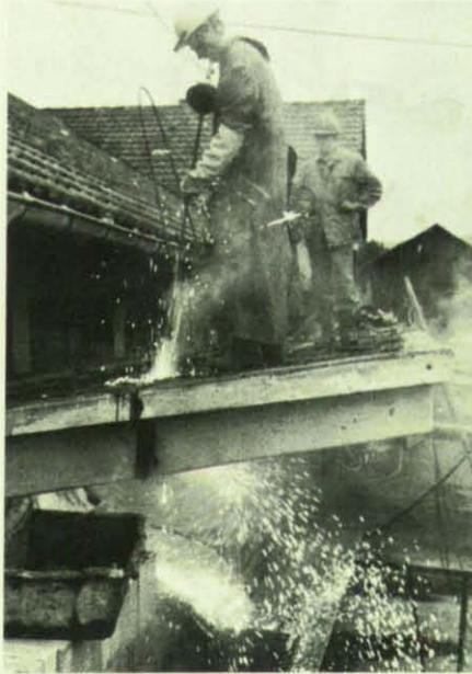
Mit der Sauerstofflanze brannten THW-Helfer ein 30 cm dickes und 12 m langes Betondach ab.
