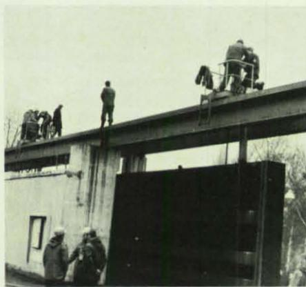
**Das Hochwassersperrtor muß auf beiden Seiten im gleichmäßigen Takt hochgekurbelt werden, sonst würde es verkanten.**
