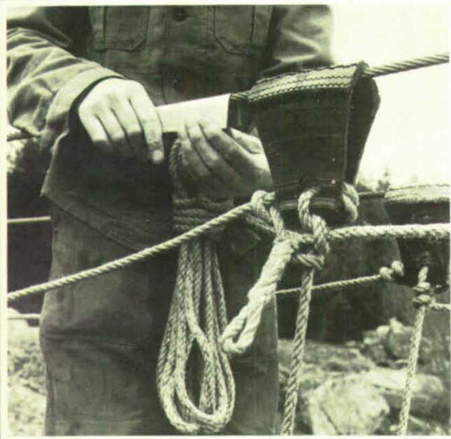
Als ein Mittel der Improvisation, so ein Vorschlag der Schule, können zum Einhängen der Seile anstelle von Schäkeln auch Segmente aus alten Autoreifen verwandt werden.
