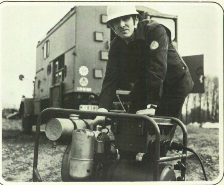
Das Notstromaggregat versorgte den Gesteinsbohrhammer mit Strom.
