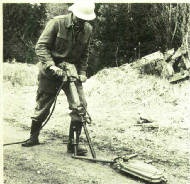
Ein Werk von Sekunden: Herstellung eines Befestigungspunktes für den Greifzug mittels maschinell eingetriebener Erdankernägel und einem oder mehreren Anschlagstücken.
