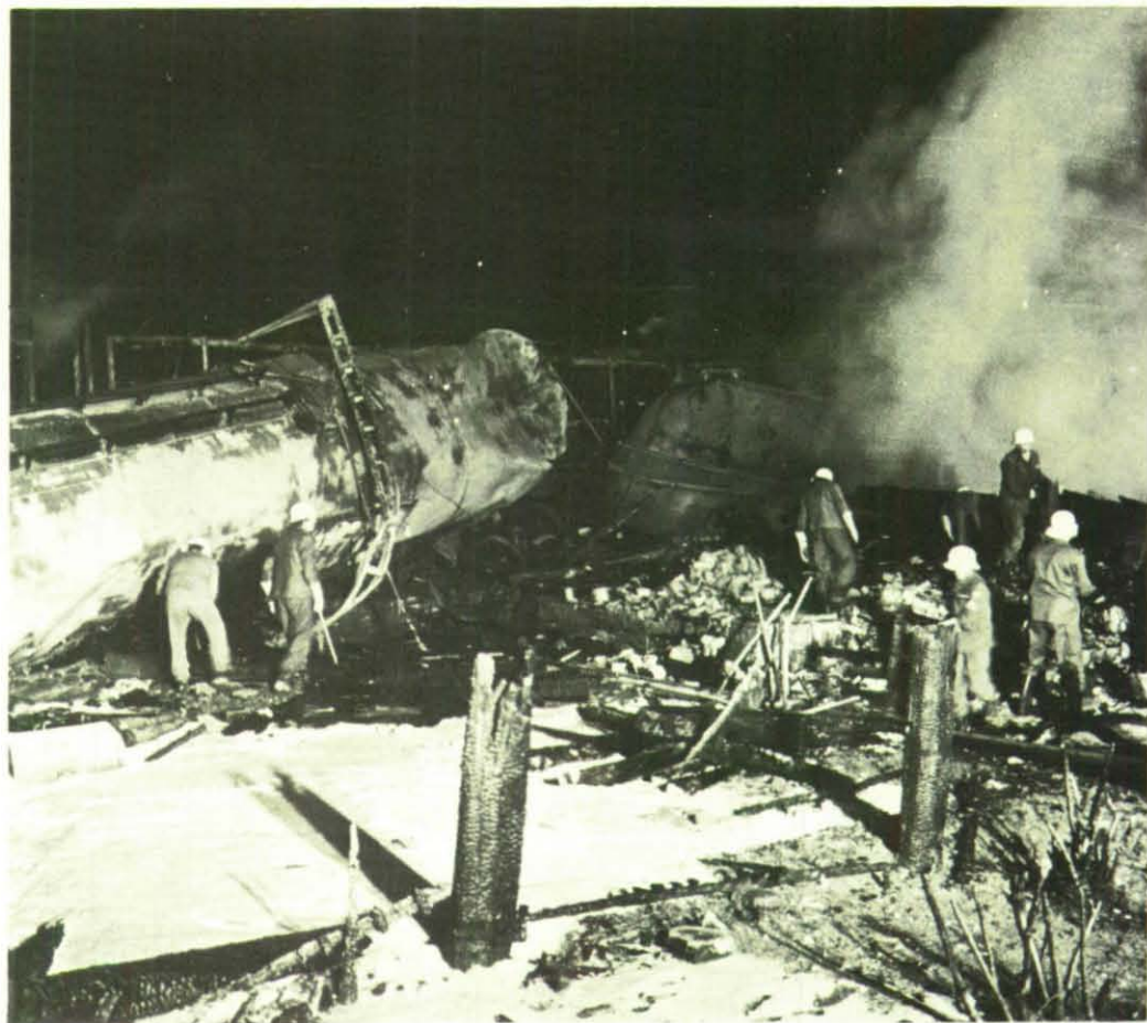
Von dem ehemaligen Bahnwärterhaus blieben nur verkohlte Balken übrig.
