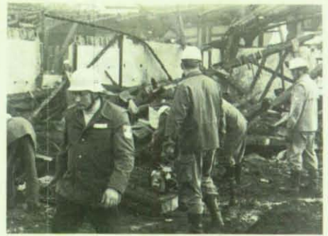
THW-Helfer bei Aufräumarbeiten nach einem Großbrand.
