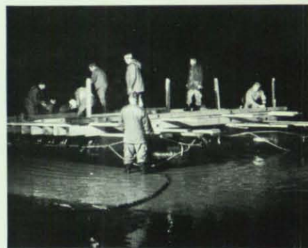
Nächtlicher Fährbau auf der Donau.
