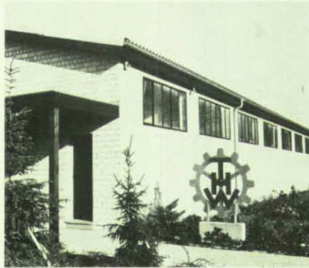
Nach jahrelangen, provisorischen Unterkünften hat nun der OV Bühl eine eigene, neue Unterkunft.
