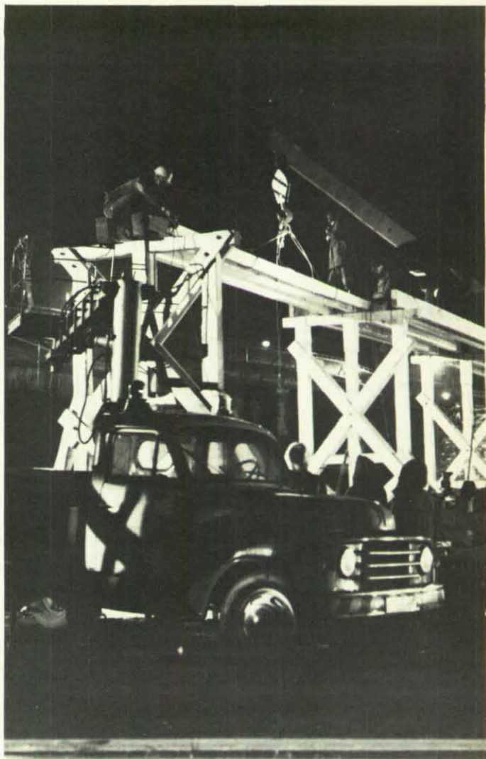
Mit dem Auflegen der Bohlen ist der Aufbau einen Schritt weitergekommen.
