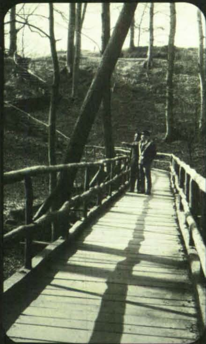
Brücke und Zuwege wurden von 45 Helfern in vier Tagen erstellt.
