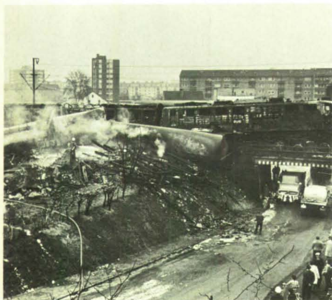
Blick auf die Unfallstelle am folgenden Morgen. Letzte Brandnester schwelen noch und werden abgelöscht. Jetzt beginnen die Aufräumarbeiten.
