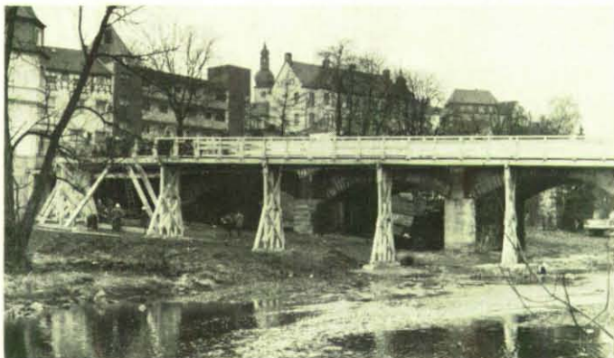
Die Behelfsbrücke über die Ruhr steht dicht bei der Klosterbrücke (im Hintergrund).
