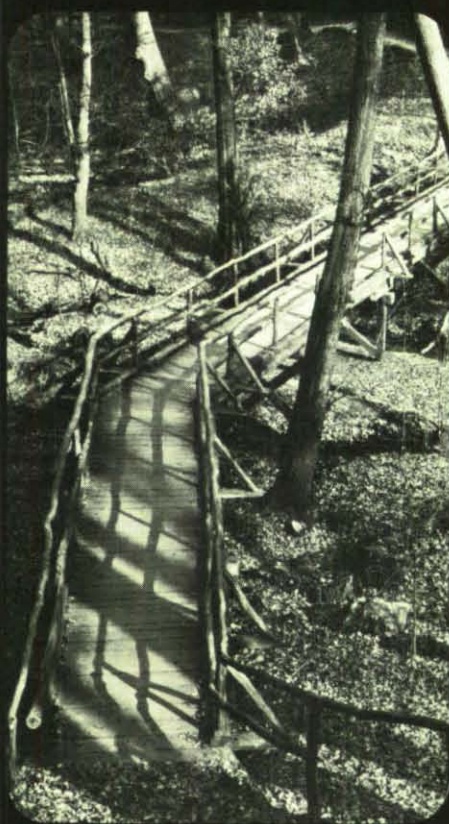
Blick auf die fertiggestellte Fußgängerbrücke.
