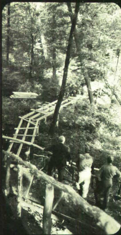
Fußgängerbrücke über die Eyter-Quellen im Bau.
