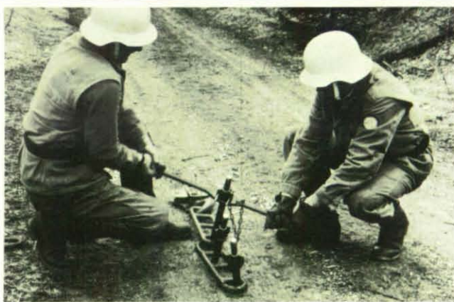
Mit den aufgesetzten und gesicherten Wend- und Zieh-eisen können Helfer durch Drehen und Ziehen selbst tief eingeschlagene und festsitzende Erdankernägel wieder lösen.
