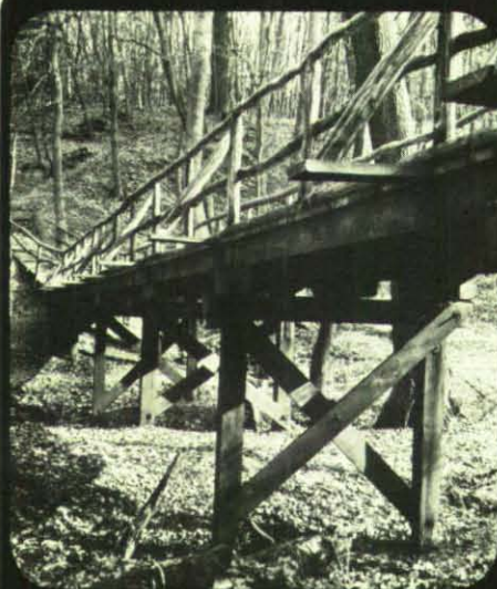
Die Brücke steht auf Pfahljochen: eingerammt mit der Dieselramme.
