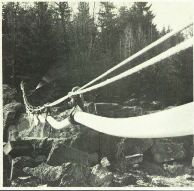
Während die Schlauchleitung in den Segmenten ruht, hängen die Schäkel, mit denen sie verbunden sind, am Drahtseil, wo sie durch Distanzleinen im gewünschten Abstand gehalten werden.
