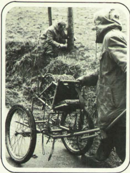
Die Fernmelder hatten insgesamt 300 m Feldkabel im Hoch- und Tiefbau zu verlegen. Dabei war der Einsatz des Fernsprechkarrens zwingend vorgeschrieben.
