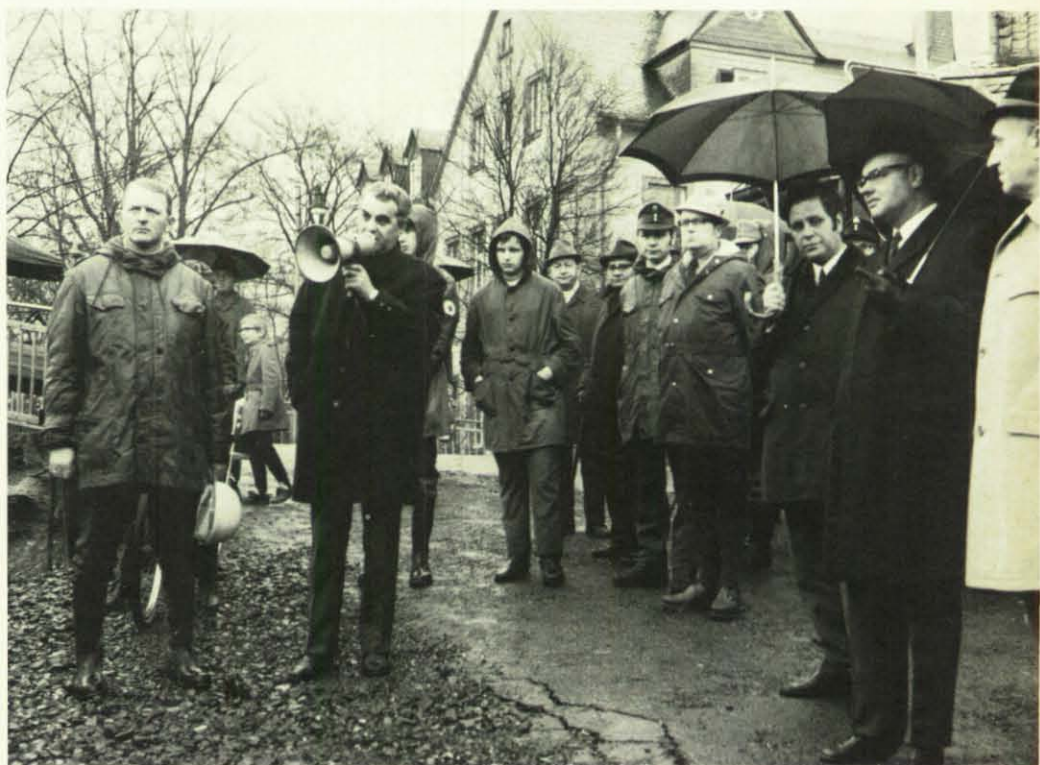
Bürgermeister Rupp dankt den Männern für den Brückenbau. Links: Ing. Heitmann.
