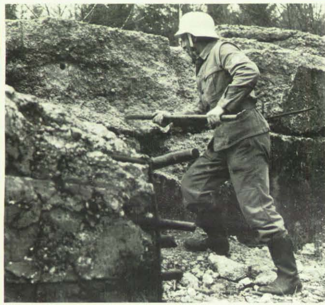
Die übliche Brechstange hat gegenüber der Spitze eine Klaue. Darum kann man sie nicht mit dem Hammer einschlagen. Mit den Erdankernägeln mit Wend- und Zieheisen ist dies jedoch kein Problem.
