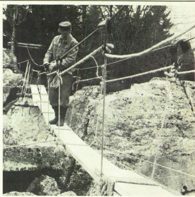
Zum Überwinden von Schluchten, Wasserläufen oder sonstigen unübergehbaren Stellen baut der Bergungsdienst u. a. Hängestege mit doppelt oder einfach gelegten Laufbohlen.
