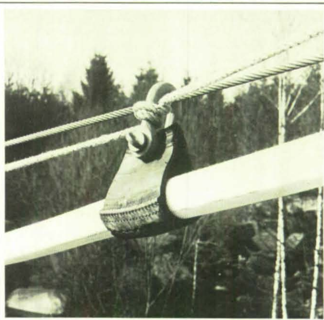
Die Segmente kann man mit einer Kabelschere und einer Metallsäge aus den Reifen heraus schneiden. Diese Arbeit und das Stanzen des Lochs dauern höchstens drei Minuten pro Segment.
