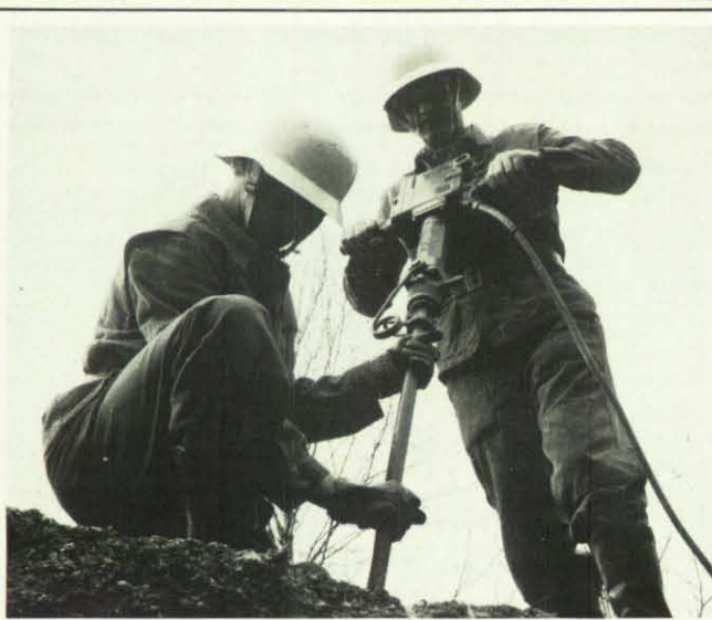
Durch Einsetzung des Erdankernagels erhält man einen provisorischen Aufreißhammer.
