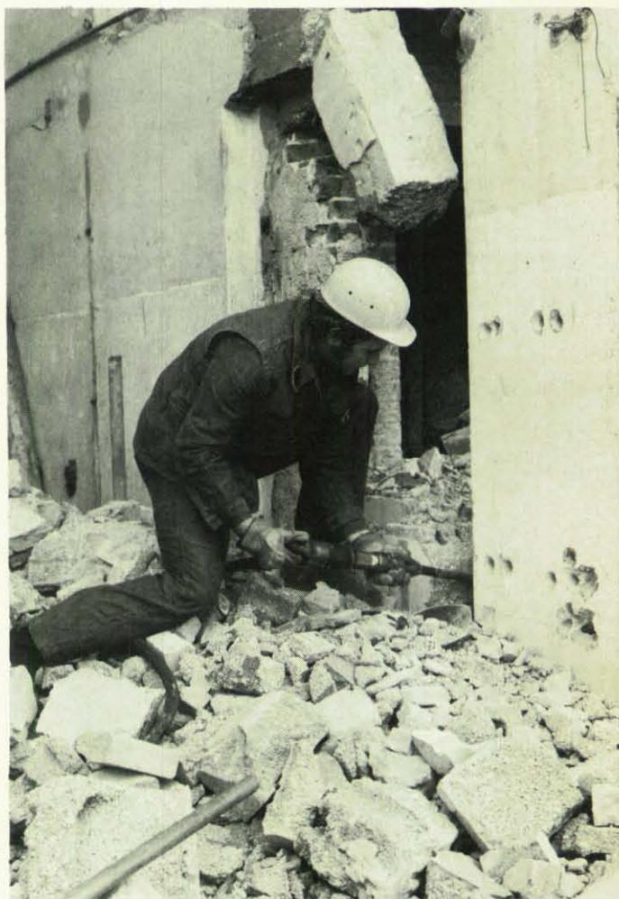
Freilegen der Armierungseisen in den Stützen.
