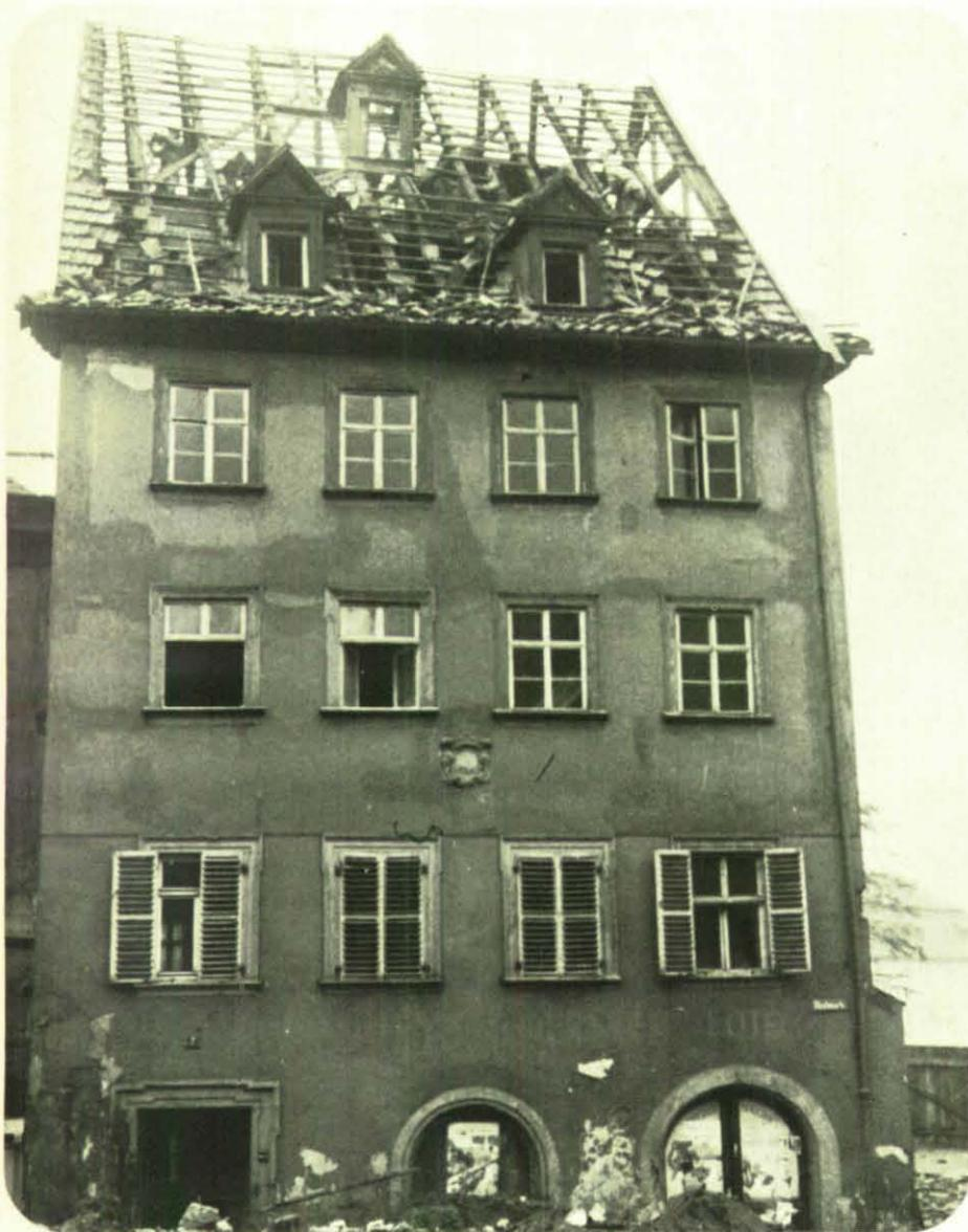
Das 1540 erbaute Haus. THW-Helfer entfernen die Dachziegel.
