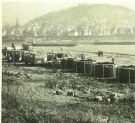
Eine komplette Trinkwasseraufbereitungsanlage in Betrieb am Flußufer.
