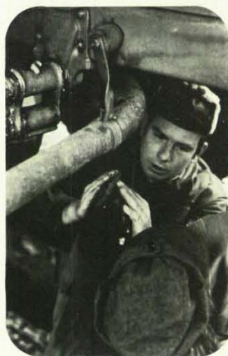
Die mechanische Überprüfung der Bremsanlage auf Verkehrssicherheit schließt auch ein, die Bremsleitungen und ihre Verbindungen sowie die Bremsschläuche auf Scheuerstellen, undichte Stellen und ordnungsgemäße Befestigung zu überprüfen. Hier entwässert ein Fahrer den Druckluftbehälter der Bremsanlage. (Foto unten)
