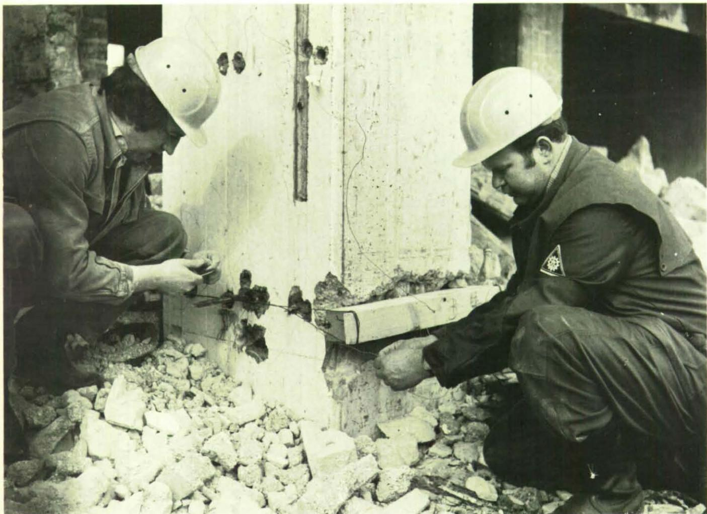
Anbringen der Schneidhohlladungen an die zu sprengenden Stützen.
