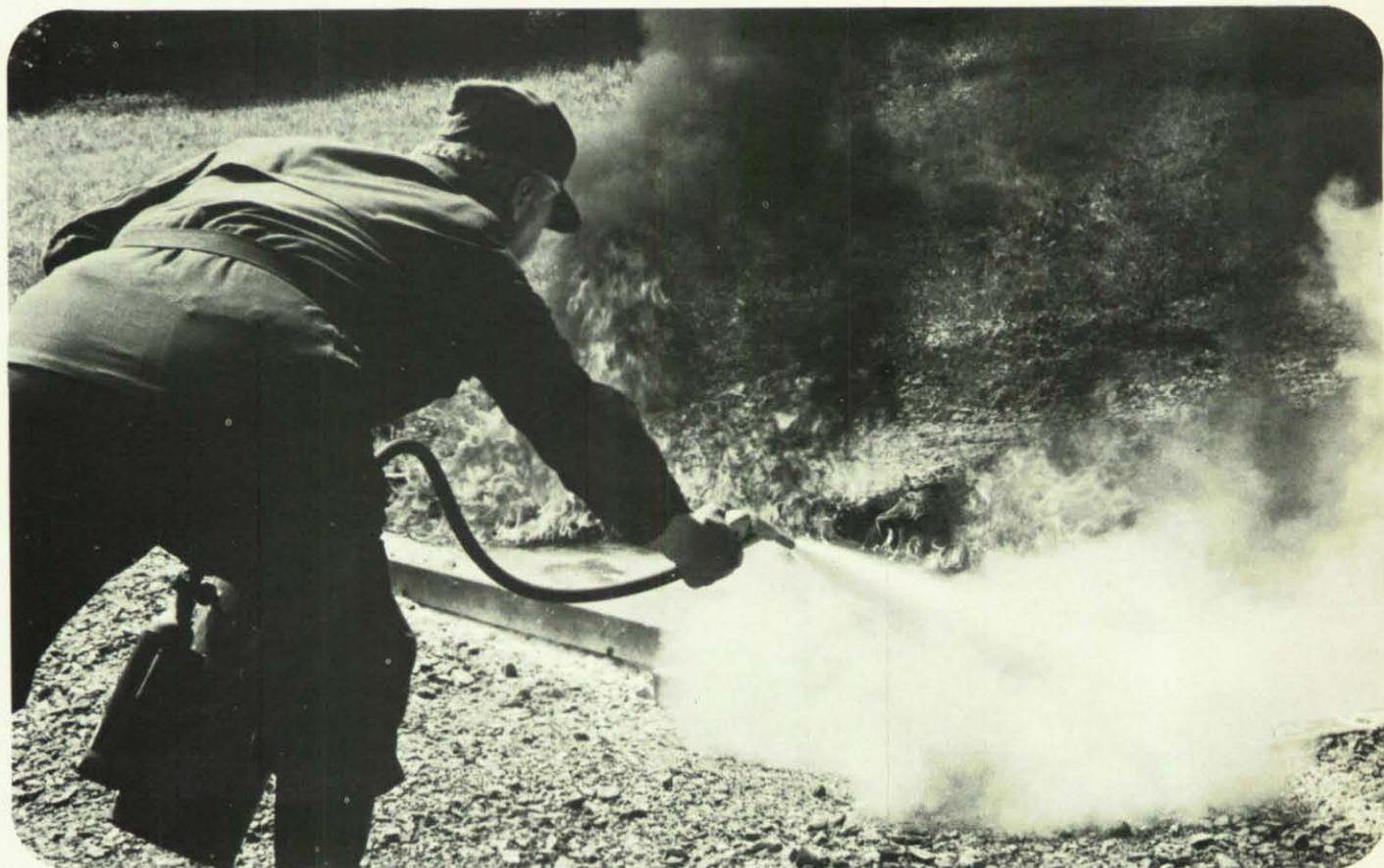
**Rasch und richtig eingesetzt, kann durch einen Trockenpulverlöscher ein Entstehungsbrand gelöscht werden.**
