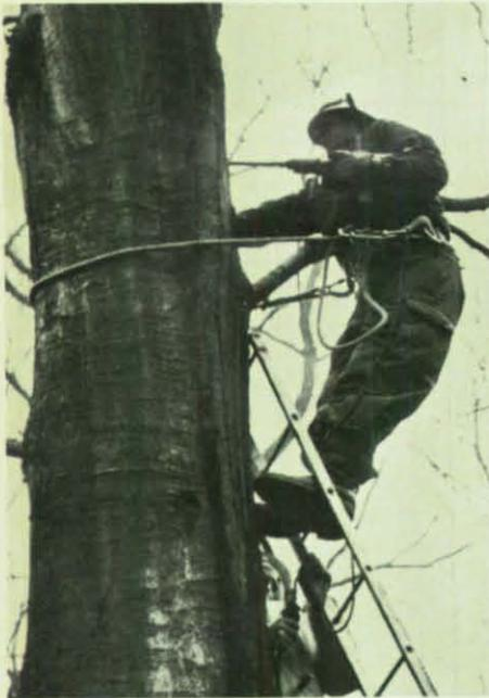
**Bohren der Sprenglöcher in 6 m Höhe**
