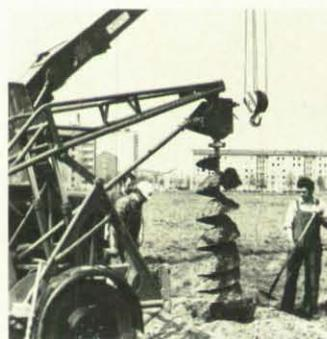
Mit Hilfe dieses Bohrgerätes waren die Löcher für die Masten schnell hergestellt.
