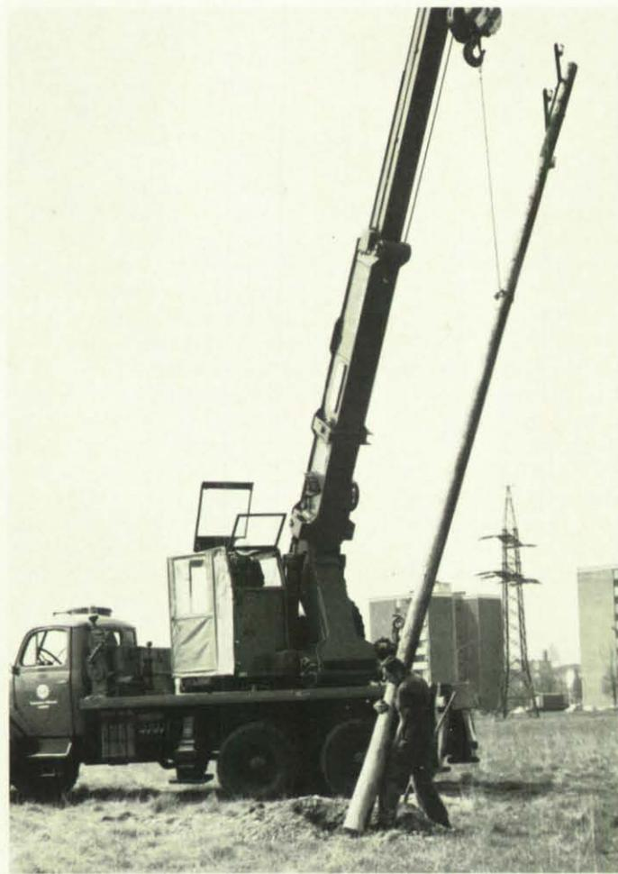
Beim Aufsetzen der Leitungsmasten half ein Autokran.
