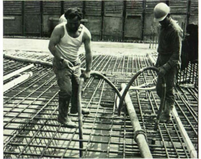
Der erste Beton wird eingebracht.
