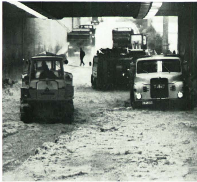
In diesem Tunnel mußten mehrere Personen aus eingeschlossenen Kraftfahrzeugen befreit werden.
