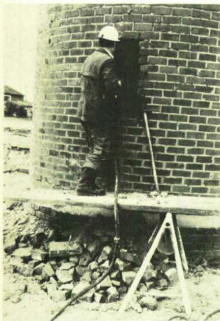
Einer der Fallschlitze wird gebohrt.
