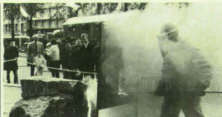
Jede THW-Ausstellung, die etwas auf sich hält, führt die bei vielen Hilfeleistungen bewährte Sauerstoff-Lanze vor.
