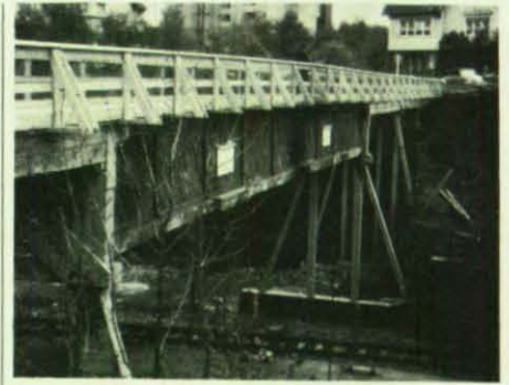
Die 62 m lange Brücke — ein Gemeinschaftswerk der sieben Ortsverbände — ist fertiggestellt.
