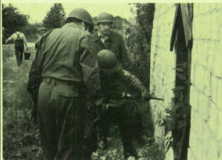
Eine harte Arbeit: Mauerdurchbrüche (Fotos: Marineamt)
