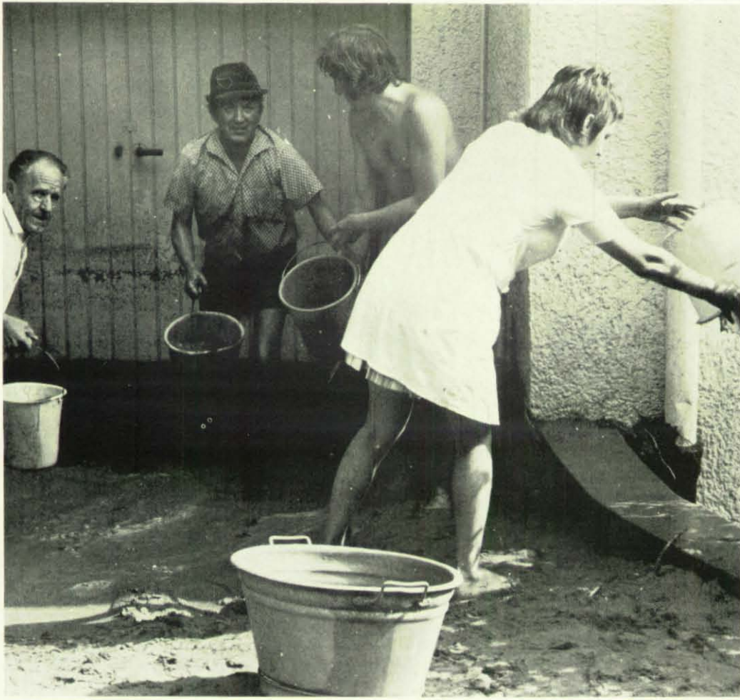
Durch Selbsthilfe und Nachbarschaftshilfe gingen die von den Folgen des Unwetters betroffenen Bewohner an die Beseitigung von Wasser und Schlamm.
