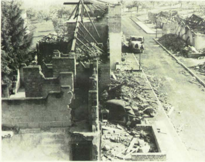
Die Ausrüstung der Bundesschule des Technischen Hilfswerks in Ahrweiler hinsichtlich der Übungsanlagen und technischen Übungsstationen ist vorbildlich. Das Foto gibt die Teilansicht der Trümmerstraße in Ahrweiler wieder.
