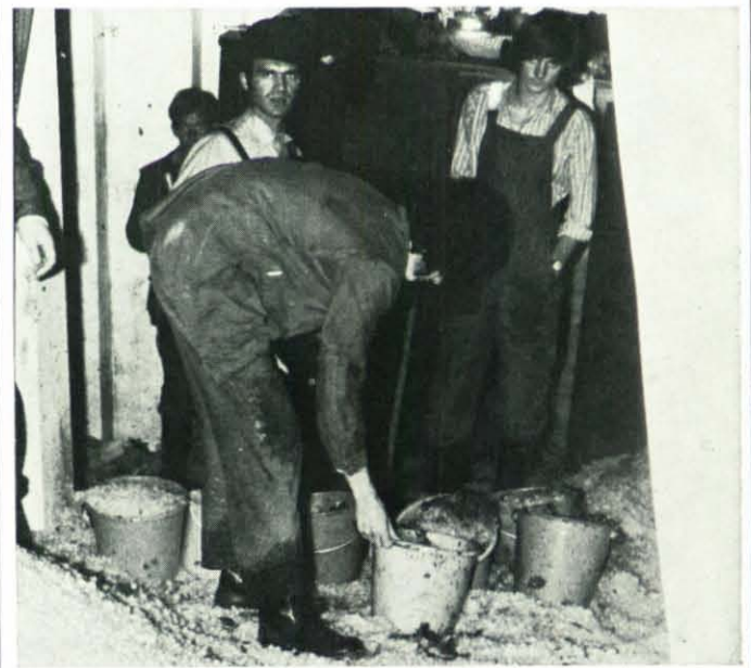
Helfer des Technischen Hilfswerkes beseitigen angeschwemmten Hagel aus einer Wohnung.
