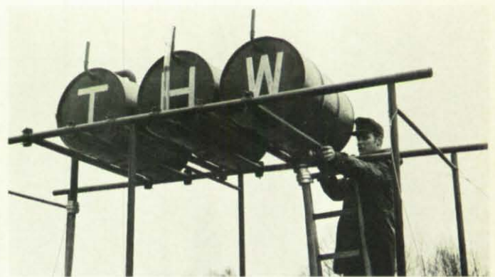
Die Ausbildung im THW zeichnet sich u. a. auch dadurch aus, daß die Helfer Behelfsmaßnahmen erlernen — wie z. B. den Bau eines Trinkwasserhochbehälters — die gerade in Katastrophenfällen von lebenswichtiger Bedeutung sein können.
