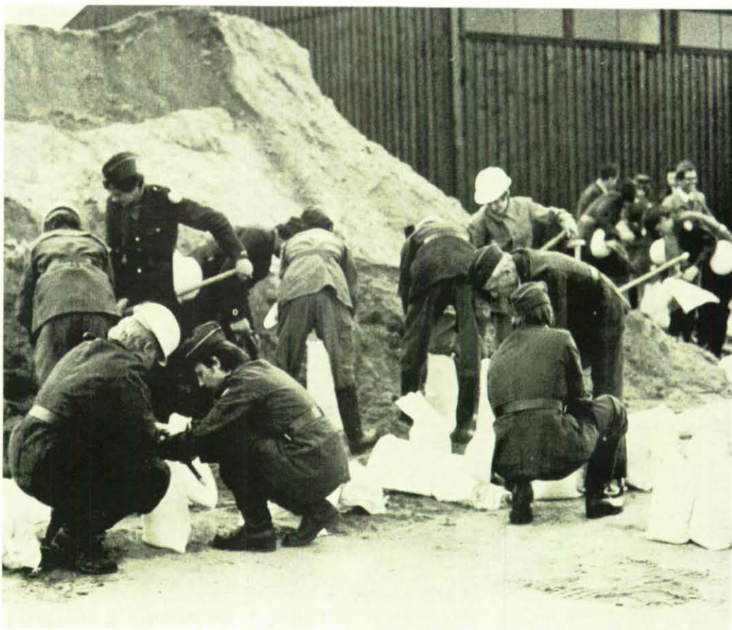
Das wichtigste Arbeitsmaterial beim Schließen von undichten Stellen in Deichen sind Sandsäcke. Hier sind Helfer mit dem Abfüllen und Bereitstellen der Säcke beschäftigt.
