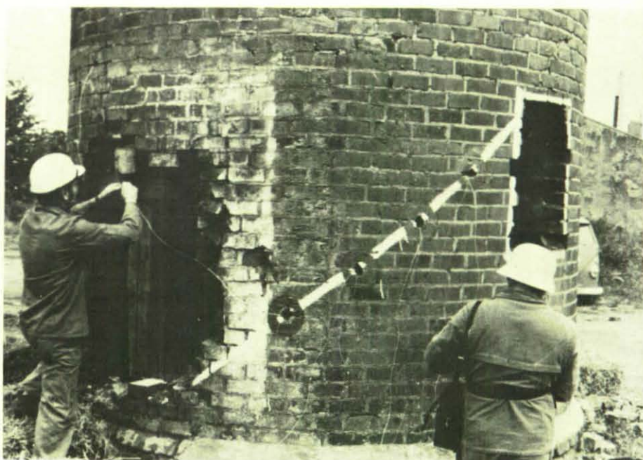
Man erkennt deutlich die V-förmige Anordnung der Bohrlöcher.
