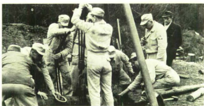
Hier wird das Verlegen einer 500-mm-Großdruckrohrleitung geübt. Zur Ausbildung im Instandsetzungsdienst gehören alle Arbeiten für die Hilfeleistung bei der Instandsetzung von Netzen der Strom-, Gas- und Wasserversorgung sowie der Wasserabführung.
