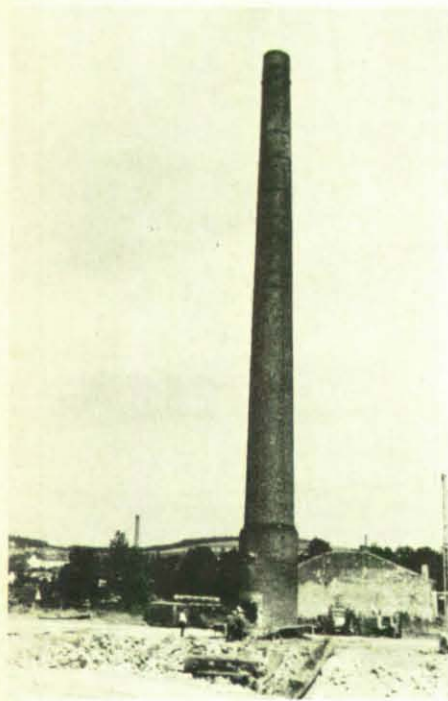
Das Objekt der Sprengung.
