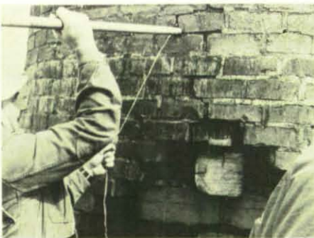
Helfer besetzen die Maulbohrlöcher.
