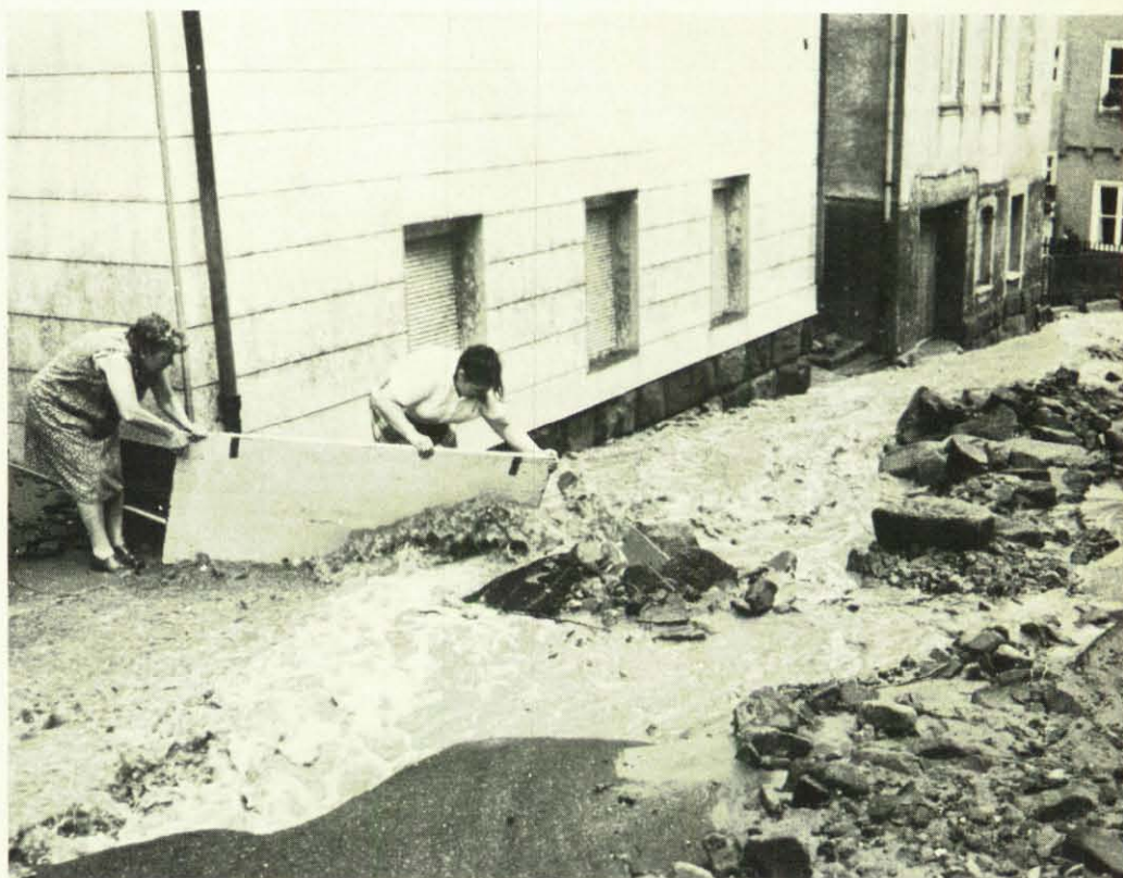
Die große Flut ist vorüber. Hausbewohner versuchen, das Wasser, das immer noch in die Kellerräume fließt, abzuleiten.
