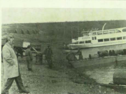
Außer den alten Fässern wurden auch Autowracks und alte Öltanks beseitigt.
