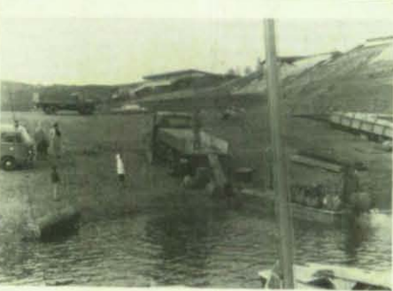
Was soeben noch die Ufer des Rursees verunzierte, wird hier auf LKW verladen und abtransportiert.
