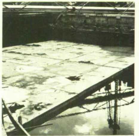
Nach Beendigung der Bauarbeiten wird der Schacht vom Wasser bedeckt sein.
