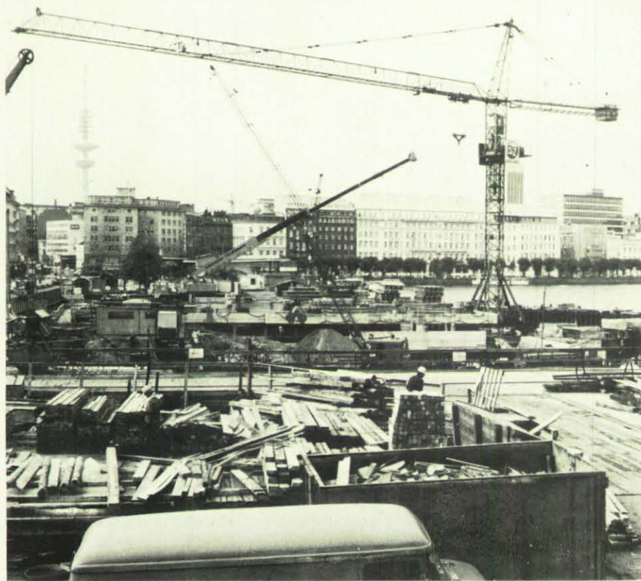
Blick über die Baustelle Jungfernstieg.
