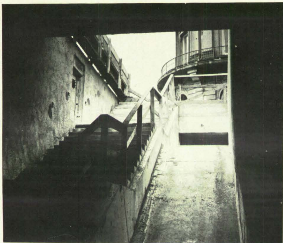
Das Foto bietet einen Blick auf den Abgang zur Schalterhalle. Rechts wird später eine Rolltreppe installiert.
