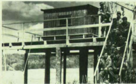
Die Beobachtungshütte am Ammersee wurde vom OV Weilheim ausgebessert und erweitert.
