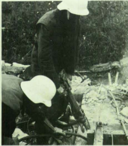
Abbrucharbeiten wurden mit dem Gesteinsbohrhammer bewältigt.
