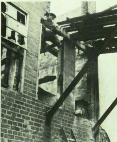
Brennschneiden in luftiger Höhe.
