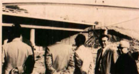
Die im Bau befindliche Bonner Südbrücke war Treffpunkt und erstes Besichtigungsobjekt.
