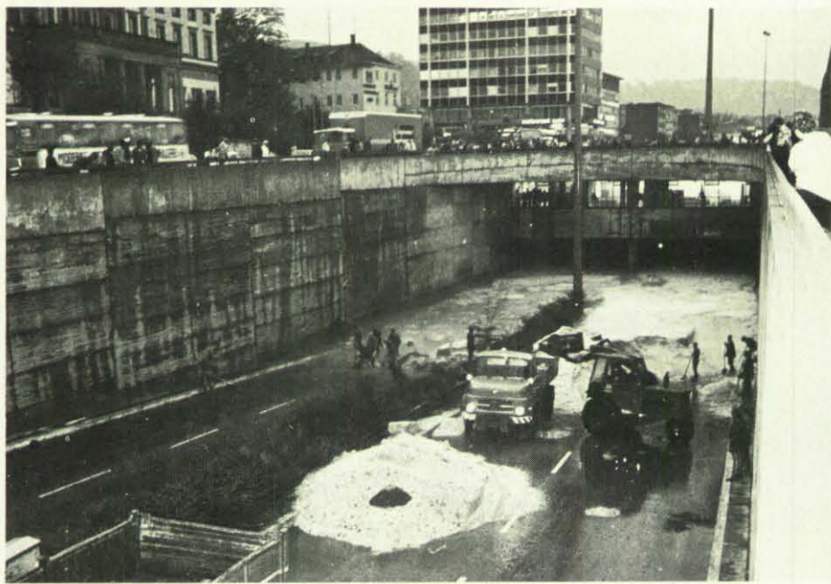
Straßenunterführungen wurden zu Autofallen.
