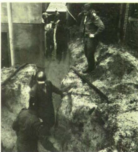
Eismassen versperren Hauseingänge.
