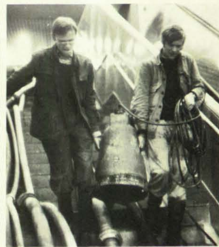
THW-Helfer bringen eine Elektrotauchpumpe zum Einsatz.
