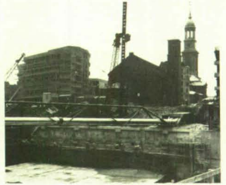
Der S-Bahn-Schacht durchquert einen Fleet. Im Hintergrund der Hamburger Michel.
