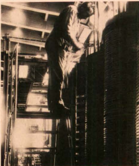
Von großen Trittleitern aus werden die Transformatoren montiert.
