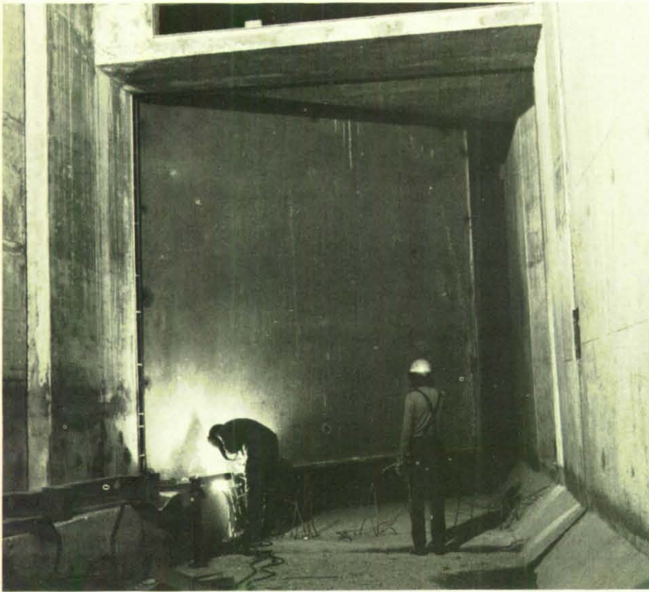
Im Schutzfall muß der Bahnsteig durch Tore gasdicht verschlossen werden.
