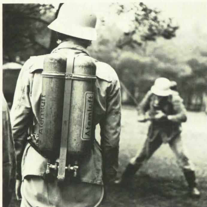
Das Rückentragegerüst, an dem alle Geräteteile außer dem Lungenautomaten befestigt sind, ist so konstruiert, daß es dem Träger ein Höchstmaß an Bewegungsfreiheit erlaubt.
