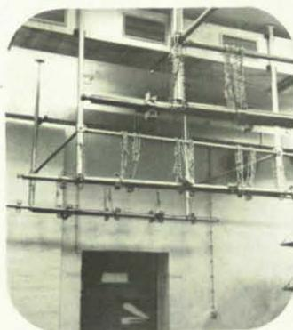
Mit Hilfe dieser Konstruktion bleiben die hochgezogenen Bettgestelle auch während der Nutzung der Mehrzweckanlage als Garage an Ort und Stelle. Im Hintergrund eine Schleusentür.
