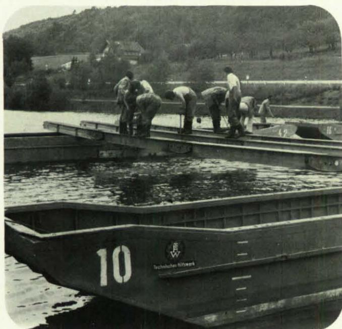
Aus vier Pontons wurde eine Fähre gebaut. Die Schwimmbrücke war aus vier solcher Fähren zusammengesetzt.
