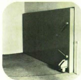
Durch diese Öffnung kommen die PKW in die Garage hinein und verlassen sie wieder. Sie müssen dabei einen Bogen von 90 Grad schlagen. Im Ernstfall muß diese Öffnung wie eine Umfassungswand verschlossen werden. Das Tor muß also trümmersicher, strahlensicher und gasdicht sein und einen ausreichenden Wärmeschutz bieten. Um eine geringe Dicke zu erhalten, wurde dieses Tor mit Barytt-Beton verfüllt.
