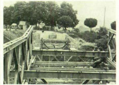
Einwandige Brücke mit zwei Unterstützungen. Die Schnabelspitzen befinden sich vor dem ersten Gleitlager. Auf dem rechten Gleitlager sitzen zwei Helfer. Beim Vorziehen der Brücke stehen sie auf der Arbeitsbühne der Unterstützung. Das Foto entstand in einer Arbeitspause, daher tragen die Helfer keinen Schutzhelm.
