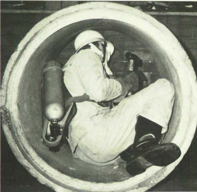
Das Durchstemmen einer Mauer mit Hammer und Meißel unter Atemschutz und in beengten Verhältnissen kann zur Strapaze werden. Darum ist bei längerer Einsatzdauer und schwerer Arbeit eine Ablösung sicherzustellen.
