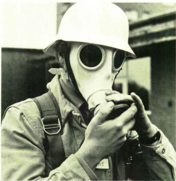
**Hier wird der Lungenautomat in den Filteranschlußstutzen der Schutzmaske geschraubt. Beim Einatmen entsteht in der Maske ein Unterdruck, der ein Ventil öffnet, durch das eine genau dosierte Luftmenge einströmt.**
