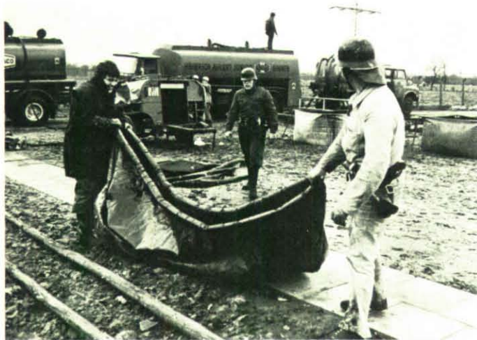
Aufgefangenes Öl wird zu den Tanklastzügen getragen.
