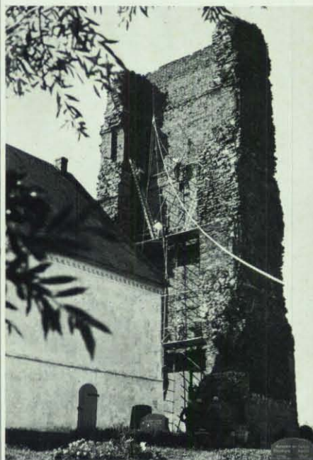
Helfer beim Bau der dritten Plattform an der Turmruine auf Pellworm.
