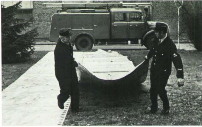
**Demonstration eines neuen Schutzsystems gegen Überschwemmungen. Sperrschläuche werden ausgerollt.**
