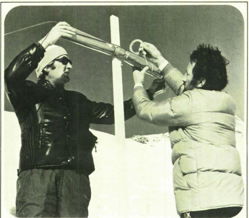
Die für eine Schneefeldsprengung hergerichtete Stange mit Sprengsatz (Ammonit 3) wird vom Sprengkommando an Ort und Stelle aufgesetzt und sprengbereit gemacht.
