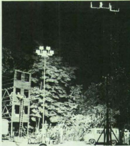
**Der Beleuchtungsträger „Giraffe“ und die fahrbare Fluchtlichtanlage „Giralux“ beleuchten die Schadensstelle.**
