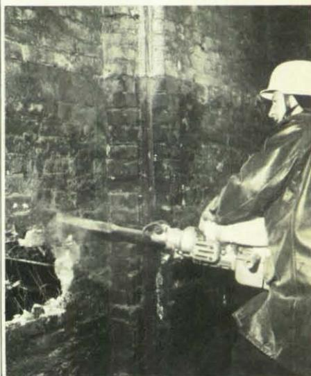
kasten, Werkzeugsatz, Kraftstoffbehälter usw.), gibt es noch ein großes Werkzeugsortiment für verschiedene Arbeitsaufgaben. Ein Test anlässlich einer Katastrophenschutzübung in einem größeren Kölner Werk ergab, daß sich dieser kompressorunabhängige Universalhammer gut für Mauerdurchbrüche, also zu einem schnellen und wirkungsvollen Rettungseinsatz eignet.
