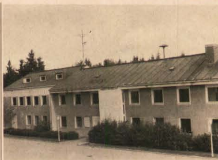
Zivilschutzsirene E 57 nach DIN 41096 auf dem Dach eines Gebäudes.
