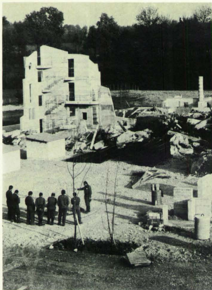
In der Schweiz gibt es 70 kantonale und regionale Ausbildungszentren des Zivilschutzes. Hier ein Blick auf den Trümmerbereich zur realistischen Ausbildung im ZS-Zentrum des Kantons Luzern in Sempach.
