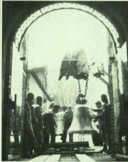
Zwei 3,3 bzw. 1,2 to schwere Glocken transportierten Helfer des THW bis unter die Orgelempore des St.-Petri-Domes in Fritzlar.
