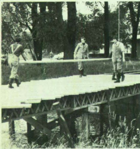
Bau einer 8-to-Brücke.
