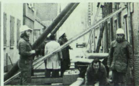
THW-Helfer stützen die Fassade des unterspülten Hauses ab.
