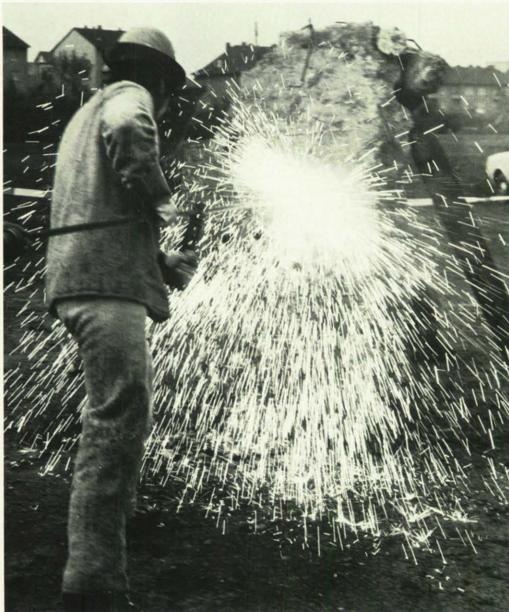
Demonstration an einem Betonklotz.
