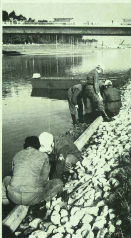
Hier umwickeln Helfer Kanthölzer mit PVC-Folie.
