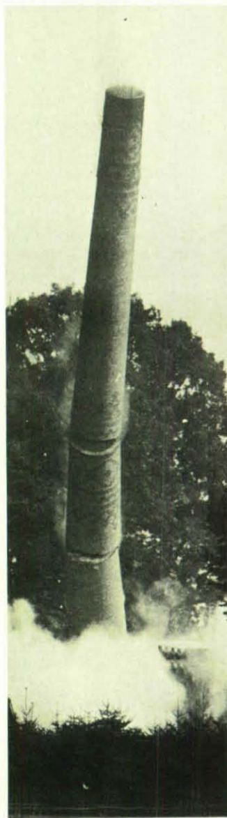
Sprengung eines Kamins
