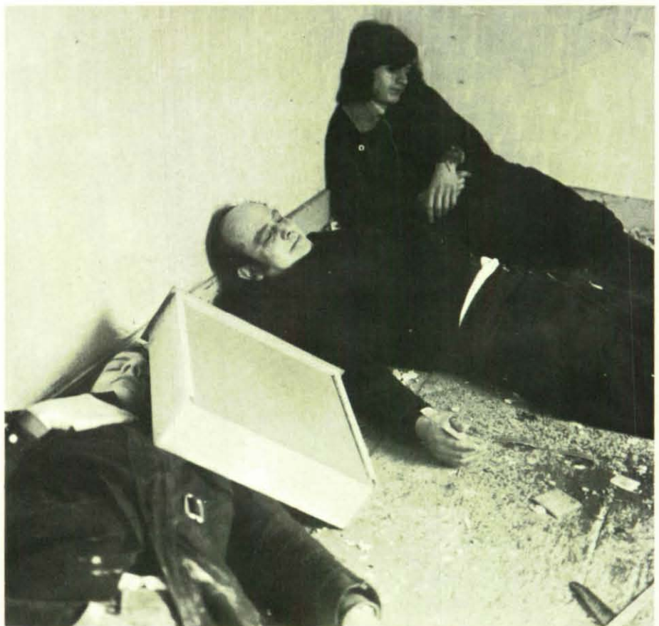
Dieses Bild bietet sich den Rettungstrupps, als sie das vom Sturm schwer beschädigte Haus betreten.
