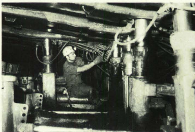
Ein Bergmann im Streb mit Rahmenausbau in der Grube „Emsdorf“ der Saarbergwerke AG. Ein Hebeldruck genügt zur Auslösung der hydraulischen Ventile — die Ausbaugestelle bewegen sich vorwärts und drücken an das Hangende.
