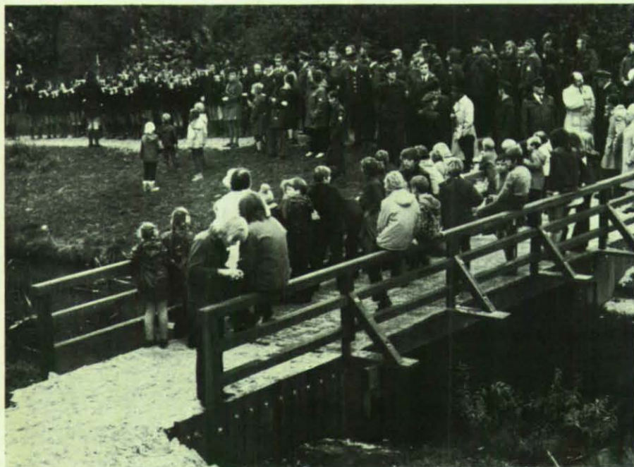
Die Gartenbauabteilung der Stadt Wilhelmshaven konnte zwei von THW und ZS gebaute Fußgängerbrücken übernehmen.
