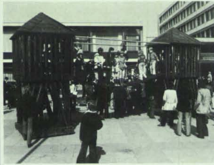
Eine Hängebrücke zwischen zwei stabilen Holztürmen war das Jubiläumsgeschenk der THW-Helfer für die Kinder von Beuel.
