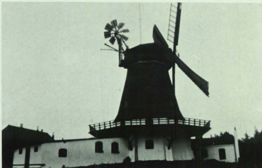
Dank der Hilfe des Technischen Hilfswerkes konnte diese alte Windmühle wieder restauriert werden.
