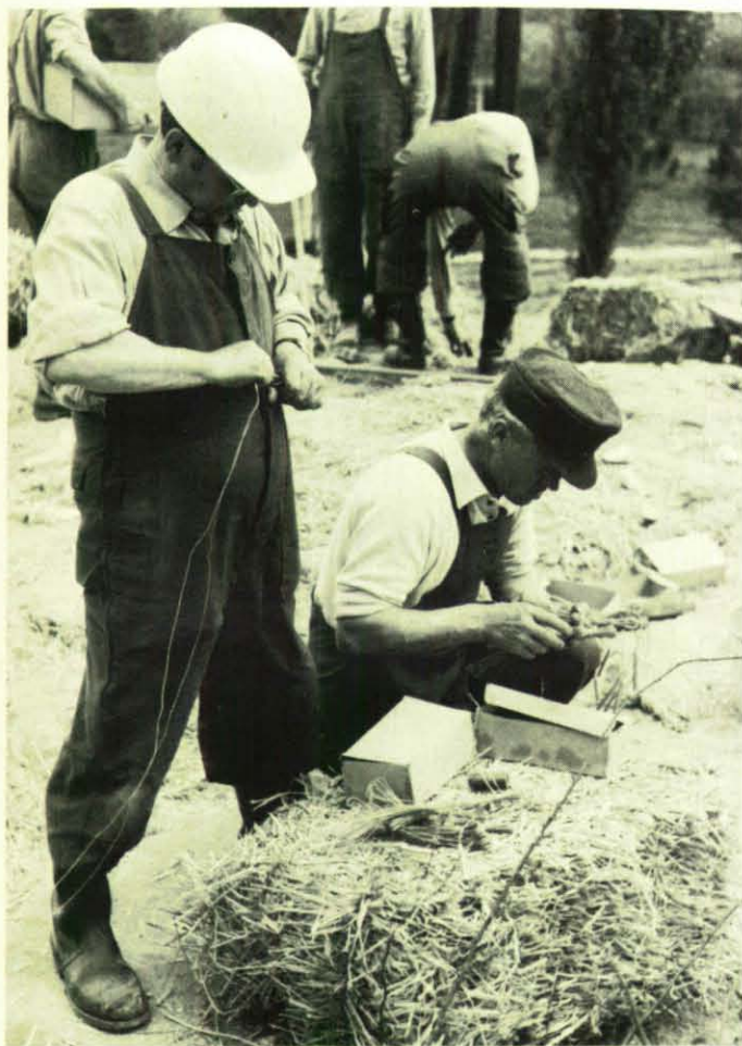
Hier werden die Ladungen für die geplante Sprengung vorbereitet.
