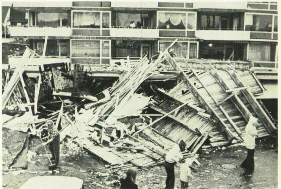
Wie Spielzeug wirbelte der Sturm diese Dachkonstruktion auf die Straße.
