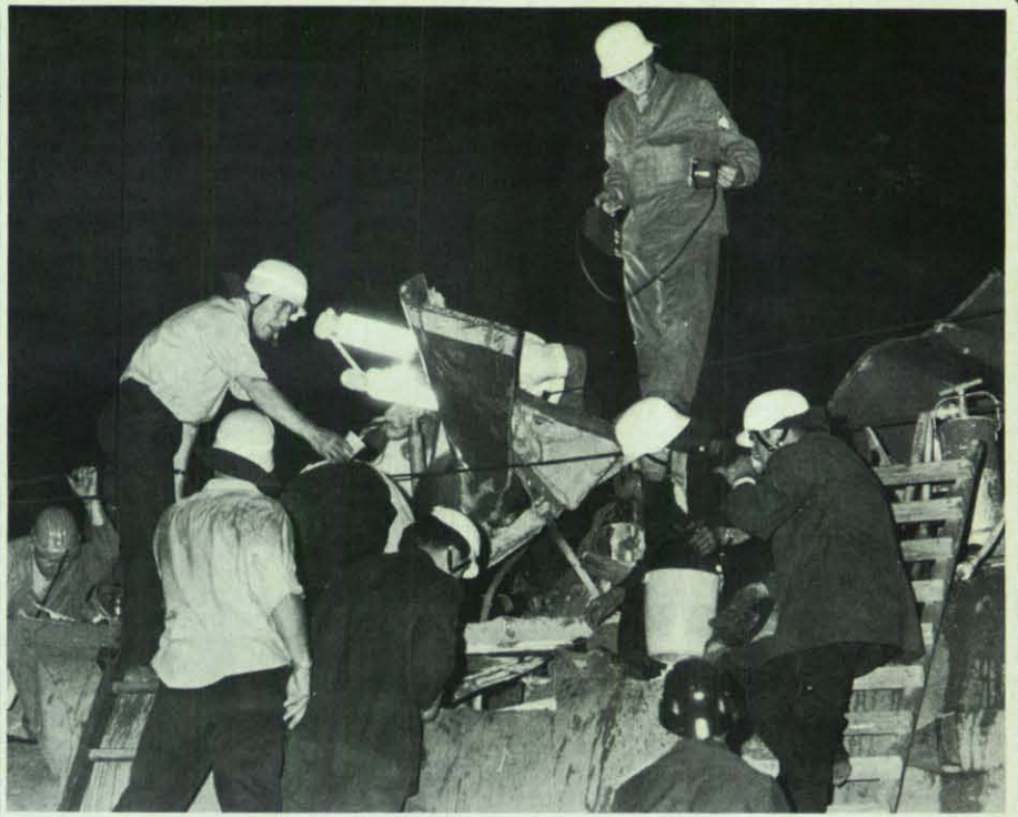
THW-Helfer Hand in Hand mit Feuerwehrmännern bei Aufräumarbeiten.
