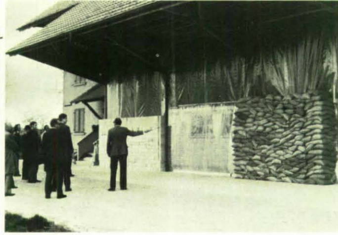
Plastikfolien sollen das Eindringen des radioaktiven Staubes verhindern. Sandsäcke und Steine reduzieren die Strahlenintensität.
