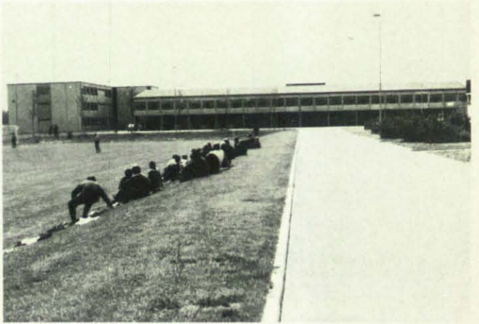
Vier Kompanien zu je 120 Mann sind in dem langgestreckten Trakt des Waffenplatzes untergebracht.
