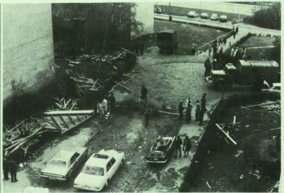
Zertrümmerte Dächer und Autos kennzeichneten das Straßenbild.
