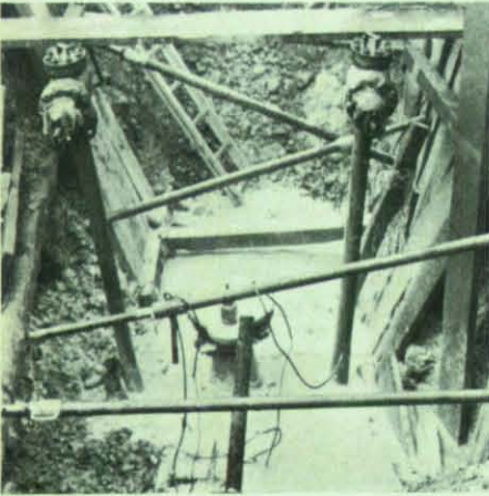
Defekter Schieber der Erdgasleitung wurde repariert.
