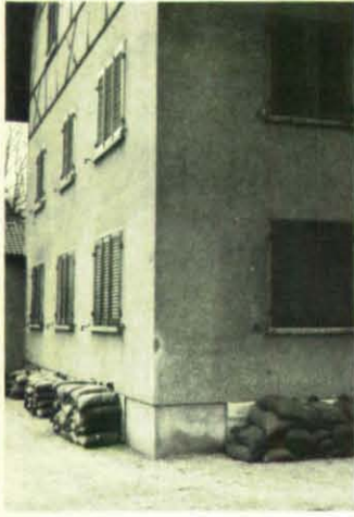
Alle Öffnungen des Hofes sind behelfsmäßig abgeschirmt.
