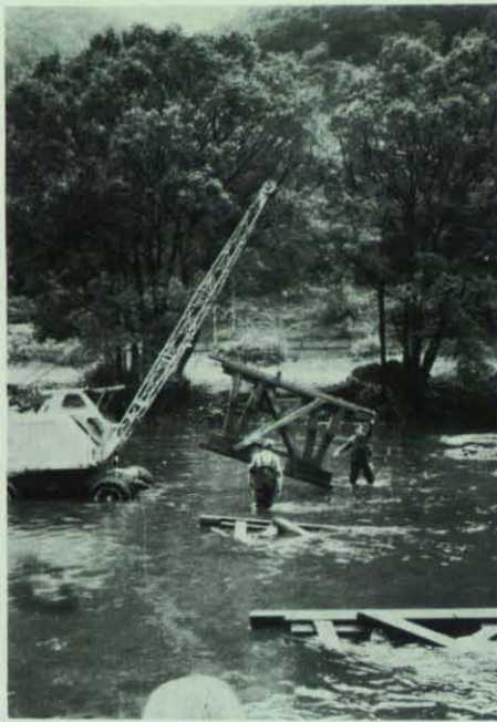
Mit Hilfe eines Krans, der in der Lenne stand, wurden die Joche eingebaut.
