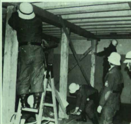
THW-Helfer vom OV Fulda hatten die Aufgabe, eine Decke abzustützen.
