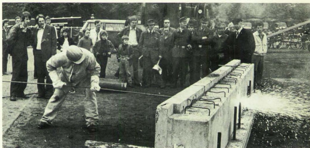
Viele technische Fragen hatten die THW-Helfer während des Einsatzes einer Sauerstofflanze zu beantworten.
