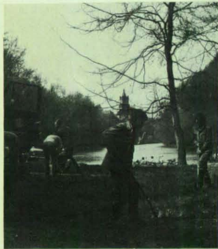
Arbeiten am Uferweg, im Hintergrund die Schwanenburg.
