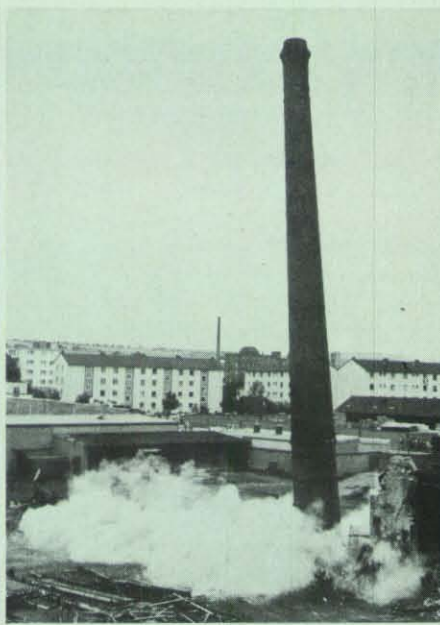
Drei Signale, dann ein Knall — der Schornstein neigt sich.
