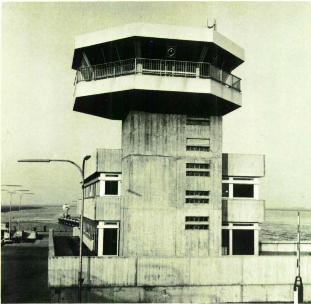
Blick auf das Betriebsgebäude mit dem zentralen Leitstand. Alle Funktionen des Sperrwerks werden hier erfaßt und ausgelöst.
