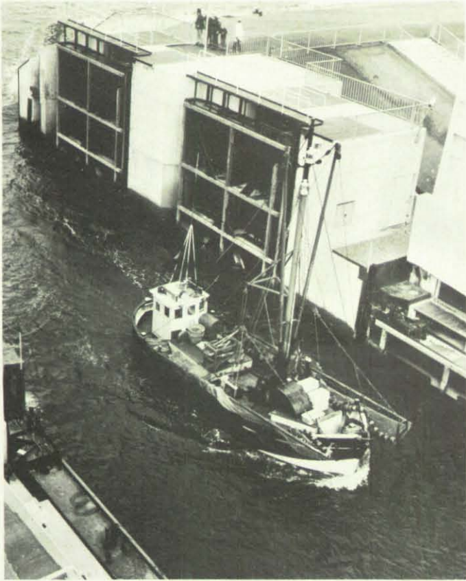
Vorbei an zwei Sturmflutturen fährt ein kleines Schiff in die 130 m lange Schleuse ein. Die Schleusentore werden ebenfalls hydraulisch angetrieben.
