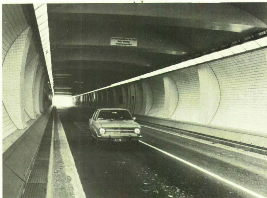
Blick in den 236 m langen Autotunnel mit weiß gefliesten Wänden und fünffach abgestufter Beleuchtung. Dieser autotunnelartige Ausbau eines Brückenträgers im Siel ist bisher einmalig.
