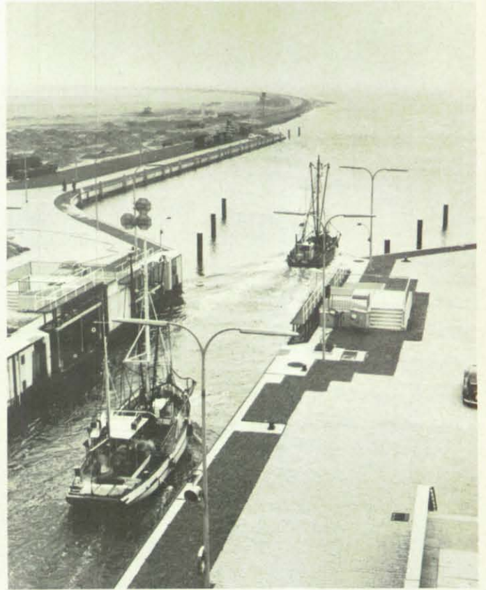
See- und landseitig sind der Schleuse Vorhäfen vorgelagert, die in erster Linie den auf Schleusung wartenden Schiffen Liegeplätze bieten.
