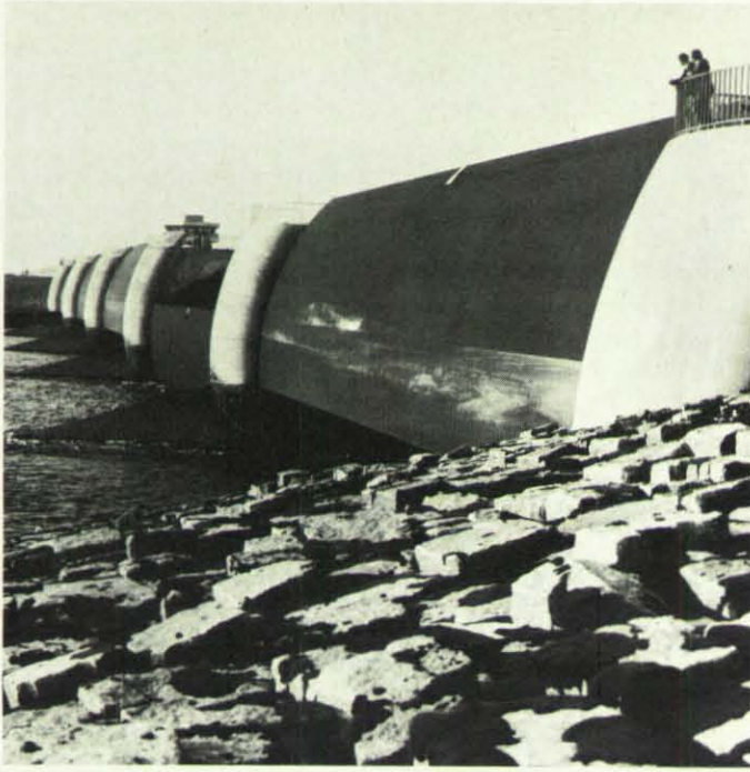
Das Eidersperrwerk, hier die Seeseite, hat fünf Öffnungen von je 40 m lichter Durchflußbreite. Die Sieltore verhindern, wenn sie wie das zweite Tor geschlossen werden, das Eindringen von Hochwasser in die Eidermündung.
