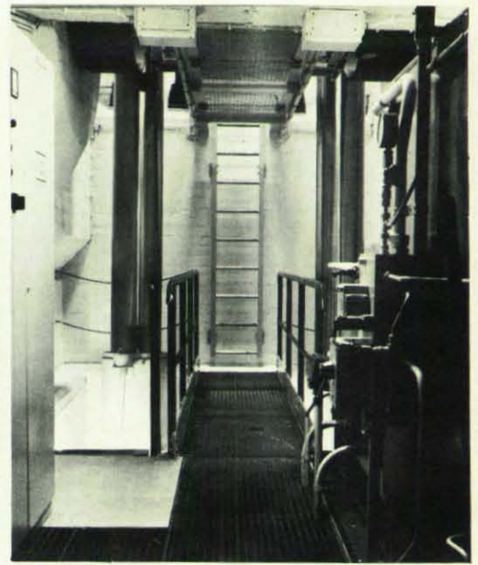
Jedes Sieltor hat zwei ölhydraulische Zylinder-Kolben-Aggregate, die in den Maschinenräumen der Pfeiler bzw. Widerlager untergebracht sind.
