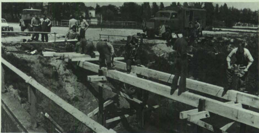
Einen Fußgängersteg über die Aue bauten THW-Helfer in Burgdorf.
