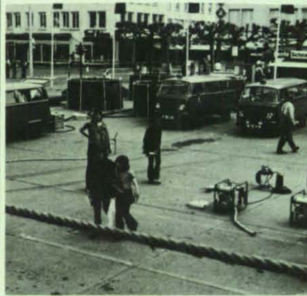
Das THW zeigte außer den Fahrzeugen auch die Trinkwasseraufbereitungsanlage (im Hintergrund).
