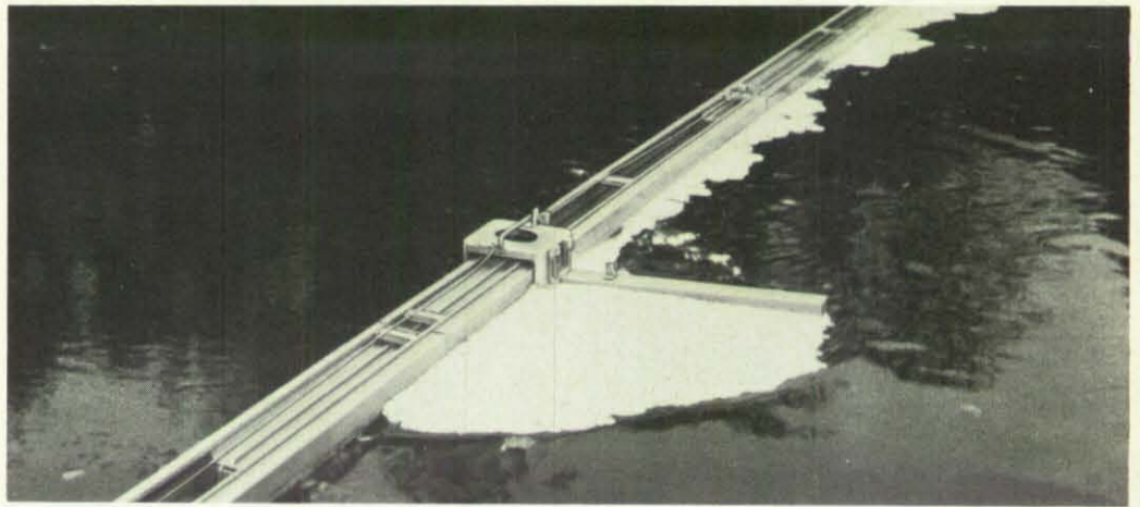
Bei Eintritt von gefährlichen Flüssigkeiten in das Kanalisationsnetz oder in Bäche und Flüsse ist schnelles Handeln geboten. Unser Bild zeigt eine der vielen Typen von Ölsperren, mit denen schwimmendes Öl gestoppt und später abgesaugt werden kann.
