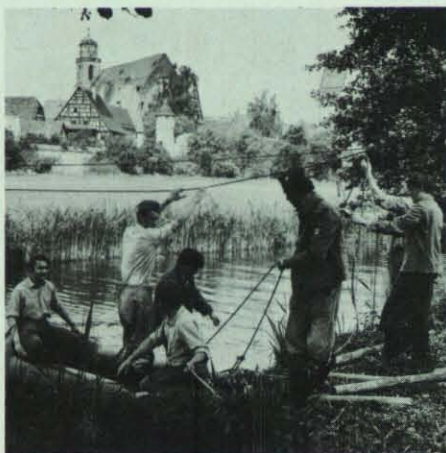
Auch der Bau eines Hängesteges will gelernt sein.
