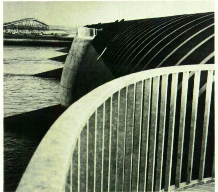
Während der Bauzeit des Eidersperrwerks war die einspurige Transportbrücke (links im Hintergrund) ein Wahrzeichen, das die Baustelle weithin sichtbar kennzeichnete. Sie war 903 m lang und hatte über der Schifffahrtssrinne eine lichte Höhe von 19 m NN.
