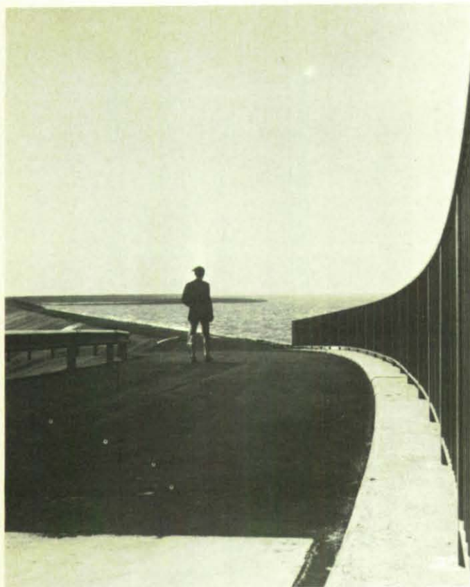
Bei der Gestaltung des Dammschnitts, unser Bild zeigt den südlichen Dammschluß an das Sperrwerk, fanden die bei früheren Sturmfluten gemachten Erfahrungen ihre Berücksichtigung.
