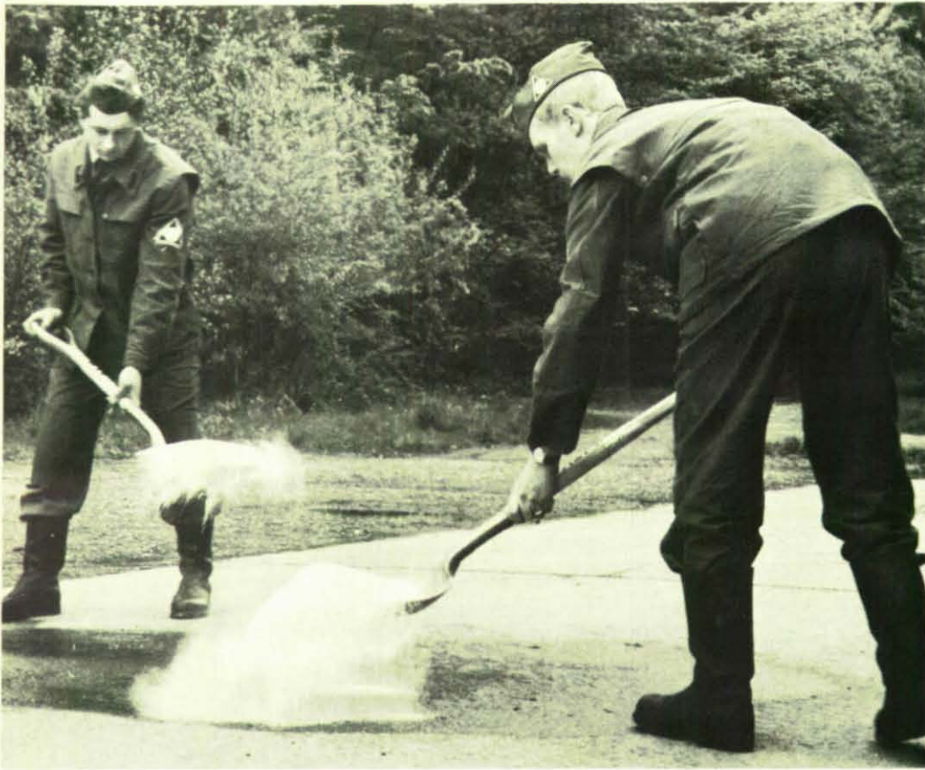
Das Ausbreiten und Versickern von wassergefährdenden Stoffen, wie z. B. Mineralöl, kann durch das Aufbringen von Ölbindemitteln verhindert werden. Die Bindemittel werden später wieder entfernt und dann verbrannt.
