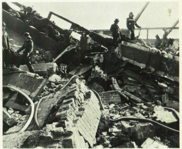
Rettungsmannschaften suchen unter den tonnenschweren Trümmern des explodierten Kühlhauses nach Verletzten.
