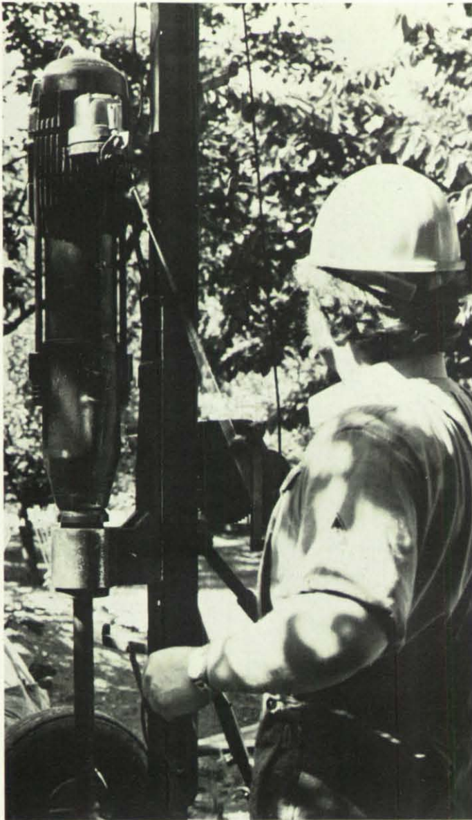
Bei einem Handbohrbrunnen wird vor dem Gebrauch ein Erdbohrer an das Saugrohr geschraubt.
