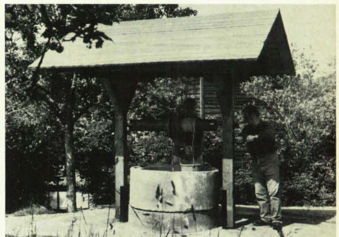
Ein Schachtbrunnen kurz vor der Fertigstellung. Das Wasser wird hier mit einem Eimer über einen Drehbaum gefördert.
