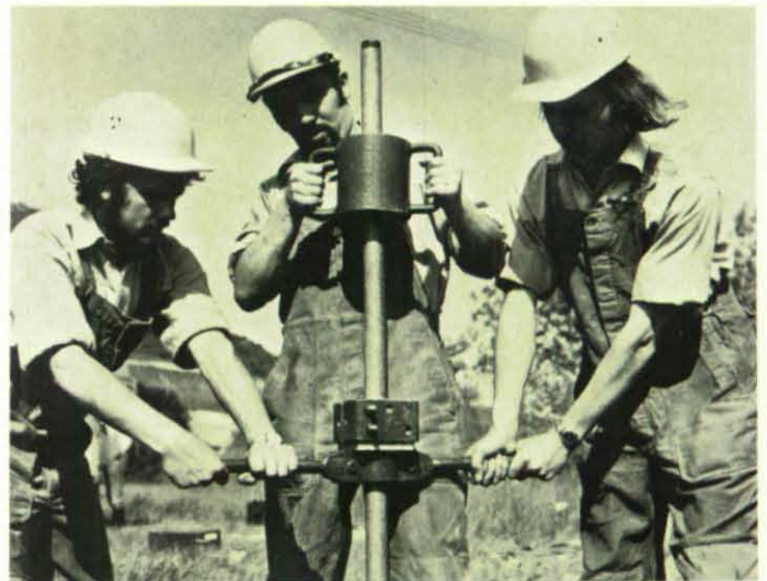
Mit Dreheisen, Rammerscheibe und Ramme werden Filterrohre und Aufsatzrohre als Handrammbrunnen in die wasserführende Schicht getrieben.
