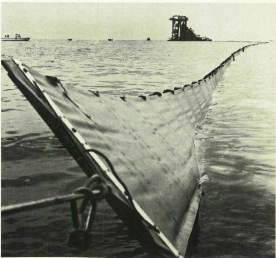
Die ECRAN-Sperre der Schweizer Seepolizei (Schwimmsperre IV) wurde an Land und an einem vor der Argenmündung liegenden Kiesbagger befestigt.
