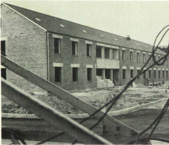
Vorderansicht eines der Unterkunftsgebäude.
