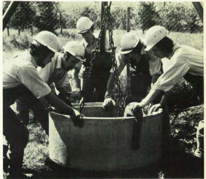
Ein Brunnen-schachtring für einen Schacht- oder Kesselbrunnen wird mit einer Ringgreifzange durch ein Rohrgewinde in die vorbereitete Baugrube abgelassen.
