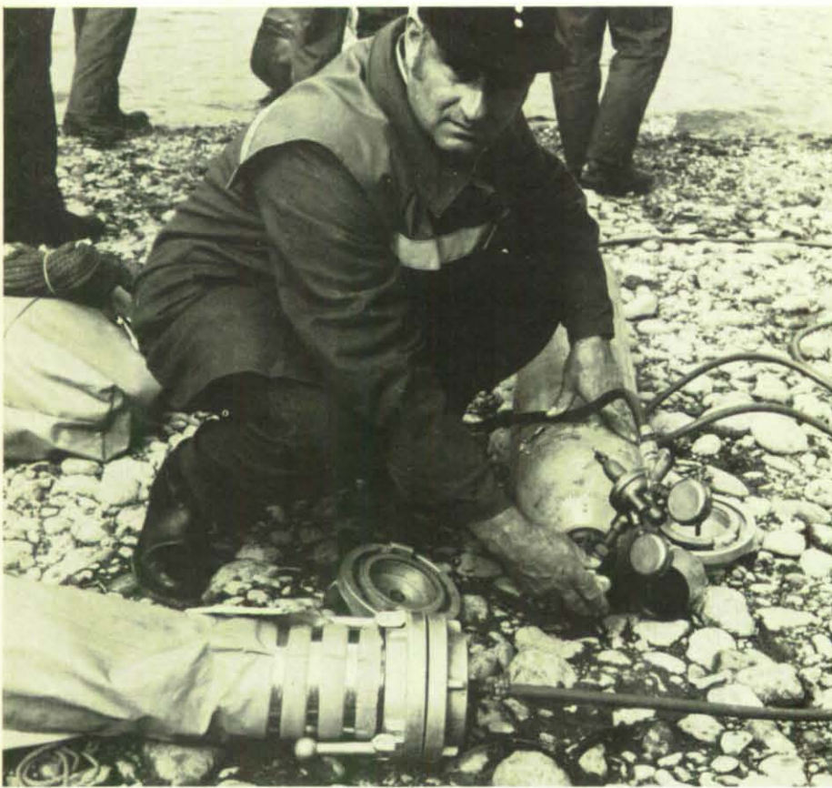
Eine Schlauchsperrre wird vor dem Einbringen in den Bodensee mit Preßluft gefüllt.
