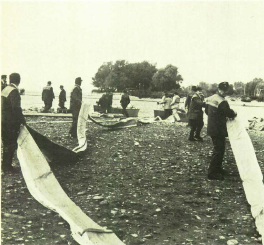
Bei der Ölschadenbekämpfung ist immer Eile geboten. Darum muß jeder Handgriff sitzen, wenn Schlauchsperrn rechtzeitig eingebracht werden sollen. Hier wird die Sperre schräg zur Fließrichtung in der Argenmündung vorbereitet.
