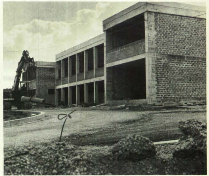
Vorderansicht des Wirtschaftsgebäudes.
