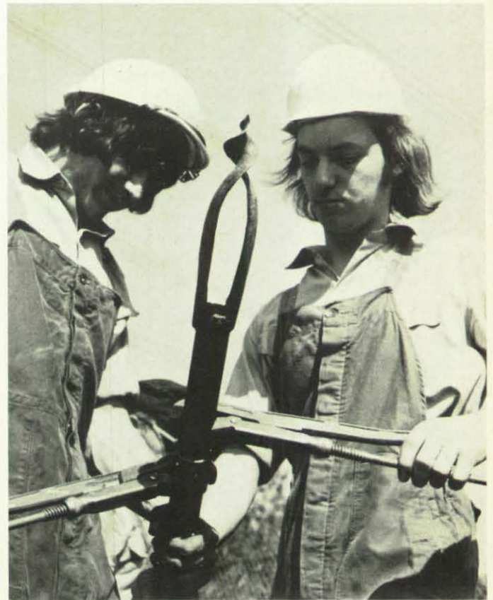
Bei einem Handbohrbrunnen wird vor dem Gebrauch ein Erdbohrer an das Saugrohr geschraubt.
