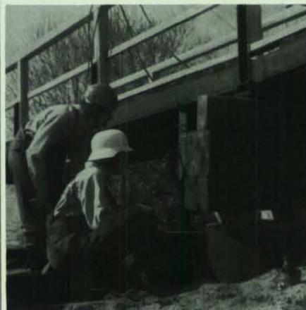
Das Heben der Brücke wird durch Pallhölzer unterstützt.
