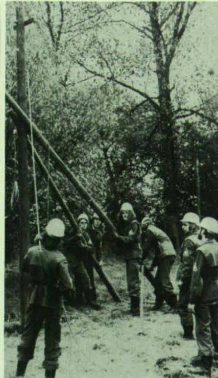
THW-Helfer beim Aufrichten eines Mastes.
