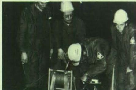
Vor der Sprengung der Stubben schloß Sprengmeister Kröger die Leitung an die Zündmaschine an.
