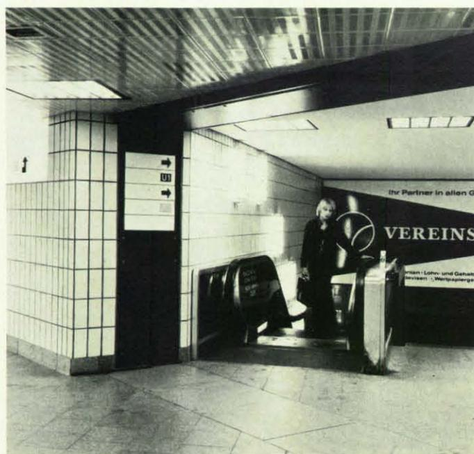
Das Hinweisschild links ist auf Blechen befestigt, hinter denen sich eines der großen Schiebetore befindet. Die Rolltreppe liegt außerhalb des Schutzraumes.
