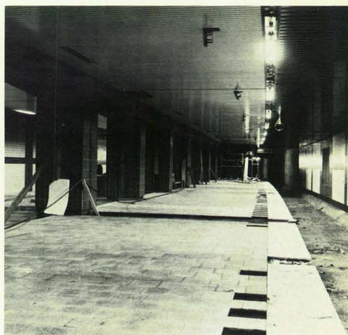
Bahnsteig und Gleisstrecke der Haltestelle Stadthaus. Die Verkleidung von Wänden, Decken und Fußböden ist fast fertiggestellt.
