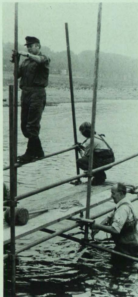
**Dieser 10 m in den Rhein gebaute Rohrgerüststeg diente als Unterbau für die Ansaugleitung.**
