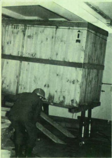
Die Vorderkante der Kiste liegt auf dem Hubwagen. Der Höhenunterschied wird durch zwei Hydro-Pressen ausgeglichen. Ein kurzzeitiges Problem war der Deckenabsatz.
