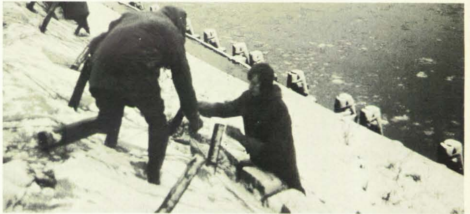
Ein eisiger starker Wind macht die Deicharbeiten besonders schwierig.
