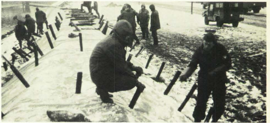
THW-Helfer verspannen die Pfähle und befestigen Kunststoffplanen zur Befestigung des Vordeiches.
