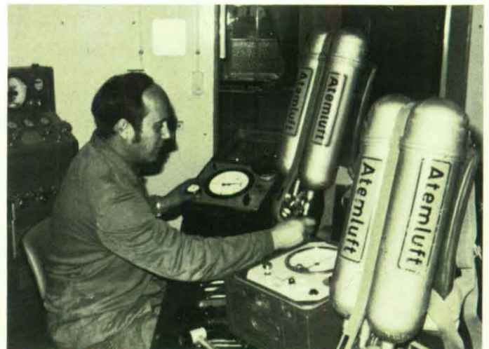
Funktionsprüfung der in der Werkstatt instandgesetzten Preßluft-Atemgeräte.
