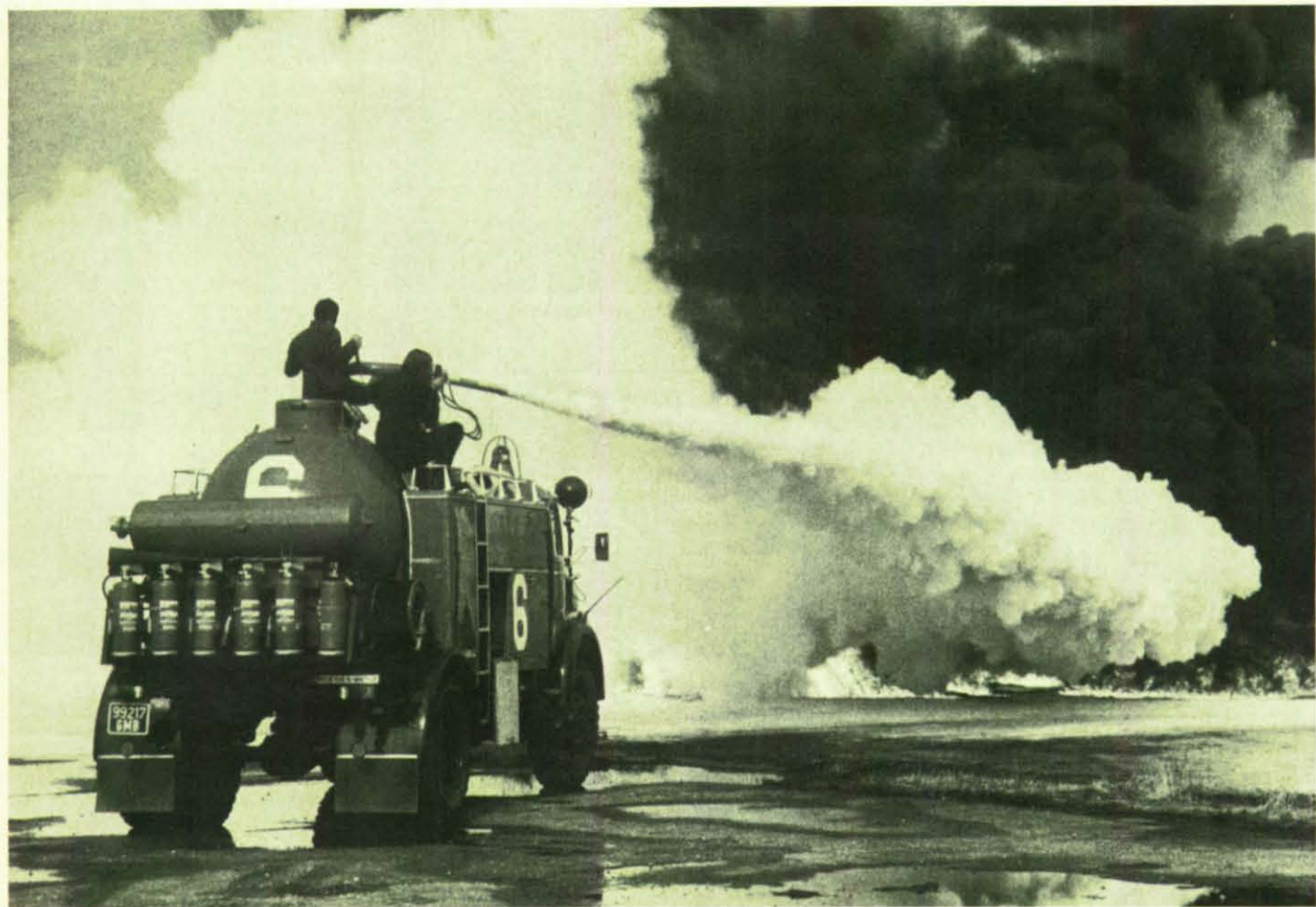
Auch das Pulverlöschfahrzeug TroLF 2000 wurde in vielen technischen Details verbessert. Trockenlöschfahrzeuge sind zum Einsatz bei Bränden bestimmt, wie sie z. B. in Häfen, Werften und auf Flugplätzen entstehen können.
