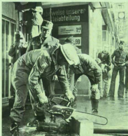
THW-Helfer stützen die Eingänge zu dem gefährdeten Kaufhaus ab.
