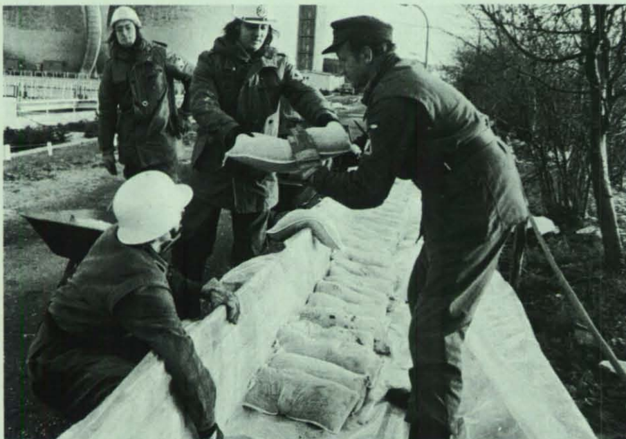
Richtige Lage der Kunststoffplane und der ersten Sandsäcke ist entscheidend für die Haltbarkeit der Deicherhöhung.
