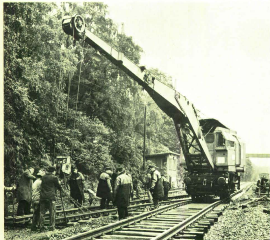
Auch bei Gleisarbeiten finden die Kranwagen der Bundesbahn Verwendung.
