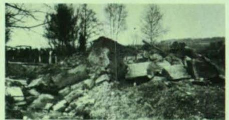
Die alte Eisenbahnbrücke bei Gölffingen vor und nach der Sprengung.
