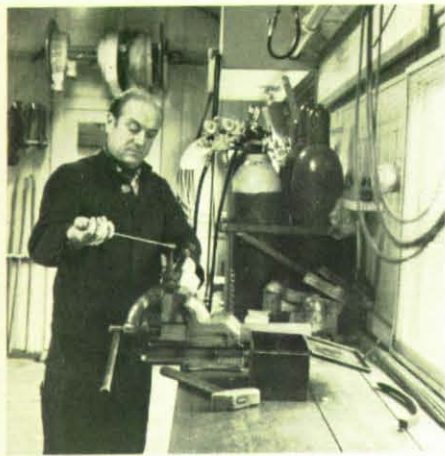
Der Hilfszug als Werkstatt. Im Hintergrund Sauerstoff- und Azetylenflaschen.
