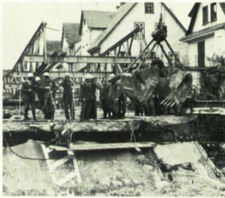
Ein Helfer brennt die Spanneisen ab.
