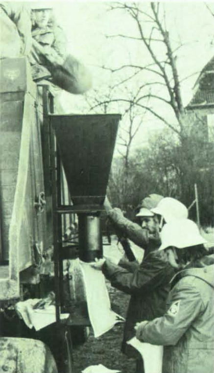
Sandsackfüllanlage, anhängbar an jeden Lastkraftwagen.
