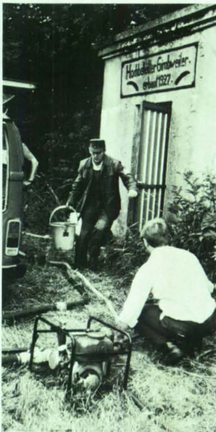
Die Anlage läuft auf vollen Touren. Rechts der Hochbehälter.
