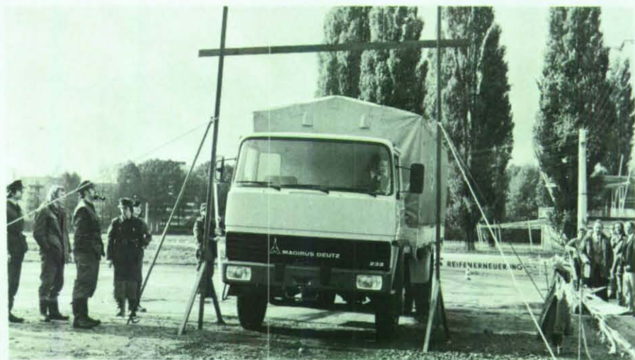
Eine der vom THW gebauten „Schikane“ auf dem Schützenplatz in Hannover.
