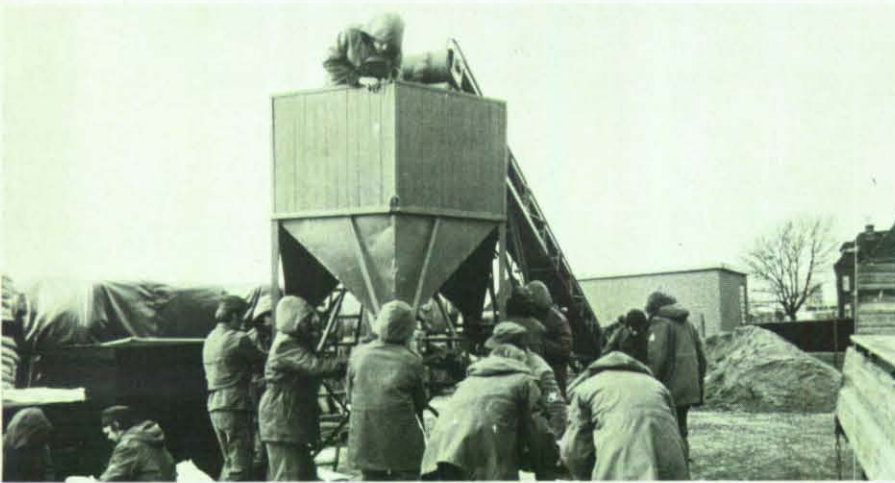
Transportable Sandsackfüllanlage mit Förderband.
