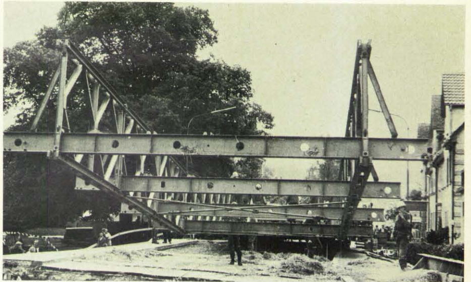
Der letzte Bauabschnitt beginnt.
