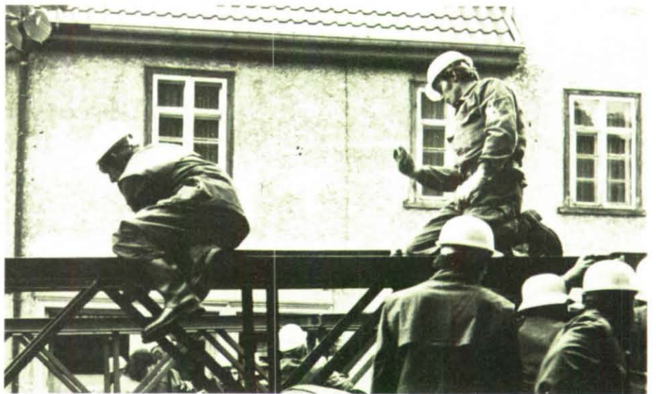
Ein Trupp montiert die Verstrebungsrahmen.
