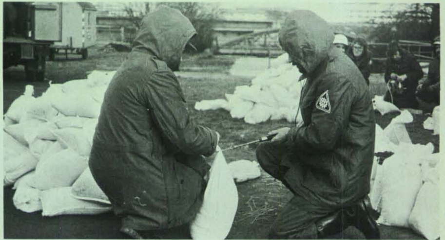
Zurödeln eines Sandsackes.
