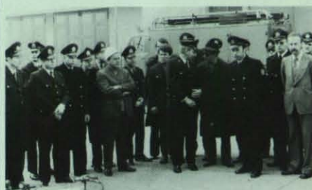
Interessiert verfolgen leitende Beamte der Berliner Feuerwehr die Vorbereitungen zum Einsatz der Sauerstofflanze.
