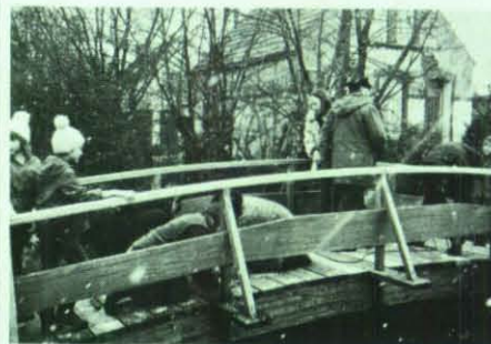
Letzte Arbeit: Die Laufbohlen werden verschraubt.
