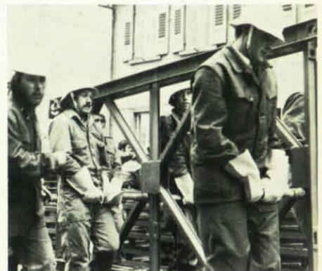
Das Heranschieben der einzelnen Glieder der Brücke ist harte Arbeit.
