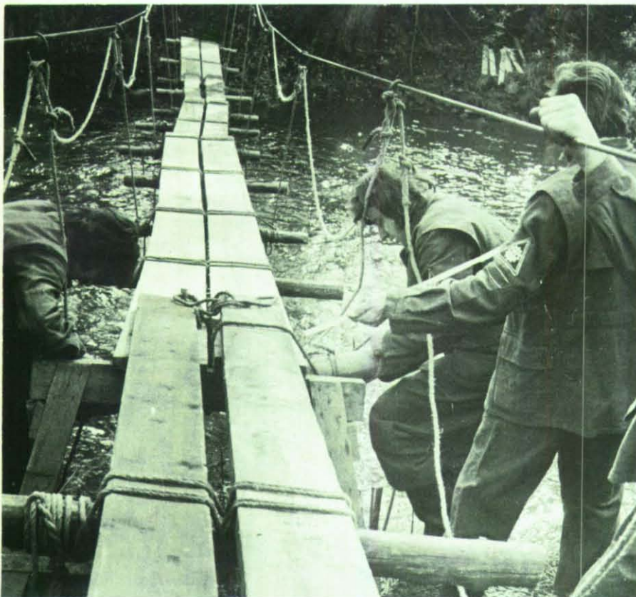
Die THW-Helfer aus Betzdorf hatten den Auftrag über die Wied diesen Hängesteg zu bauen.
