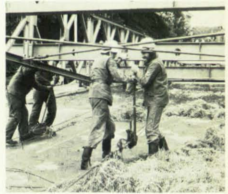
Das erste Brückenteil wird vorgeschoben.
