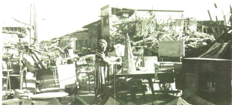
Nach dem Erdbeben in Nicaragua. Deutsche Spezialisten sorgten in der Hauptstadt Managua für die Instandsetzung öffentlicher Versorgungseinrichtungen.
