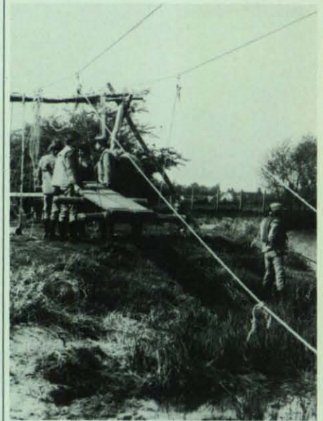
Der 2. Bergungszug beginnt mit dem Bau eines Hängesteges.
