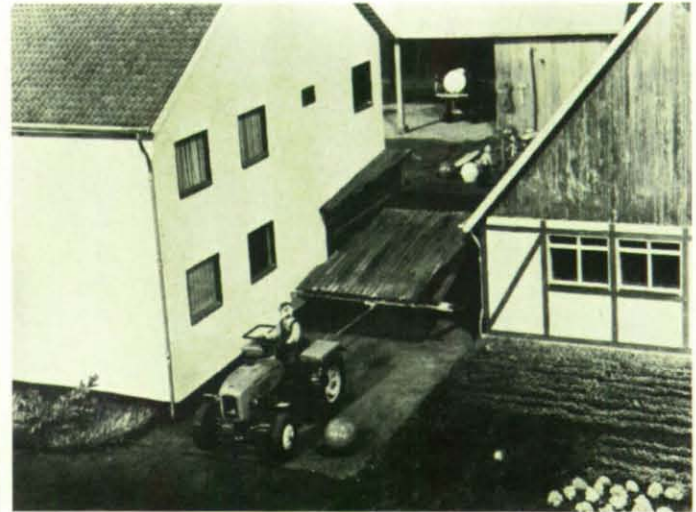
Am beweglichen Modell veranschaulicht: Einreißen einer „Feuerbrücke“ als Maßnahme des vorbeugenden Brand-schutzes.
