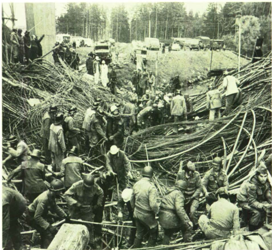
Blick auf das eingestürzte Teilstück der Leubastalbrücke nördlich von Kempten.
