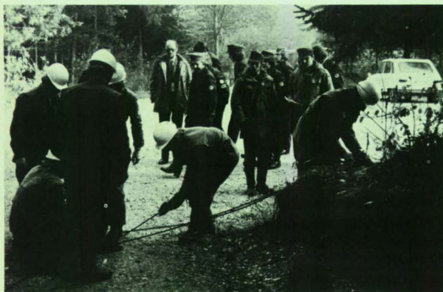
An der Speerbergsbrücke wird eine Zugvorrichtung aufgebaut.
