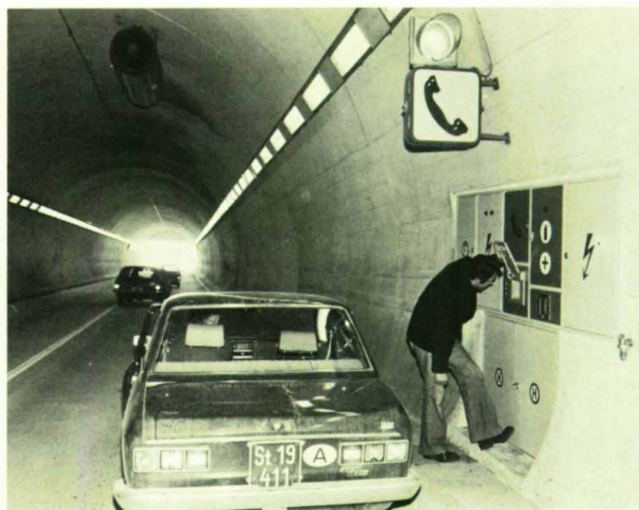
Sicherheit und technische Perfektion sind die hervorstechendsten Merkmale des Wolfsbergtunnels auf der österreichischen Tauern-Autobahn.
