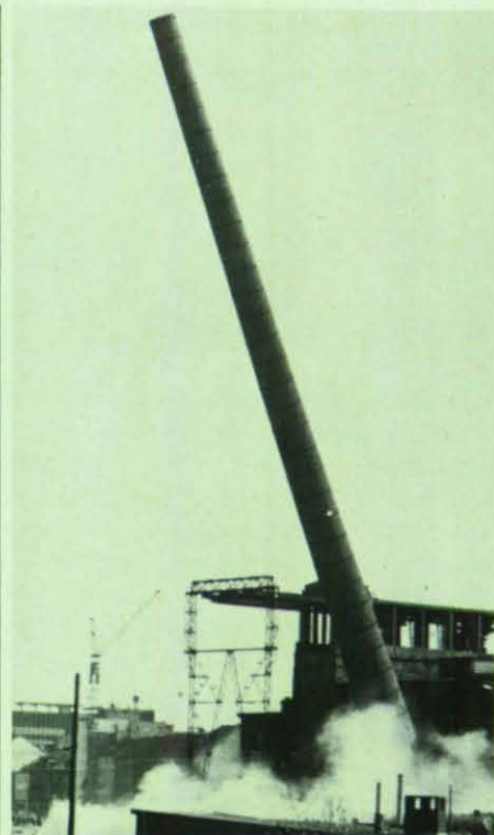
Bei der Kaminsprengung wandten die THW-Helfer wegen der Nähe von Gebäuden die Fallschlitzmethode (seitlicher Einsturz) an.
