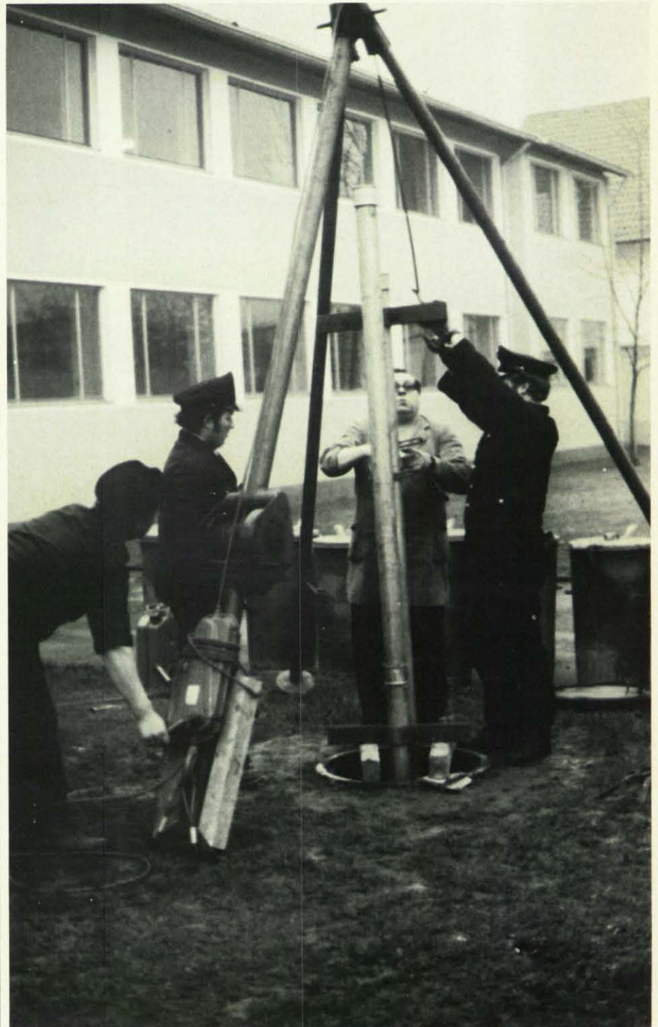
Einbau des Rohrgestänges mit Hilfe eines Dreibaums und eines Greifzugs.
