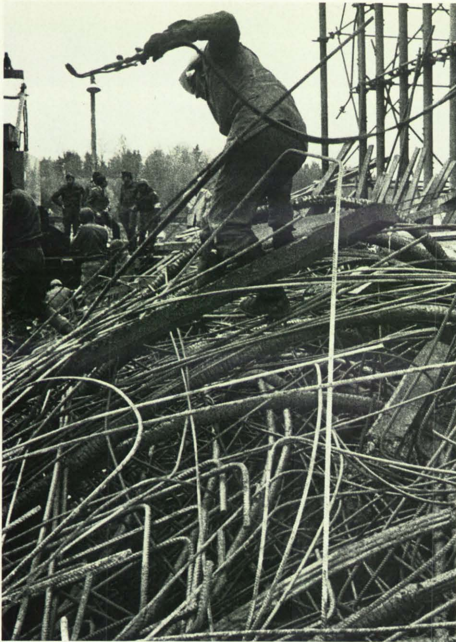
THW-Helfer mit Brennschneidergerät auf dem Drahtgewirr.
