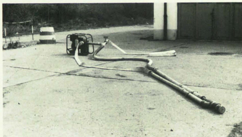
So sieht die gesamte Anlage, allerdings mit verkürzten Stahlsteigrohren, aus.
