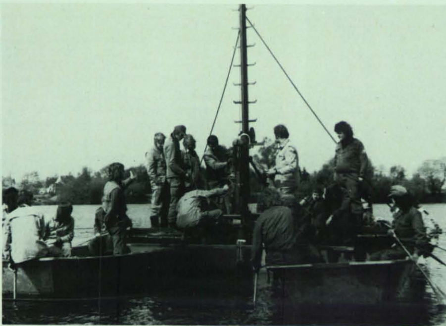
Nicht alltäglich war die Arbeit für Bremer THW-Helfer, die durch Einrammen von Pfählen in Stuhr auf dem Hohorster See Schwimmer- und Nichtschwimmer teil trennten.
