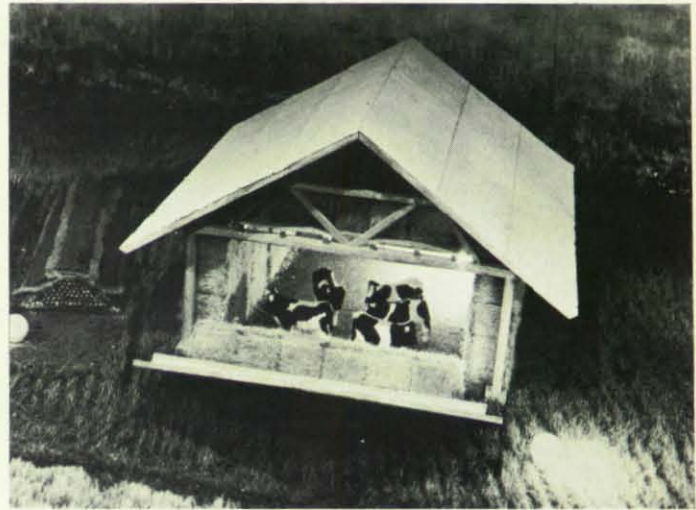
Wie man mit Hilfe von oberhalb und an den Wänden einer sonst offenen Feldscheune gelagertem Preßstroh oder Preßheu die Strahlungsgefahr für Vieh bei radioaktivem Niederschlag verringern kann, zeigt dieses bewegliche Modell.
