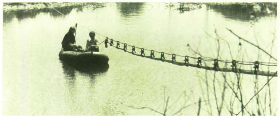
Die 90 Meter lange Versorgungsleitung wurde per Schlauchboot angelegt.
