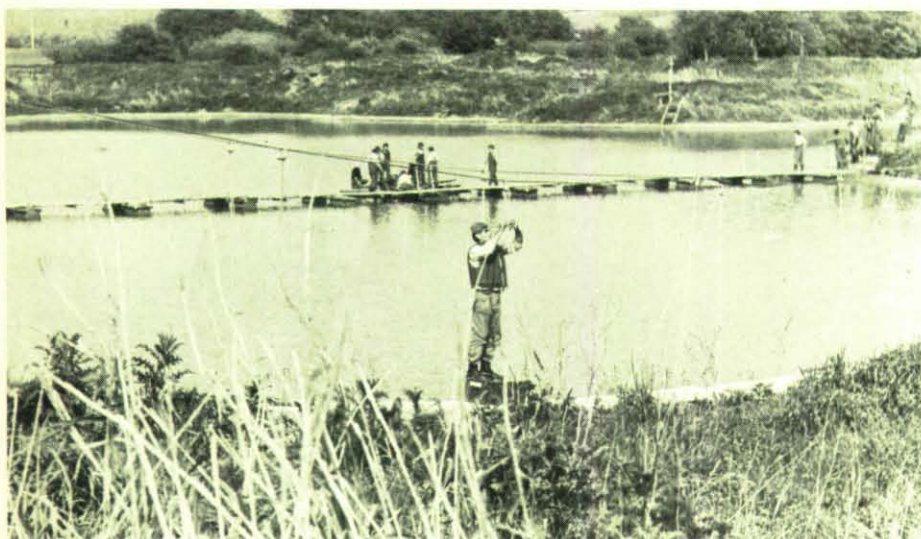
Gleich zwei Aufgaben für die Helfer des THW: Bau eines Hängesteges und (im Hintergrund) Bau eines Tonnensteges.
