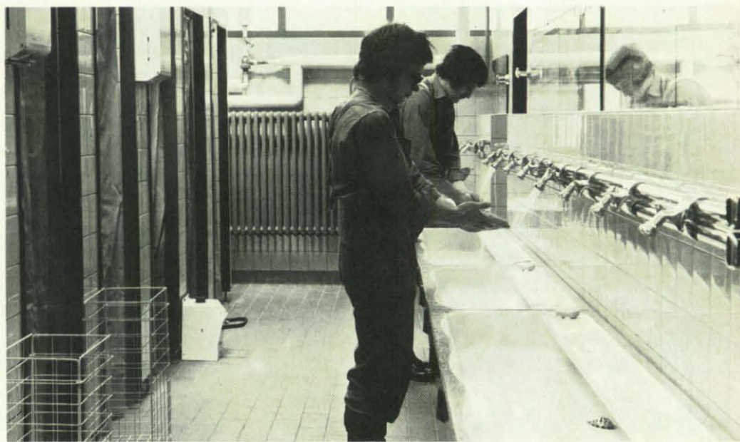
Die sanitären Einrichtungen sind — wie man das bei einer neuen Einrichtung erwarten kann —, zweckmäßig und vorbildlich. Die Anlagen können auch als „Personen-Dekontaminationsstelle“ benutzt werden und stehen dem ABC-Dienst jederzeit als solche zur Verfügung.
