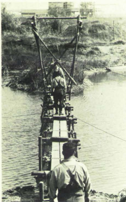
Bei praller Hitze mußte ein Beseler-Steg erbaut werden.
