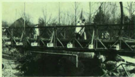
Als Ersatz für die alte Brücke (im Hintergrund) baute der OV Öhringen für die Dauer der Bauarbeiten diese Bailey-Brücke.
