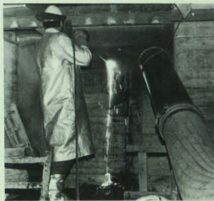
Ohne Absauggerät wäre der Mauerdurchbruch noch schwerer gewesen.
