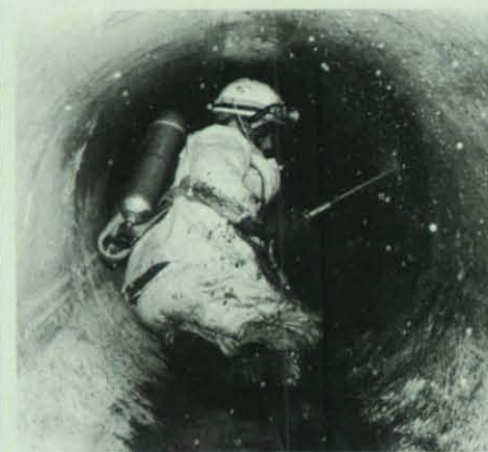
Der enge Raum erschwerte die Arbeiten außerordentlich.
