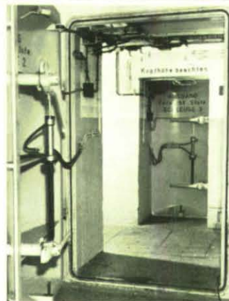
Blick durch die Schleusentür.
