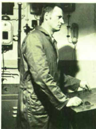
Der Schleusenwärter am Schaltpult.
