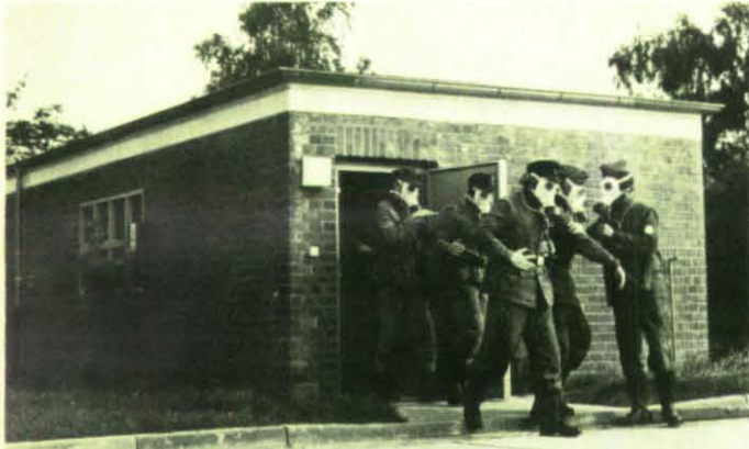
Links: Helfer beim Verlassen des Maskenprüfraumes. Der Raum mit seinen explosionsgeschützten Anlagen ist mit einem Notausgang versehen. Während der Maskenprüfung besteht zwischen den beiden Aufsichtspersonen im Innern und außen am Fenster Kontakt über eine Sprechanlage.
