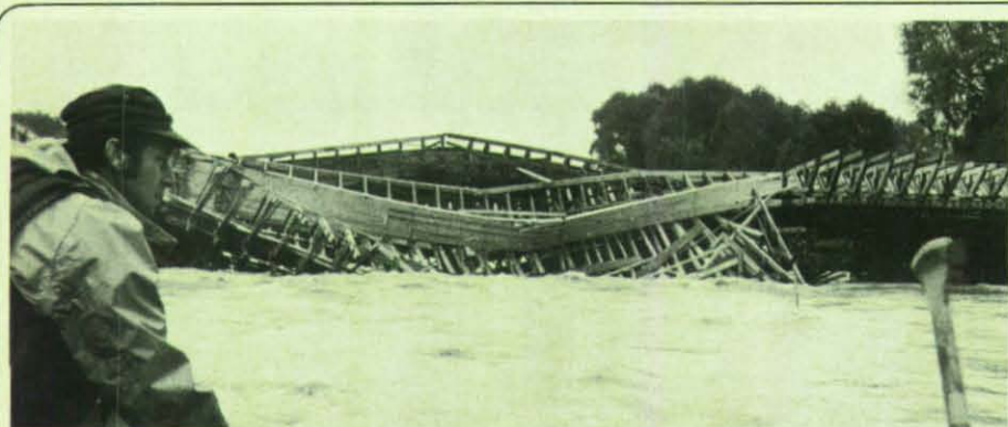
Den Einsturz des Lehrgerüsts der Isarbrücke konnten die THW-Helfer nicht verhindern.
