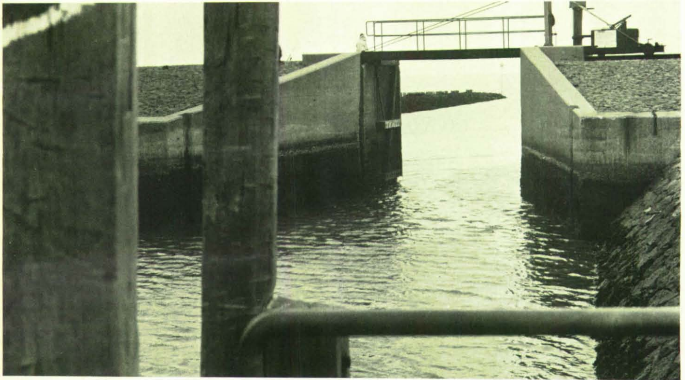
Blick auf die Schleuse vom Hafen aus, dem Liegeplatz der Barkassen und Segelboote. Bei „Land unter“ steht das Wasser auf der Hallig wie in einer Waschschüssel, da es nur langsam durch diesen Durchbruch im Deich ins Watt zurückfließen kann.
