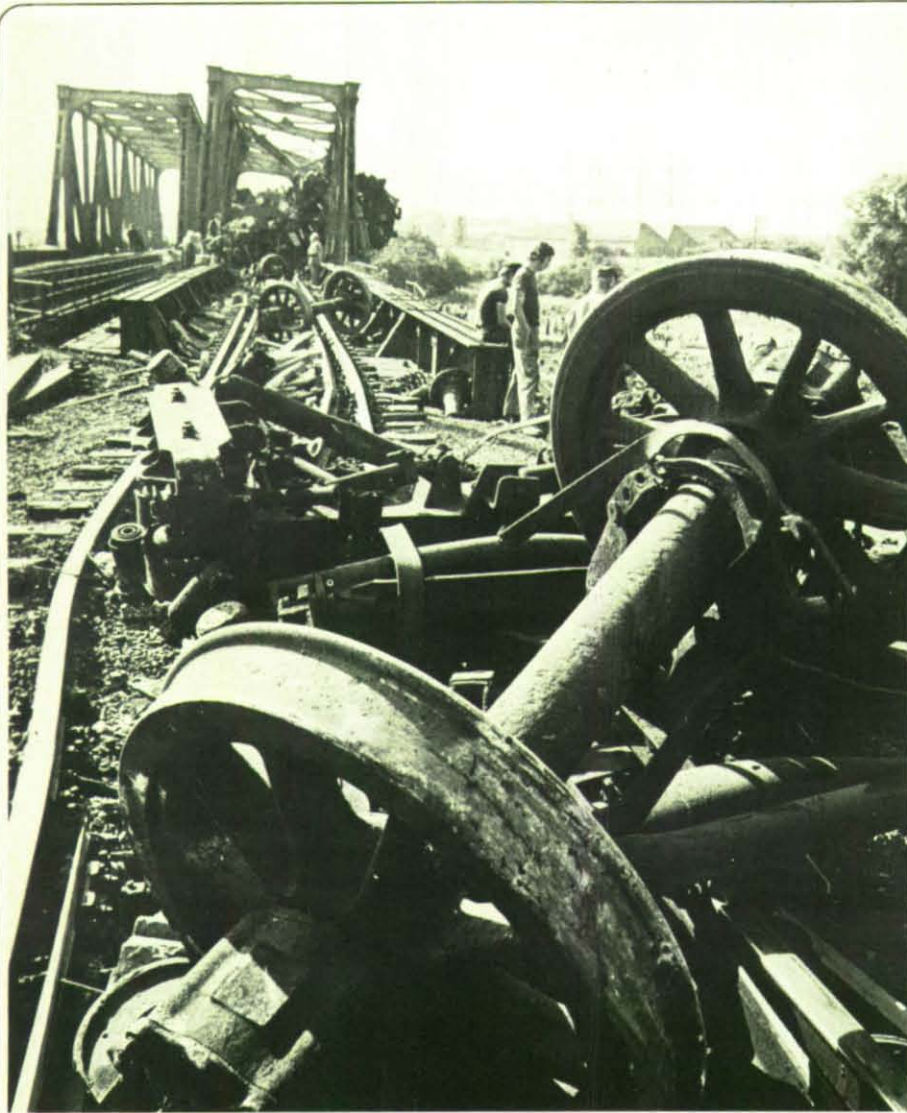
84 Verletzte mußten nach dem Zugunglück in Belgien aus den Stahltrümmern befreit werden.
