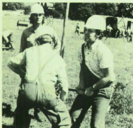
Helfer des OV Neunkirchen beim Betrieb des Brunnenbohrgeräts.
