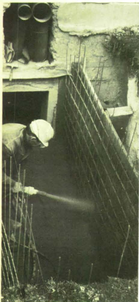
Der nachträgliche Einbau von Schutzräumen — hier die Betonierung eines Notausstiegschachtes — ist im Spannungsfall kaum möglich.
