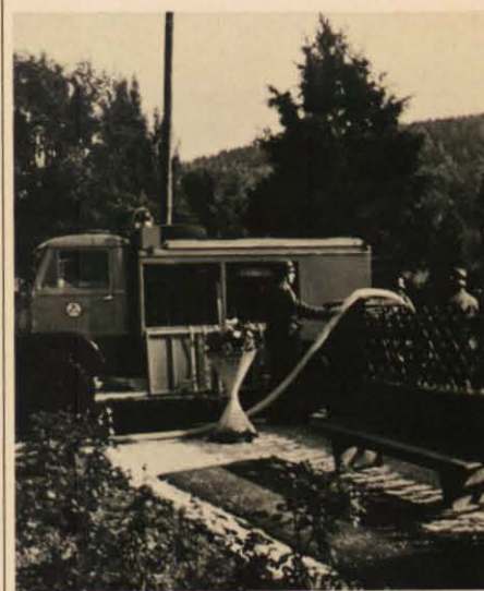
Am Beginn der langen Schlauchstrecke: Wasserentnahmestelle in Bodenrod.
