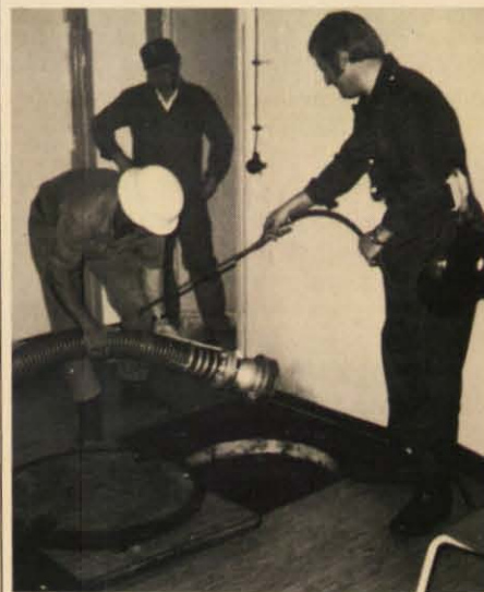
Einbringen des Ansaugschlauches zur Wasserentnahme in den Vorratsbehälter des Warnbunkers.
