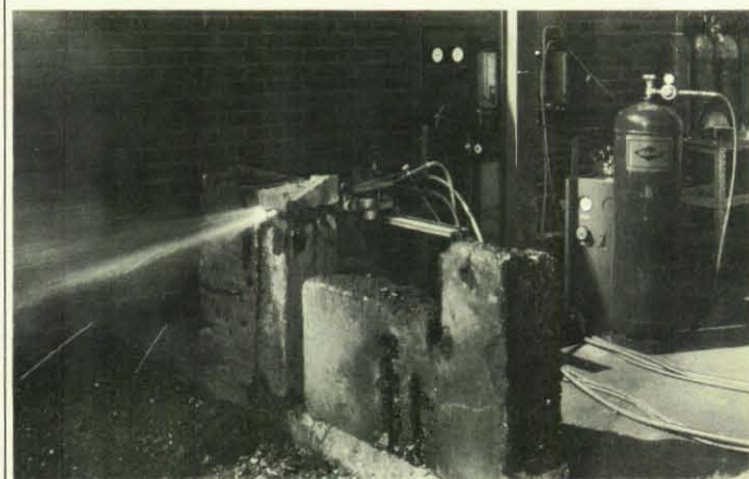
Demonstration des thermischen Trennens von Beton.
