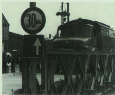
Belastungsprobe nach Abschluß der Montage.
