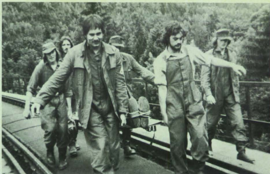
Transport von Verletzten auf der Eisenbahnbrücke.
