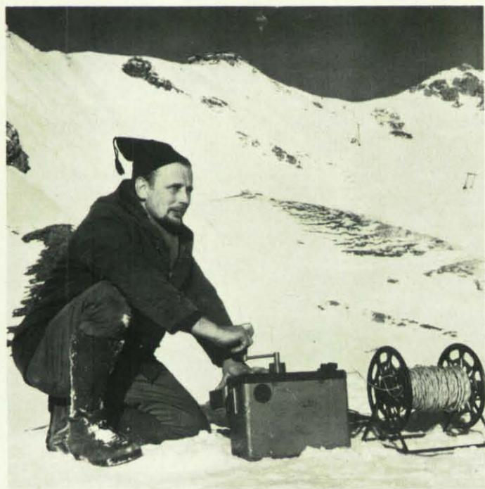
Schneefeldsprengungen zur künstlichen und damit kontrollierten Auslösung von Lawinen gewinnen immer mehr an Bedeutung. Diese Art der Sprengung, sie kann auch elektrisch ausgelöst werden, ist jedoch nur an leicht zugänglichen Stellen möglich.
