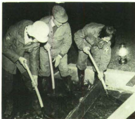
Arbeiten zur Umleitung der Theel.
