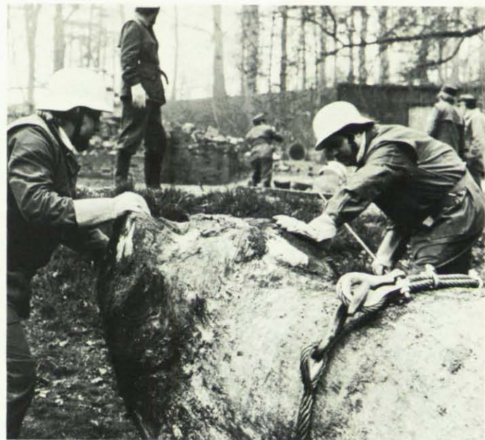
Mit Hilfe des Greifzugs (im Hintergrund) können schwere Lasten leicht bewegt werden. Bei richtiger Handhabung ist auch das Anheben von schweren Decken- und Mauerwerksteilen, z. B. bei der Bergung aus Trümmern, problemlos.
