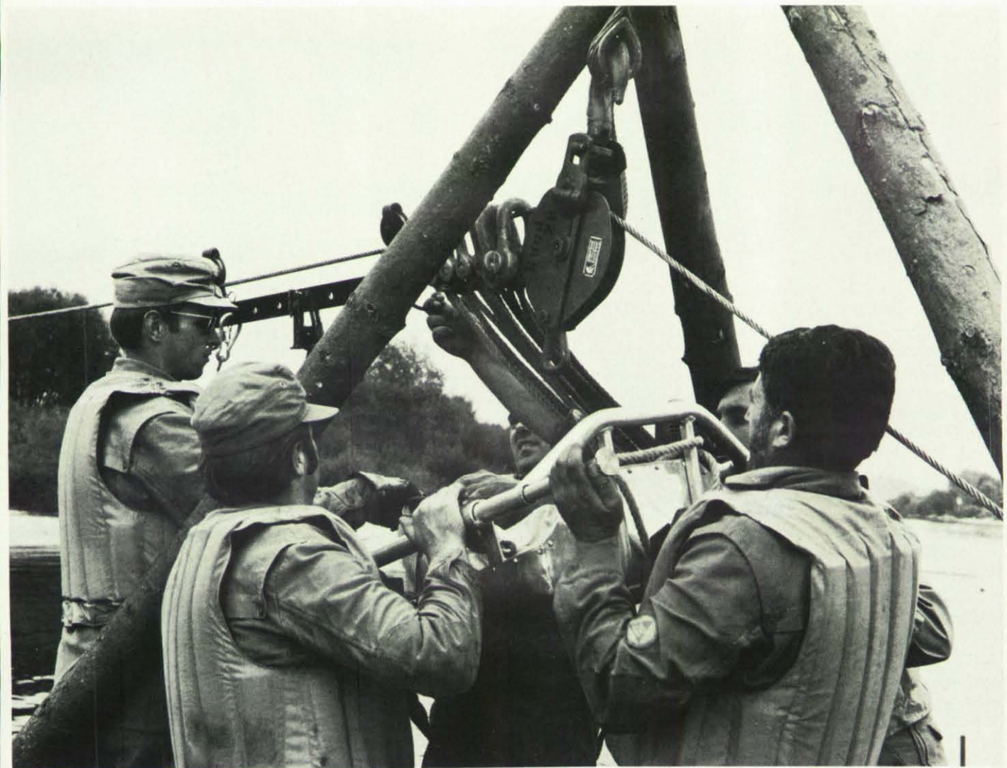
Die Einfachheit der Konstruktion des Greifzugs ermöglicht auch seine bevorzugte Verwendung beim Erstellen von Seilbahnen.
