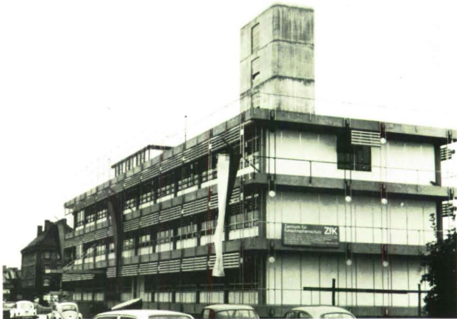
Das Katastrophenschutzzentrum an der Heßstraße in München wurde jetzt der Stadt feierlich übergeben.
