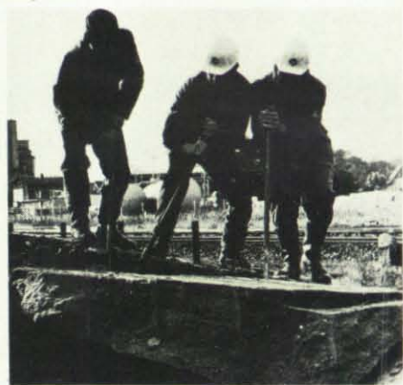
Eine harte Arbeit war dieser Betonklotz für die THW-Männer.
