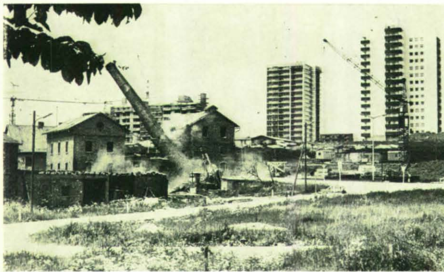
Geschafft! Der Kamin fällt in die vorbestimmte Richtung!
