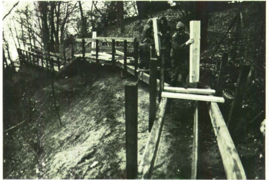
Helfer vom Bergungszug 241 beim Bau der Strecke auf dem Hang.
