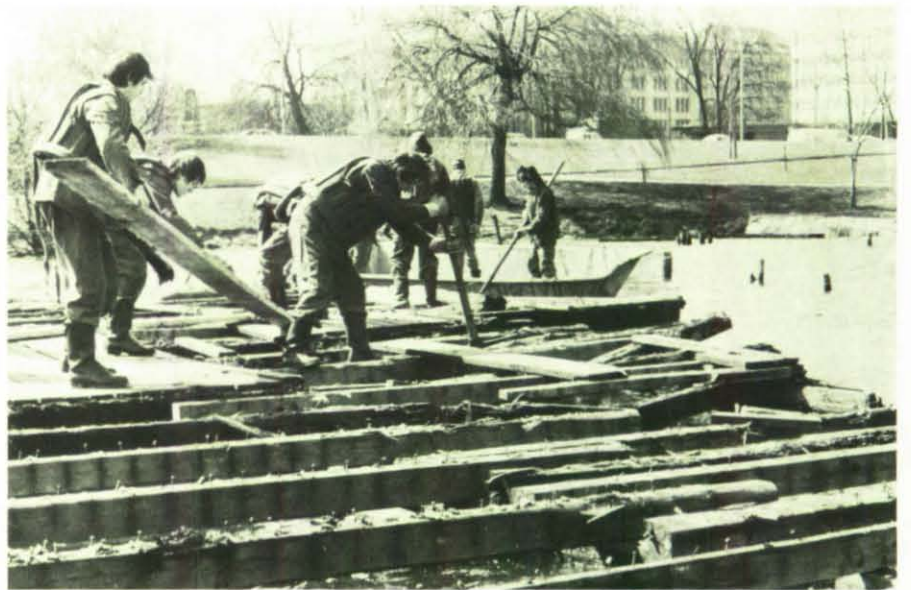
Innerhalb zehn Stunden ließen Helfer vom Bergungszug 340 zunächst den alten, morschen Bootssteg verschwinden, damit der Bau des Neubaus beginnen kann.
