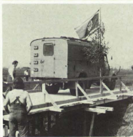
Die 12-t-Brücke ist fertig.
