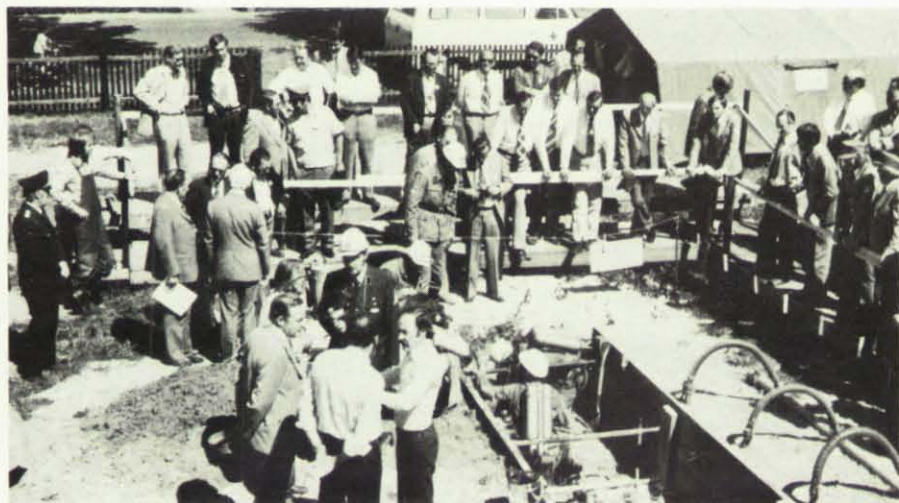
Zeitweise unter Atemschutz wurden die Arbeiten an der defekten Gasleitung durchgeführt.
