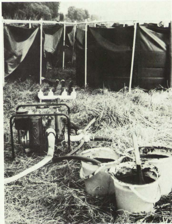
Bild 7: Angerührte Filtermasse, fertig für die Anschwemmung
