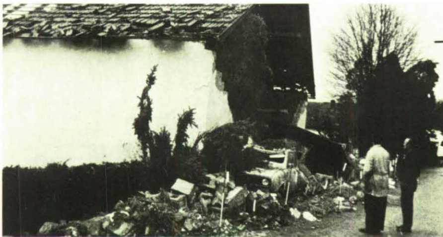
Die Vorderwand dieses Gebäudes barst unter der Wucht des Sturmes.
