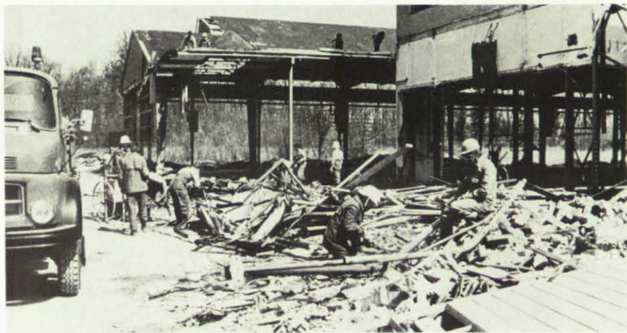
Arbeit für vier Wochen bedeutete für den OV Ingolstadt der Abbruch der alten Werkhallen.
