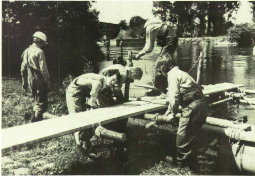
Jungshelfer beim Bau eines Tonnensteges.
