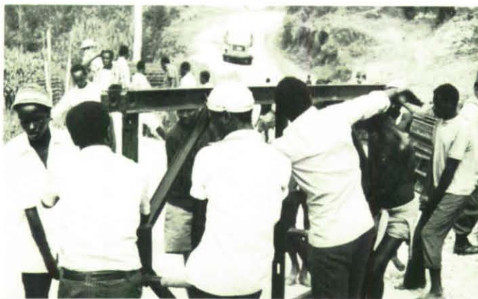
Brückenbau-Einsatz in Ruanda: Teile einer Brücke werden eingebaut.
