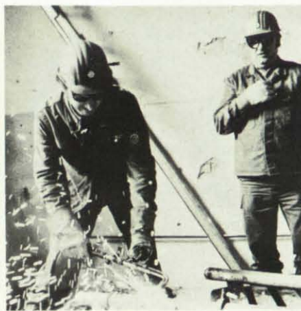
Als willkommene Gelegenheit für die Ausbildung im Brennschneiden sahen die Helfer des I-Dienstes den Abriß der Fabrikhallen.
