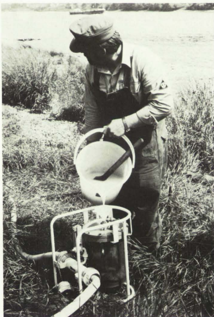
Bild 9: Einfüllen von Chlorbleichlaugung in das Dosiergerät
