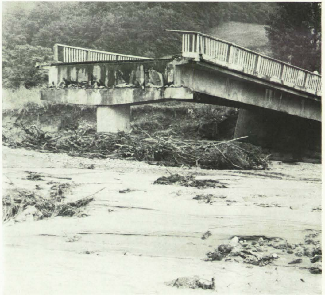
Schwerste Schäden am Straßen- und Schienennetz Rumäniens richtete die Hochwasserkatastrophe an. Diese Brücke im Verlauf der Nationalstraße 13 wurde von den Fluten weggerissen.
