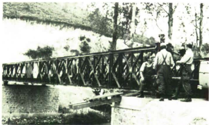
Mit fast 40 Metern Stützweite war die Bailey-Brücke über den Mwogo der größte Bauauftrag. Auf unserem Bild ist die Brücke bereits eingefahren.
