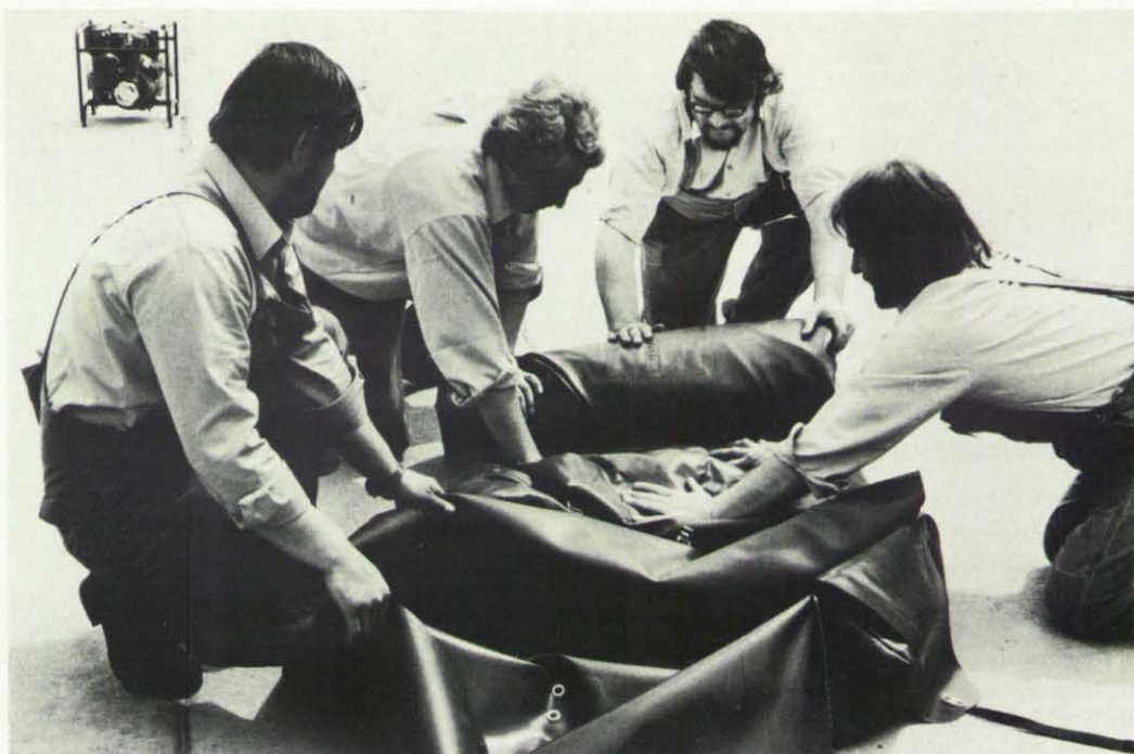
Bild 4: Zusammenrollen und Verpacken der Kunststoffbahnen eines Vorbehandlungsbehälters.
