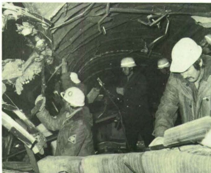
Feuerwehr und THW arbeiteten sich bei der Bergung durch die zertrümmerten Waggons.
