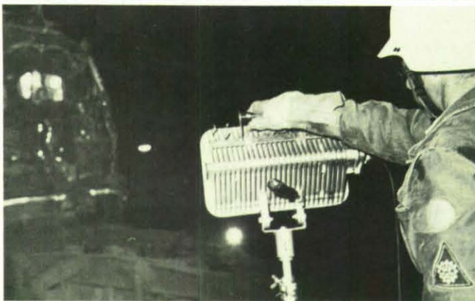
Das THW leuchtete die Unglücksstelle aus, damit die Bergungsarbeiten nach Einbruch der Dunkelheit unvermindert fortgesetzt werden konnten.
