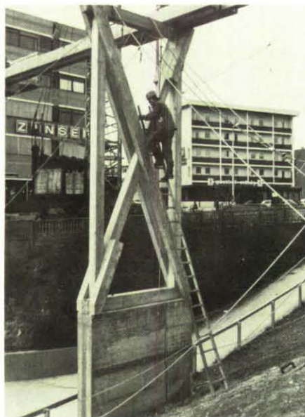
Arbeiten in luftiger Höhe.
