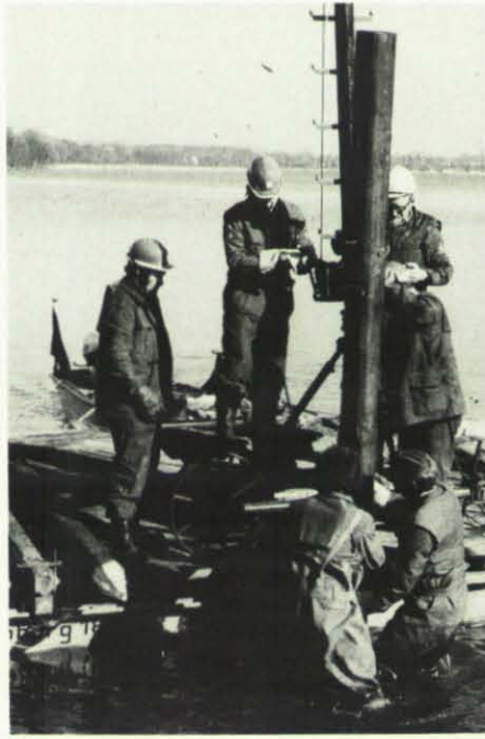
Vom Boot aus wird ein Pfahl zum Rammen vorbereitet.
