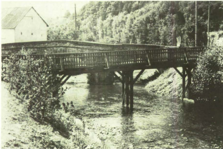
17 m lang ist diese Holzbrücke, die der OV Bitburg über die Nims baute.
