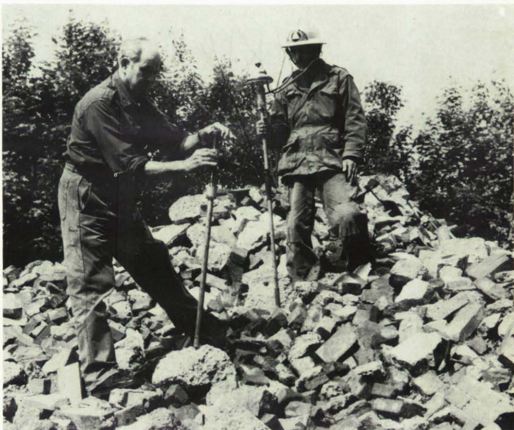
Der französische Bergungsdienst benutzt Geräte, mit denen die Helfer nach Verschütteten suchen. Dabei handelt es sich um einen Resonator, der mit einem Stethoskop verbunden ist. Aus dem Geräuschangebot können die Helfer Klopfgeräusche oder ähnliche Lebenszeichen von Verschütteten heraushören und orten.
