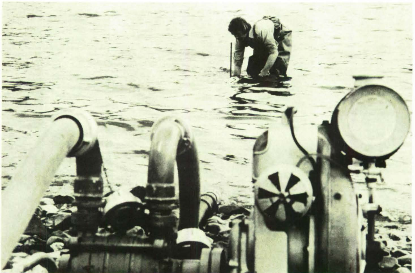
Bild 4: Kreiselpumpe für die Förderung des aufzubereitenden Rohwassers
