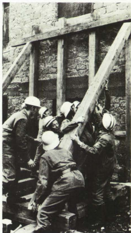
Helfer des OV Völklingen stützen ein Haus ab.
