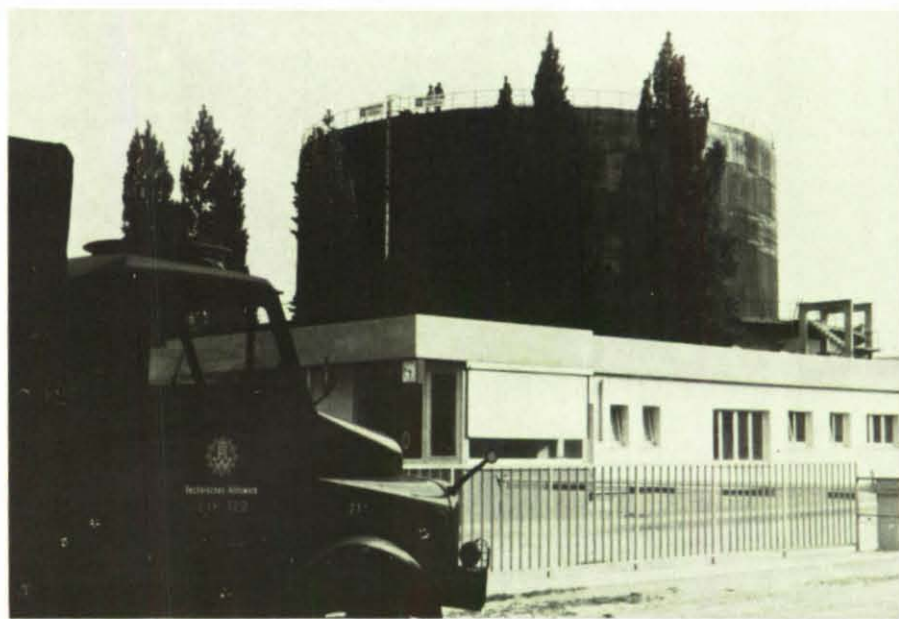
Mit 15 Millionen Liter Rheinwasser zur Druckprobe füllte das THW diesen Tank in 77 Stunden.
