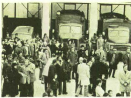
Die neue Garagenhalle des Ortsverbandes Ludweiler.
