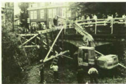
Einbau der Jocher mit Fremdhilfe.
