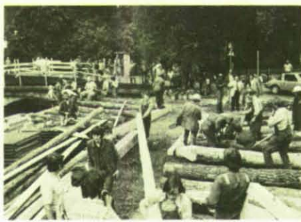
Betrieb auf dem Bauplatz an der Brückenrampe.
