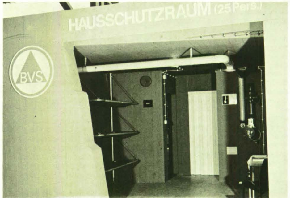
Blick in den Hausschutzraum. Zur Verdeutlichung der Konzeption wurde ein Teil der Wand weggelassen. Im Hintergrund die Schiebetür zum Toilettenraum.
