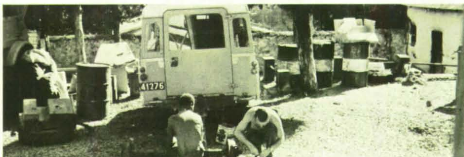
Blick auf die „Werkstatt“. Alle Reparaturen werden im Freien unter primitivsten Bedingungen ausgeführt.
