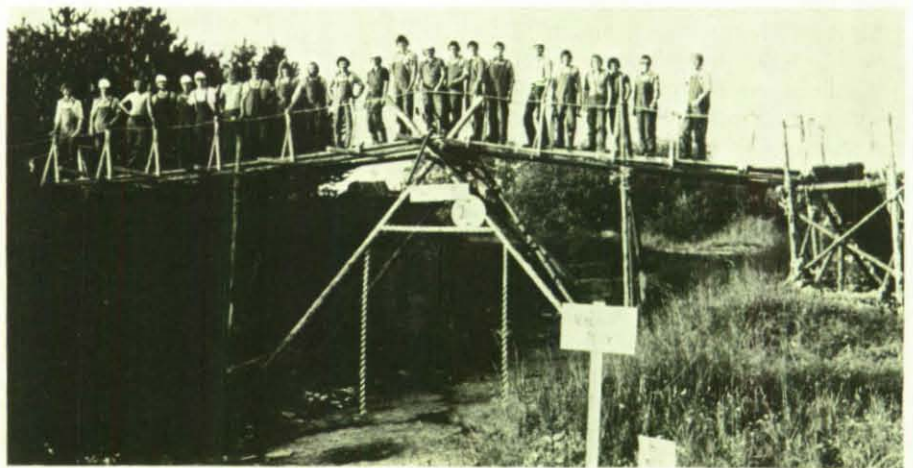
Die zum Bau des Bocksprengwerk-Steges eingeteilten Helfer des OV Wittlich testen durch Belastung ihr in dreieinhalb Stunden errichtetes Werk. Der Steg kann von den Einsatzfahrzeugen bequem unterfahren werden.
