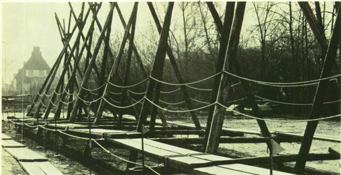
Im Übungsgelände: Als Demonstration handwerklichen Könnens der Helfer, ein vorbildlich gebauter Hängesteg.
