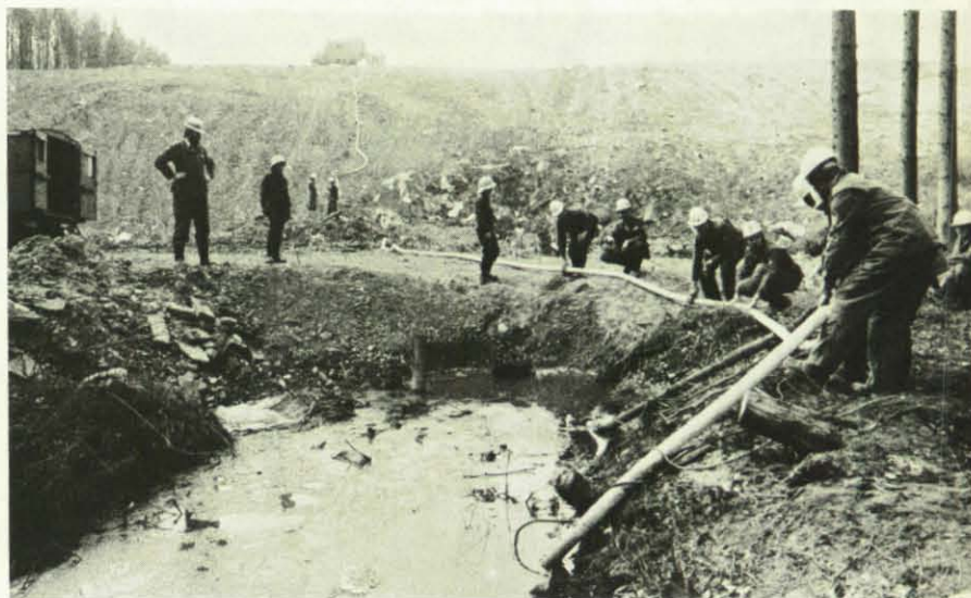
Auspumpen eines verschmutzten Teiches durch das THW.
