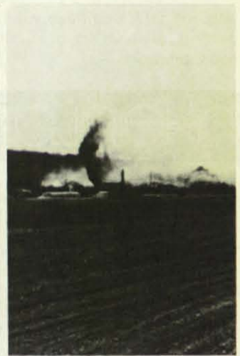
Endphase der Sprengung.
