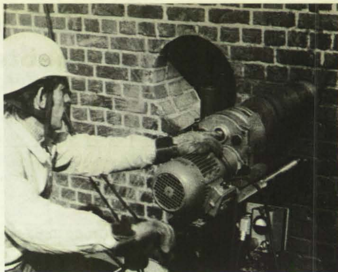
Bild links: Das Bohrgerät in Betrieb. Die Bohrkronen sind diamantenbesetzt und schneiden nur 3–4 Prozent des gewonnenen Querschnitts als zylindrischen Kern bei nur geringem Energieaufwand. Rechts: Schnell anzubringen sind Erkundungs- oder Versorgungsbohrungen, über die Eingeschlossene leicht geortet und mit Atemluft, Schutzmasken, Lösch- und Trinkwasser, Medikamenten u. ä. versorgt werden können.
