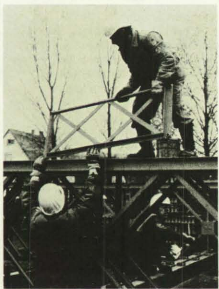
Die 103 Tonnen schwere Brücke wurde nach Fertigstellung für 16 Tonnen Nutzlast freigegeben.
