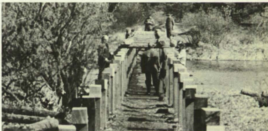
Die Brücke wächst. Durch die Verwendung von Naturhölzern paßt sie sich harmonisch an die Umgebung an.
