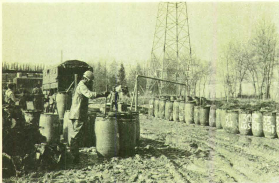
Die Lostmunition wird in Kunststoffässer gefüllt.
