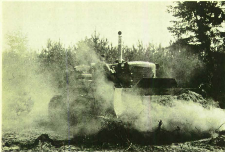
Eine Planierraupe der amerikanischen Pioniereinheiten im Einsatz.
