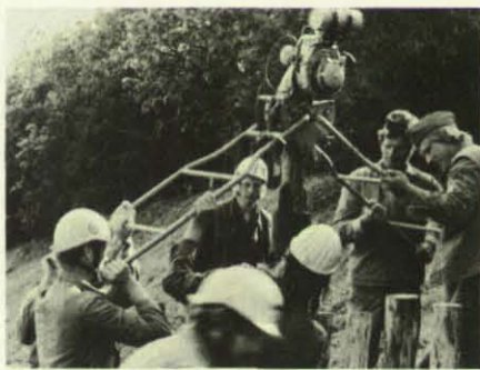
Eine Faschinenbank wird gebaut. Die Pfähle werden mit dem Wacker gerammt.
