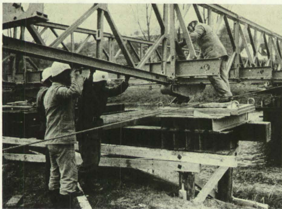
Eine 70 m lange und über 5 m breite Bailey-Brücke baute das THW als Behelfsübergang über die Jagst.
