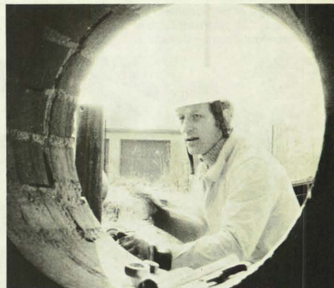
Bild links: Bohrkronen und Bohrkern nach dem Durchbruch. Das Stahlbeton-Kernbohrverfahren ist schon seit langem bekannt. Es mußte nur auf die besonderen Bedingungen bei der Bergung abgestimmt werden. Rechts: Eine beachtenswerte Neuerung auf dem Bergungssektor: Ein glattes Bohrloch mit statisch günstigem Querschnitt als Durchschluß für Eingeschlossene und Bergungskräfte.
