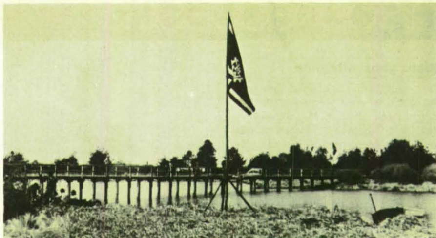
Die Fußgängerbrücke über einen Ausläufer der Thülsfelder Talsperre hat eine Länge von 120 Metern.
