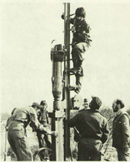
Hier wird die Ramme eingestellt, mit der die zum Unterbau der Brücke gehörenden wasserbeständigen brasilianischen Bongossipfähle in den Boden getrieben wurden.
