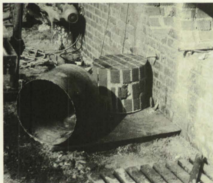
Bild links: Bohrkronen und Bohrkern nach dem Durchbruch. Das Stahlbeton-Kernbohrverfahren ist schon seit langem bekannt. Es mußte nur auf die besonderen Bedingungen bei der Bergung abgestimmt werden. Rechts: Eine beachtenswerte Neuerung auf dem Bergungssektor: Ein glattes Bohrloch mit statisch günstigem Querschnitt als Durchschluß für Eingeschlossene und Bergungskräfte.
