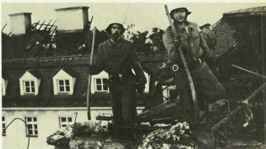
THW-Helfer bei Aufräumarbeiten auf dem ausgebrannten Dach der Schule.
