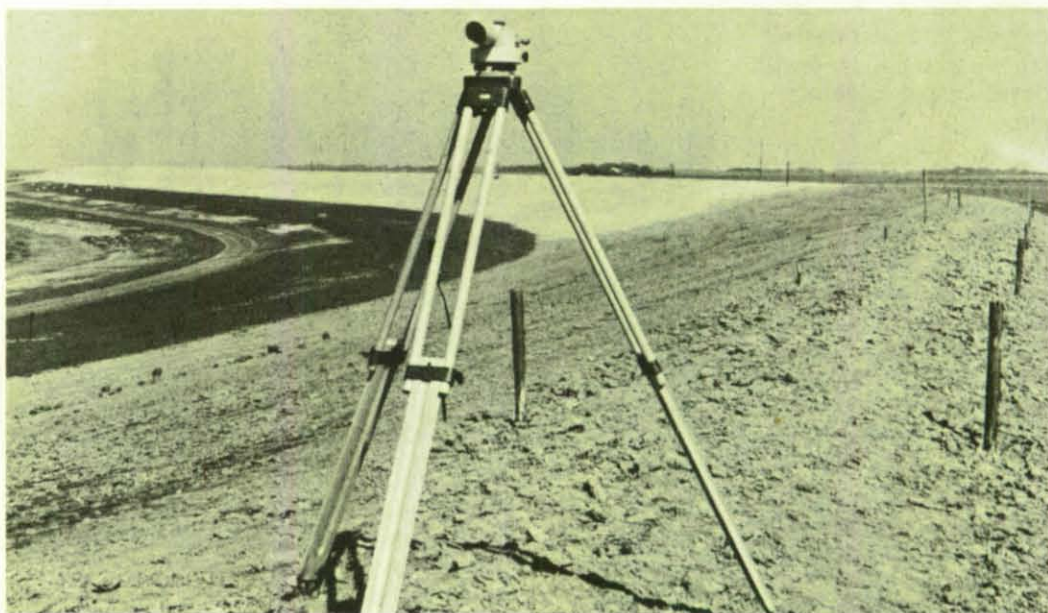
Ein gerade fertiggestellter verstärkter Deich, auf den nur noch die Rasendecke eingesät werden muß. Zu den wichtigsten Baumaßnahmen gehören auch Deichverkürzungen zur Verringerung des verbleibenden Restrisikos.
