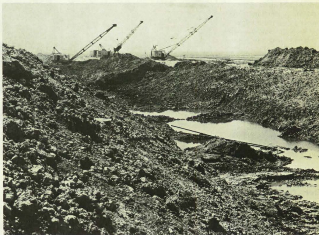
Ein noch intakter, aber zu niedriger Deich wird verstärkt. Dazu wird zunächst der Deichkern ausgebaggert und der Boden auf die Innen- und Außenböschung gebracht. Dann wird der Deichkern mit Spülsand aufgefüllt.
