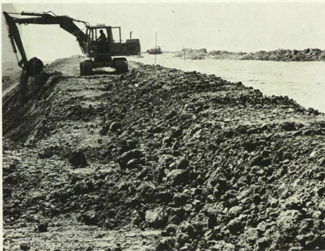
Alle Erdbewegungen im modernen Deichbau werden mit Hilfe von Maschinen durchgeführt. Weil sich das Ausmaß einer Sturmflut nicht voraus abschätzen läßt, müssen Deiche mit allen Mitteln so widerstandsfähig wie nur möglich gebaut werden.
