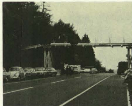
Allein das Mittelstück hat eine Spannweite von 14,40 m. Die Gesamtlänge der Fußgängerbrücke am Nürburgring beträgt 41 m.
