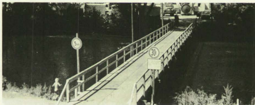
Blick auf die fertiggestellte Brücke über die Lenne.
