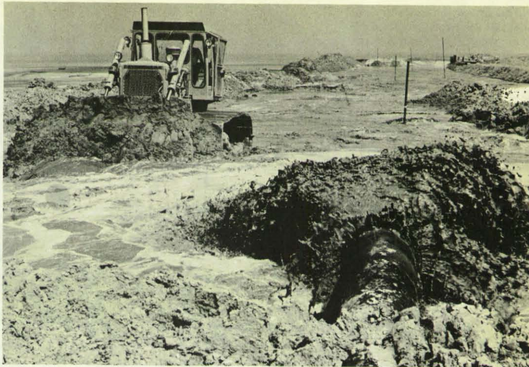
Hier strömt das Sand-Wasser-Gemisch aus der Rohrleitung in den zuvor ausgebagerten Raum. Der Sand setzt sich ab, das Wasser läuft zurück ins Meer. Der Schaufelbagger sorgt stets für ausreichende Abdämmung.
