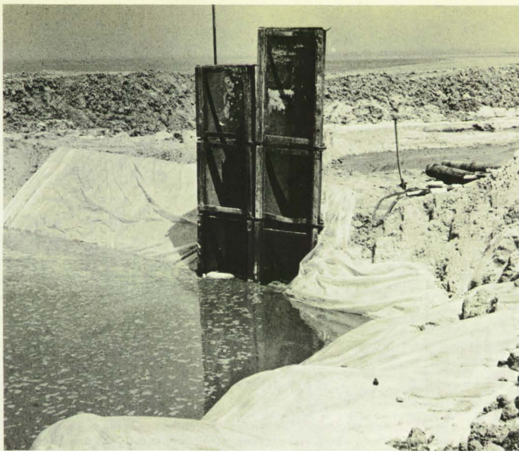
Diese Spundwand staut das Wasser, nimmt ihm seine Bewegungsenergie und läßt es nur langsam abfließen. Die Sandkernbauweise gewinnt immer mehr an Bedeutung. Sie ist wirtschaftlich und schnell.
