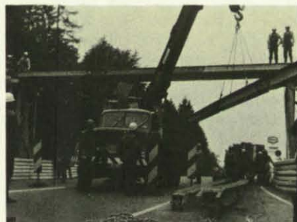
Der Autokran aus dem Lager Mehlem unterstützte die Arbeiten beim Bau der Fußgängerbrücke.
