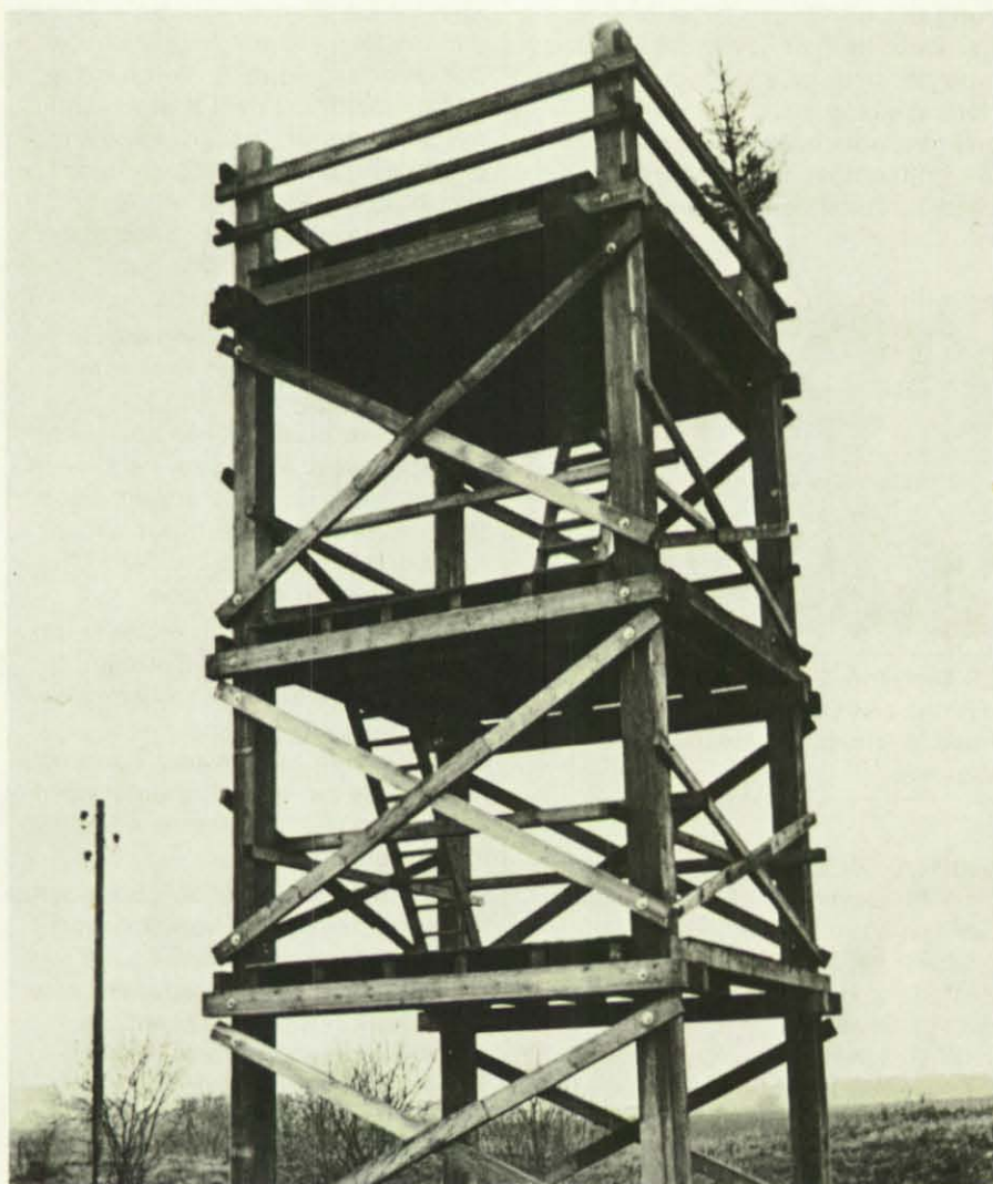
Lang ersehnt, endlich erreicht: Richtfest für den neuen Übungs- und Bergungsturm des THW Ellwangen.
