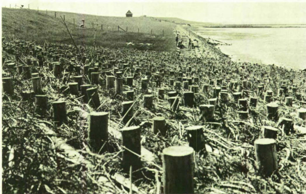
An Schleswig-Holsteins Küsten sind Baumaßnahmen zum Küstenschutz in vollem Gange. Ältere Deiche ohne ausreichende Höhe (unser Bild) werden verstärkt und erhalten ein neues Deichprofil.
