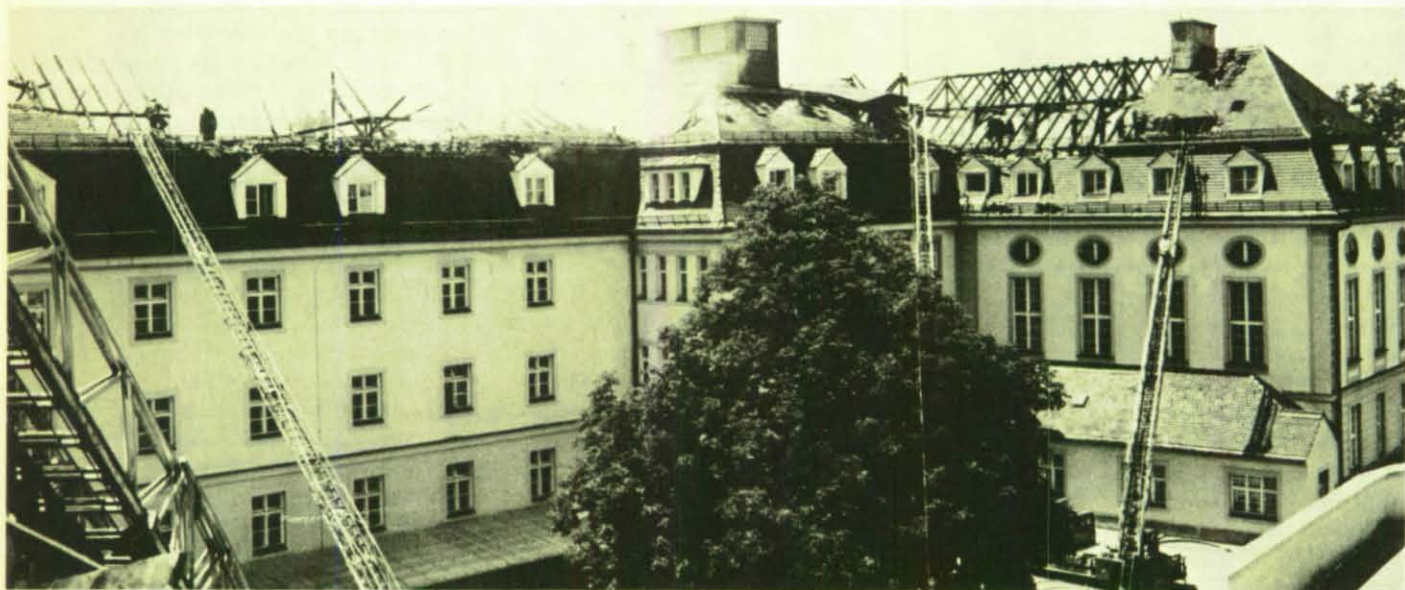
Auf einer Länge von etwa 200 Metern brannte der Dachstuhl der Tagesheimschule des Kath. Familienwerks in Pullach ab. Unser Bild zeigt zwei Drittel der Schadensstelle.
