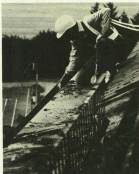
In 18 Metern luftiger Höhe: Säubern der Dachrinne.
