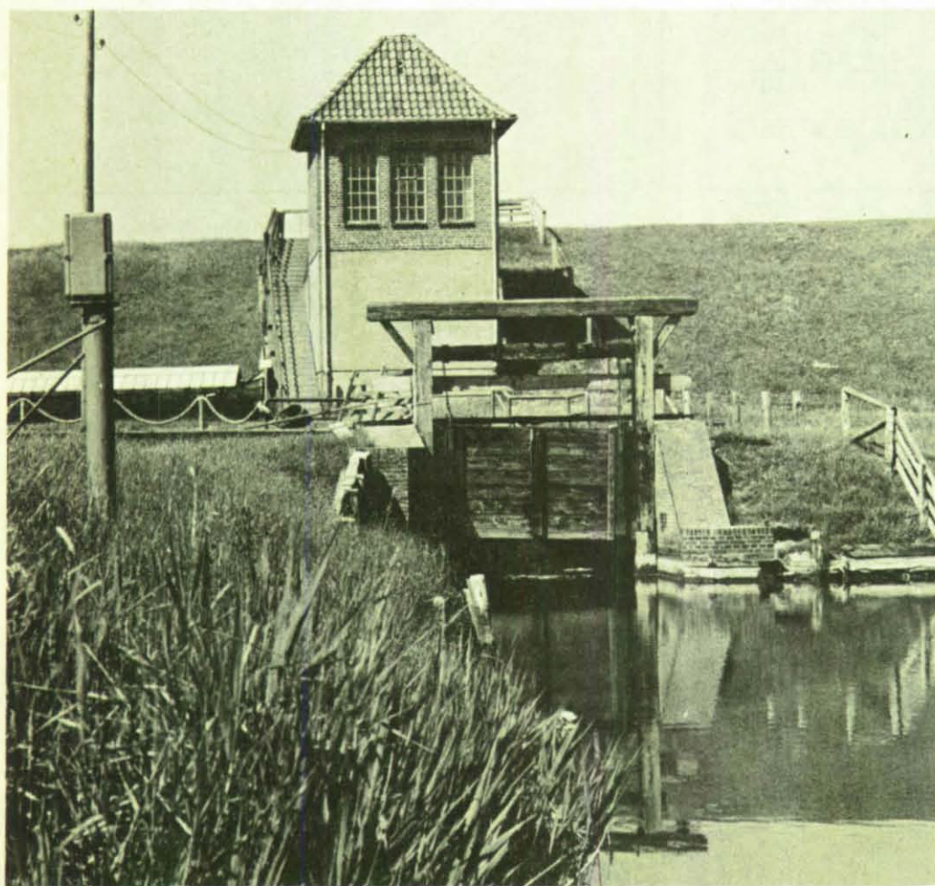
Auch Siele dienen der Entwässerung des Hinterlandes. Unser Foto zeigt den landseitigen Teil einer Anlage, die maschinell die Schütze verschiedener Bauart öffnet und schließt.
