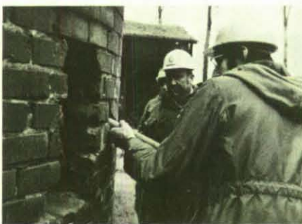
Links: Sorgfältig wurden die Sprenglöcher besetzt. Links ein Fallschlitz. Rechts: Genau nach Plan fielen die beiden 45 m hohen Kamine.
