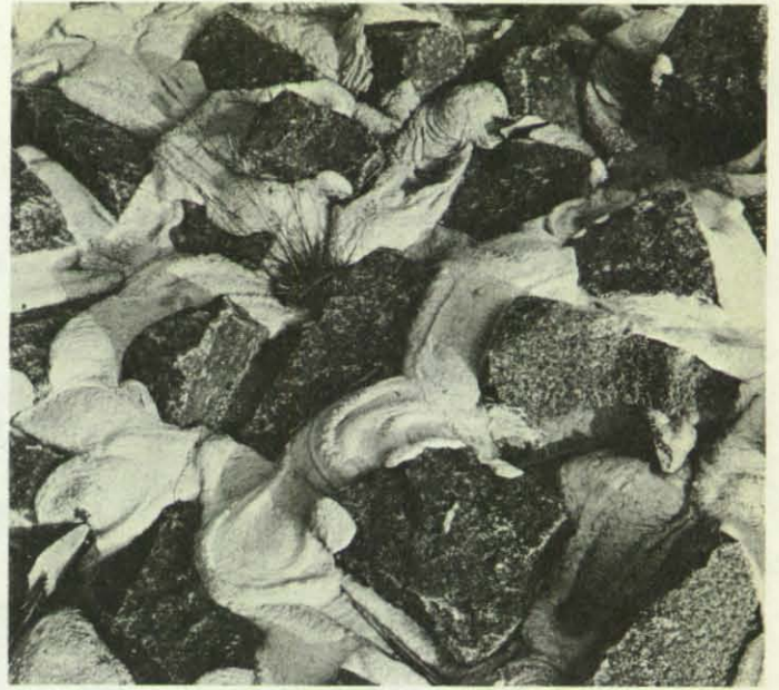
Schweres, mit Beton vergossenes Steindeckwerk sichert den seeseitigen Böschungsfuß der Deichanlagen, die sich beiderseits des Sperrwerks anschließen.
