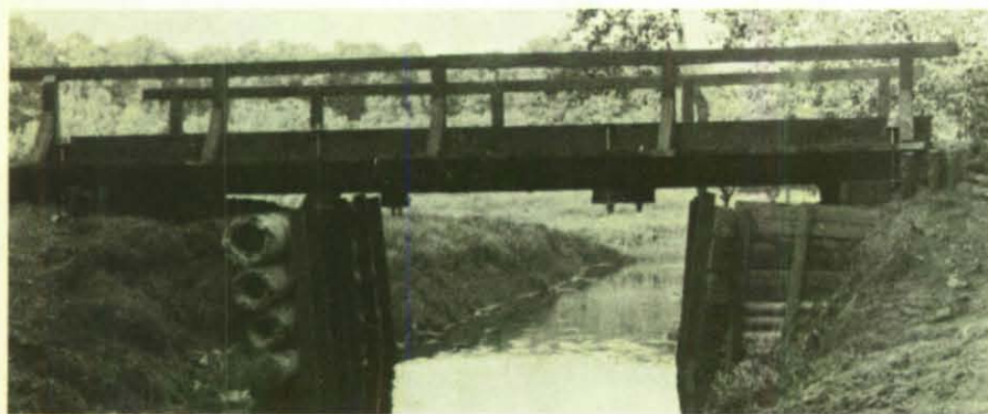
Der Bergungszug Mölln bewies seine Leistungsfähigkeit: Nach knapp zwei Tagen konnte die neue Brücke der Öffentlichkeit übergeben werden.
