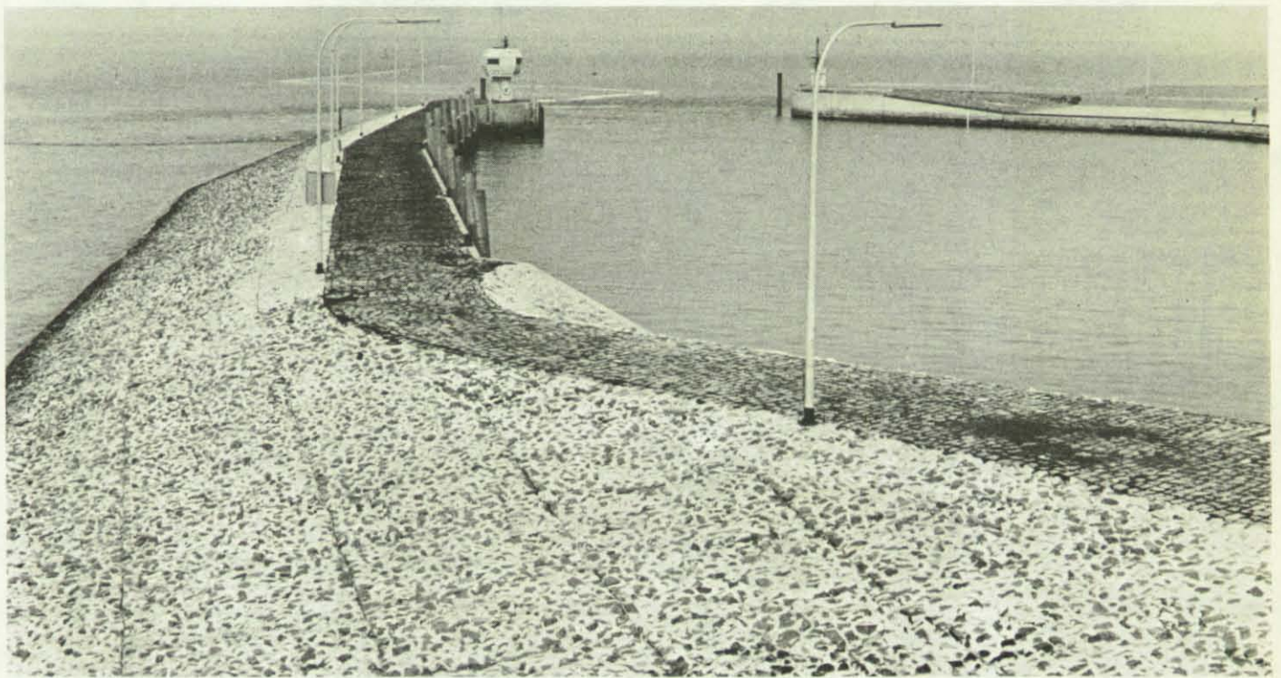
See- und landseitig sind der Schleuse, die durch das Sperrwerk geht, Vorhäfen vorgelagert, die in erster Linie den auf Schleusung wartenden Schiffen Liegeplätze bieten.
