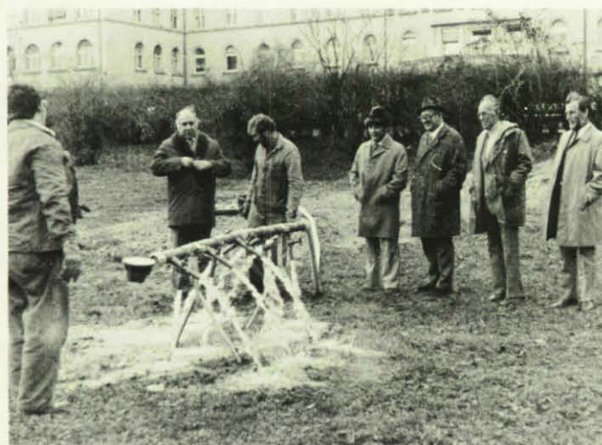
Abnahme des Trinkwasser-Notbrunnens.
