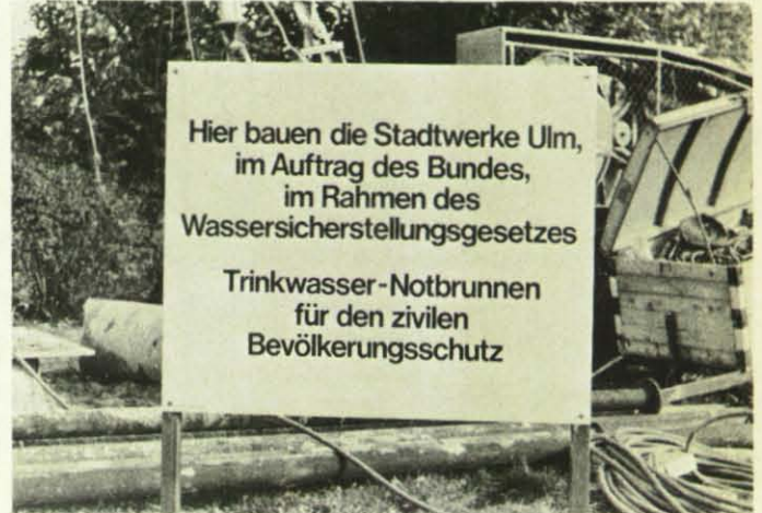
Oben: Baustellenschild in Ulm. Unten: Der Bohrturm.
