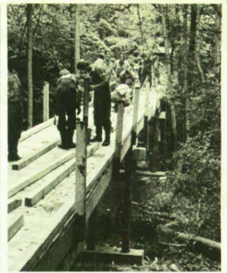
Die neue Fußgängerbrücke – hier die THW-Helfer beim Bau – erschließt den Roggenburger Urwald.
