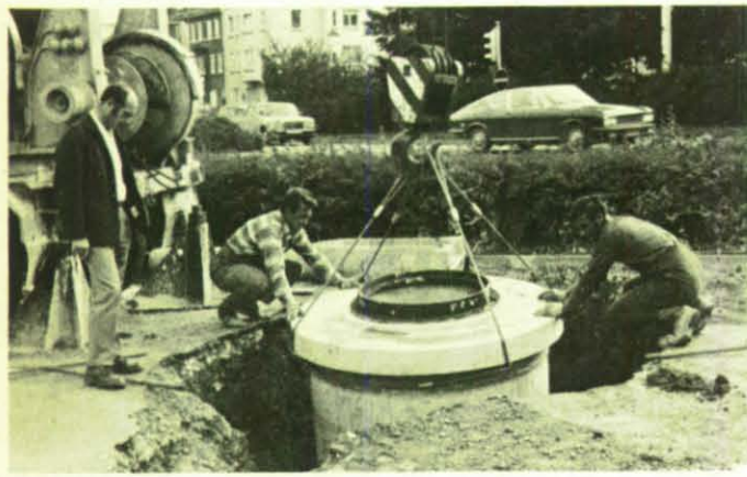
Einsetzen eines Fertigbetonschachts.
