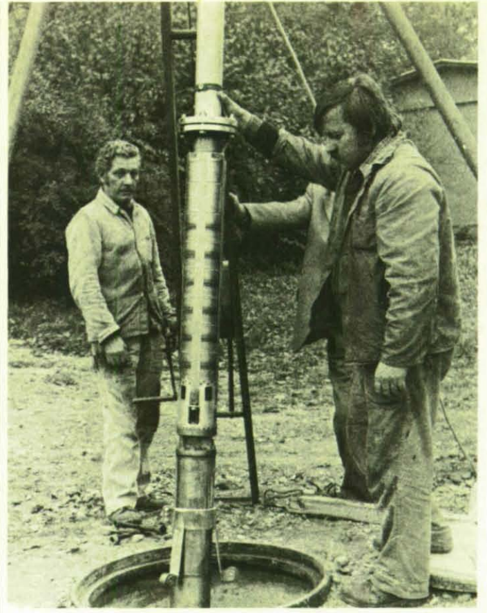
Einbau einer Pumpe mit Zentriervorrichtung.
