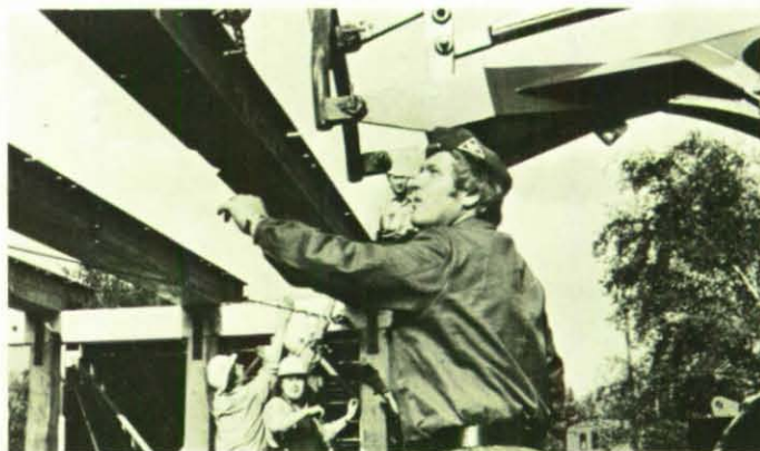
Sechs Tonnen Tragkraft besaß die Fußgängerbrücke, die als Fußgängerüberweg gebaut worden war.
