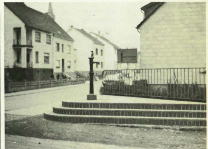
Notbrunnen mit Hand-Schwengelpumpe.
