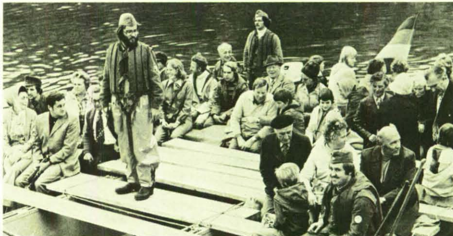
Viele Bürger benutzten die vom THW gebauten Personenfähren über die Lippe.
