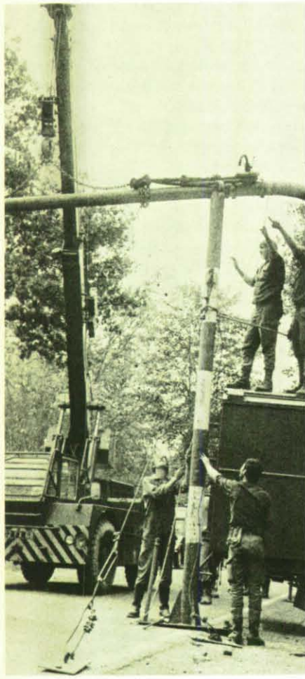
Aufbau einer Straßenüberführung der Löschwasser-Pipeline: gemeinsamer Einsatz von THW, Feuerwehr und Bundeswehr.
