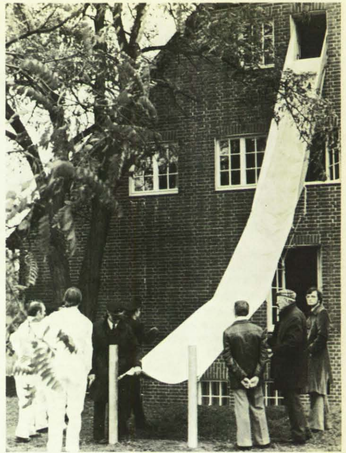
Bild links: Diesen Weg nimmt die vom Feuer gefährdete Person beim Hinuntergleiten auf der schweren Gewebbahn. Rechts: So sieht die betriebsbereite Rettungsutsche von unten aus. Bild unten: Aufgerollt findet das Rettungsgerät unter dem Fenstersims in einem Schutzbehälter Platz.
