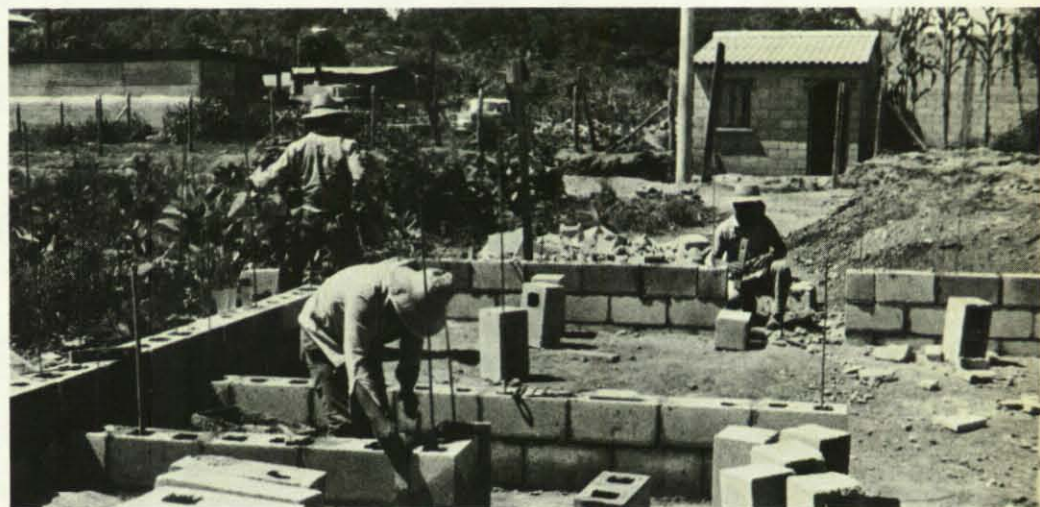
Hohlblocksteine mit starken Eisenverstrebungen sind das technische Konzept, um die neuen Häuser der Indios gegen Erdbeben besser zu schützen.
