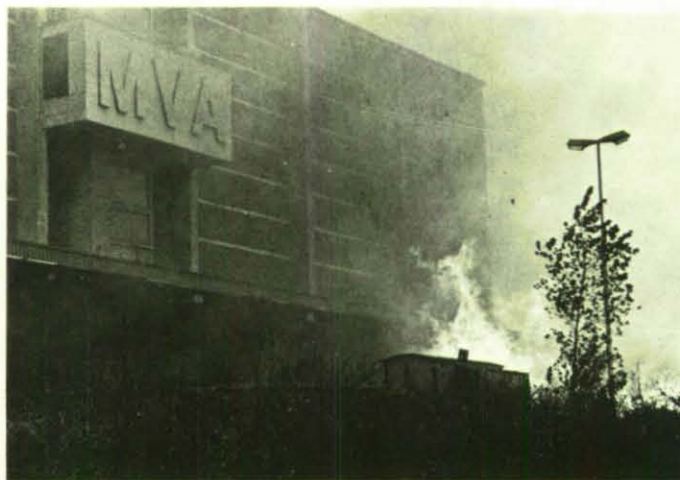
Teil der Großübung in Bremen: Explosion in der Müllverbrennungsanlage (MVA).
