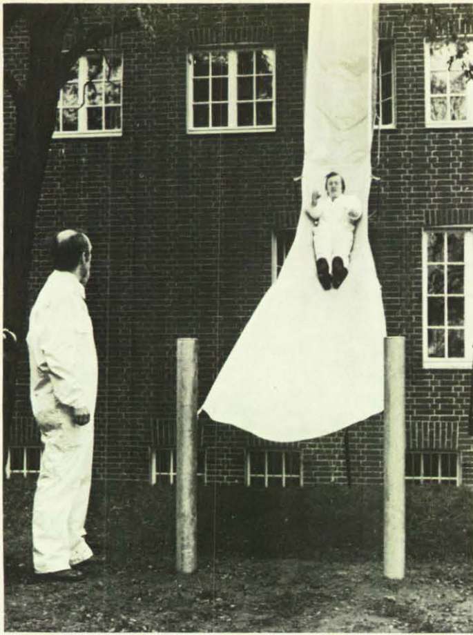
Bild links: Diesen Weg nimmt die vom Feuer gefährdete Person beim Hinuntergleiten auf der schweren Gewebbahn. Rechts: So sieht die betriebsbereite Rettungsutsche von unten aus. Bild unten: Aufgerollt findet das Rettungsgerät unter dem Fenstersims in einem Schutzbehälter Platz.
