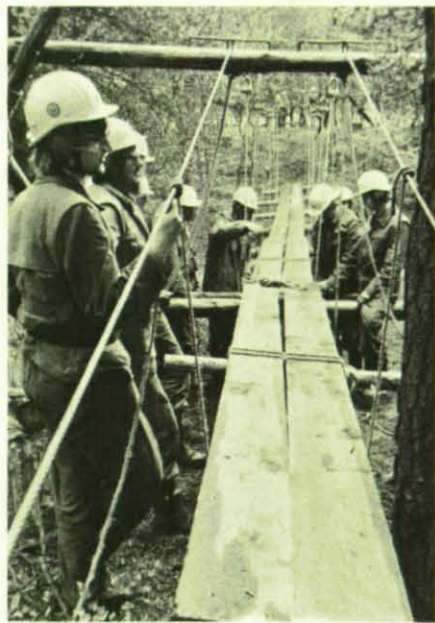
Immer wieder wird geübt: Helfer beim Bau eines Notsteges.
