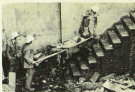
Über eine steile Kellertreppe bergen die THW-Helfer den auf einer Trage liegenden „Verletzten“ aus den Trümmern einer Fabrikhalle.
