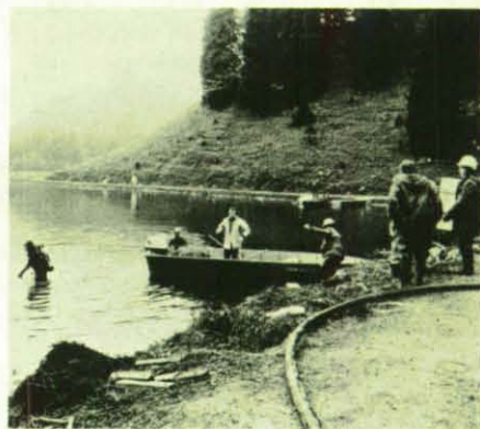
Taucher und Helfer des OV Miesbach verlegen mit Hilfe des A-Bootes 560 m Kabel durch den See.
