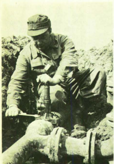
Oben links: An einer Übungsbaustelle wird an einer Wasserversorgungsleitung NW 100 aus Guß eine Anbohrschelle mit Ventil für einen Hausanschluß gesetzt.
