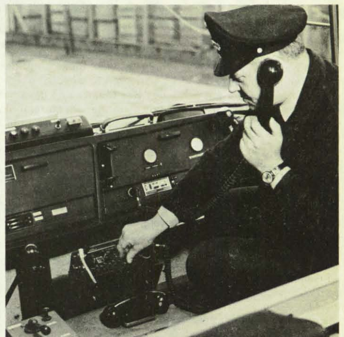
Mit dem in den Tunnelwänden vorhandenen Schlitzkabelsystem wird die Funkverbindung über den Leitstand der Verkehrsbetriebe zur Feuerwache sichergestellt.
