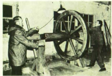
Die Rekonstruktion der alten „Chaspell“ funktioniert. Die Erbauer bei der Bewegungsprüfung.
