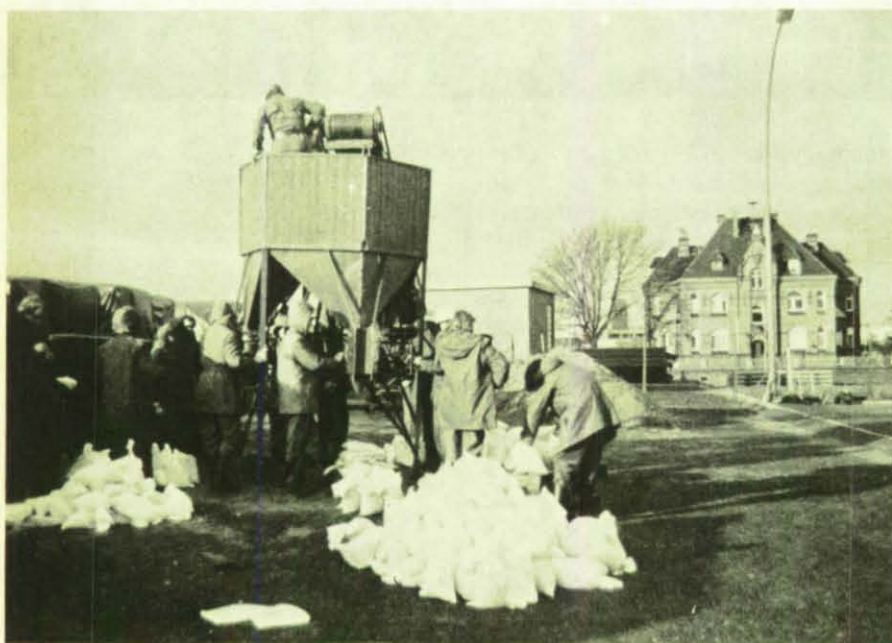
Ausbildung an einer Sandsack-Füllanlage des THW.
