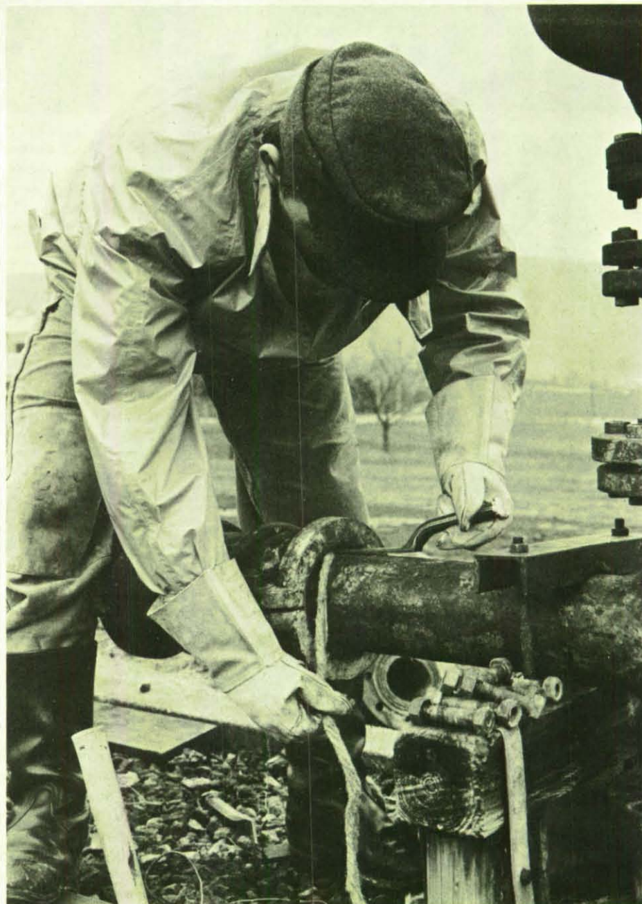
Oben links: An einer Übungsbaustelle wird an einer Wasserversorgungsleitung NW 100 aus Guß eine Anbohrschelle mit Ventil für einen Hausanschluß gesetzt.
