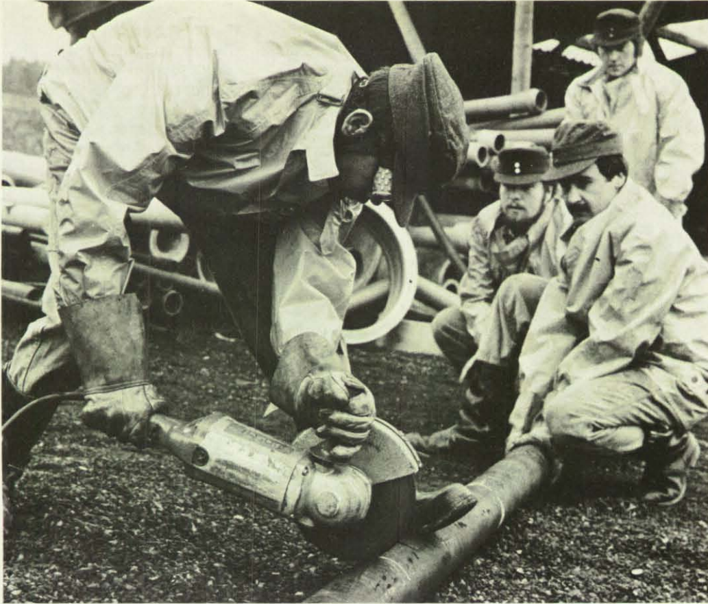
Oben: Ein Asbestzementrohr wird mit dem Trennschleifer auf die erforderliche Länge geschnitten.
