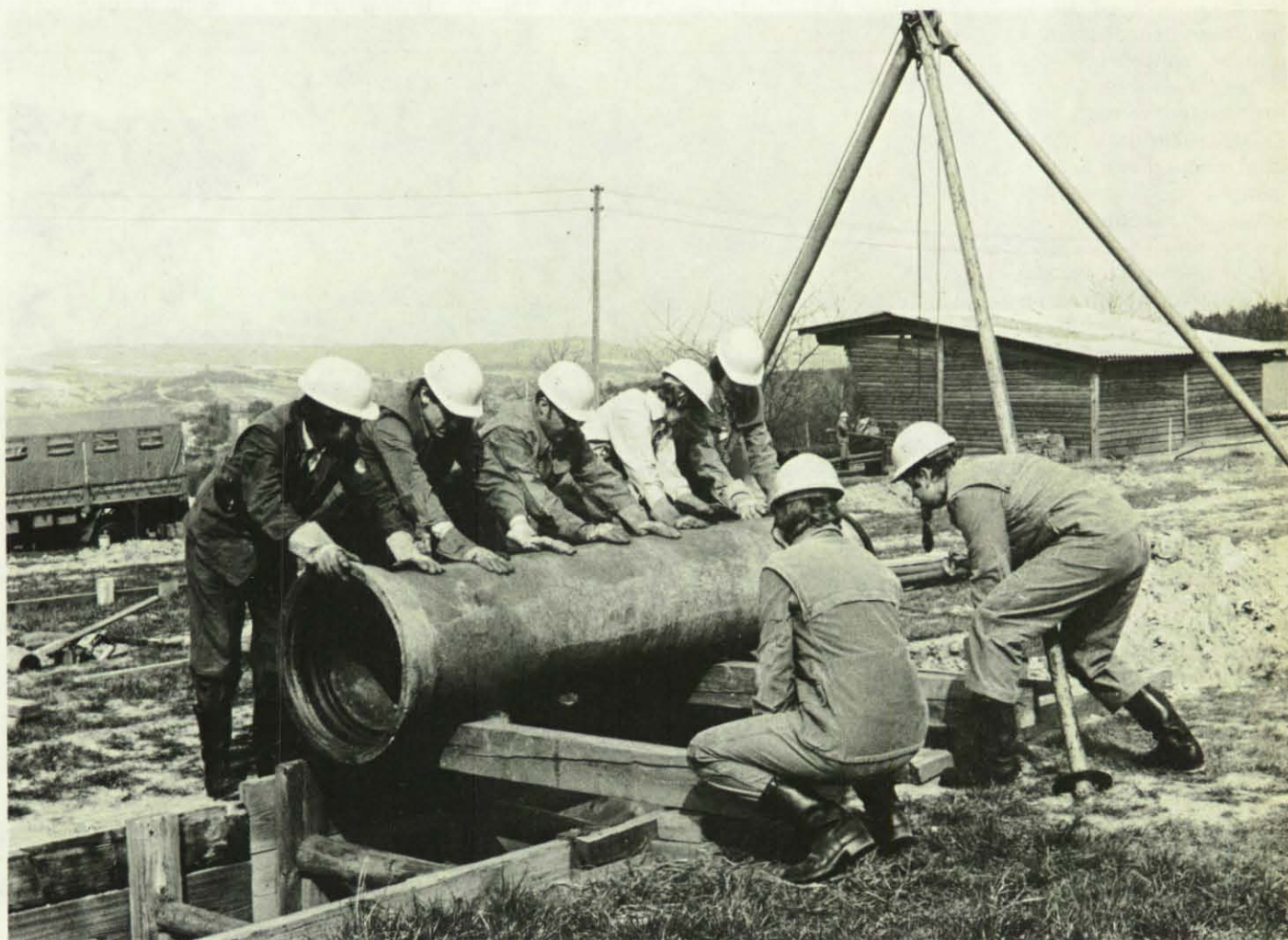
Ein Gußrohr NW 500 mit Schraubmuffenverbindung wiegt mehr als 1000 kg und erfordert deshalb beim Verlegen viele Hände.
