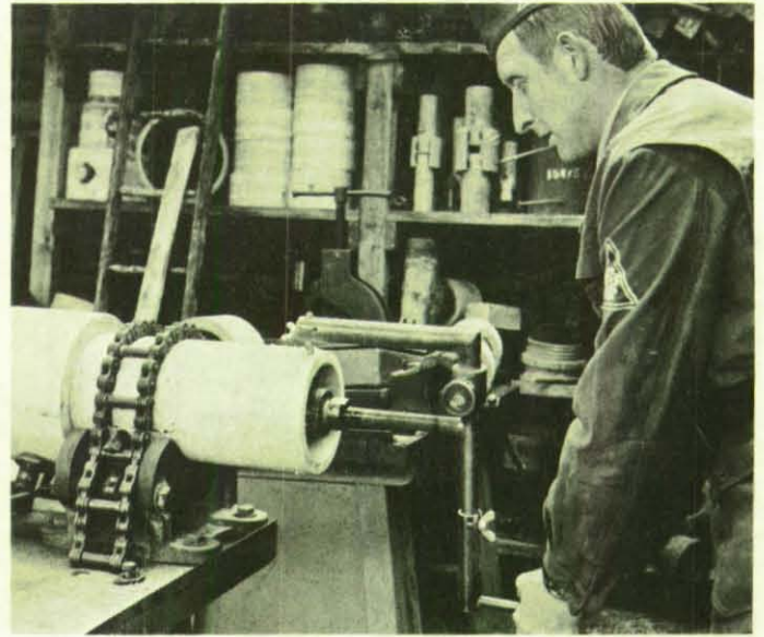
Unten: Damit das Asbestzementrohr in die Reka-Kuppung paßt, muß es außen abgedreht werden.
