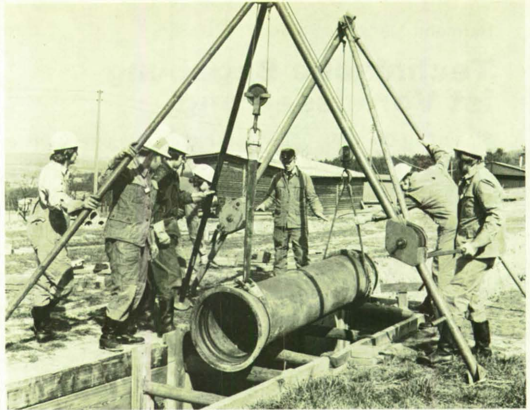
Zum Absenken des Gußrohres in den verbauten Rohrgraben sind zwei Rohrlegewinden nötig.
