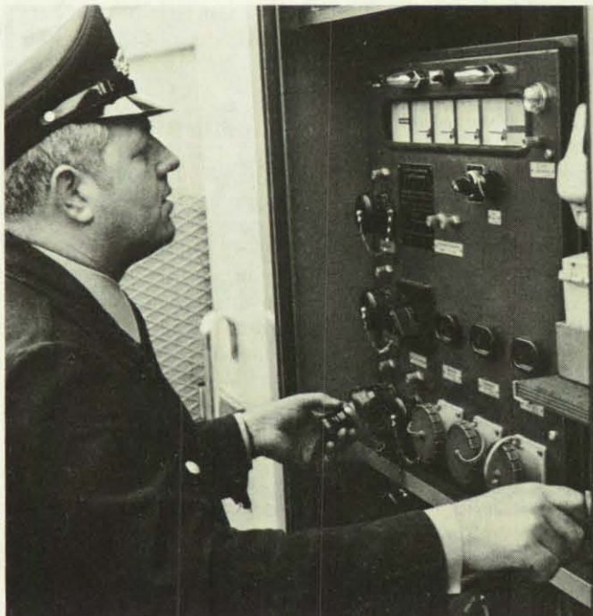
Eine eigene Stromversorgung für die umfangreiche Beleuchtungseinrichtung sichert in den dunklen Tunnelabschnitten die Energieversorgung des Fahrzeuges.
