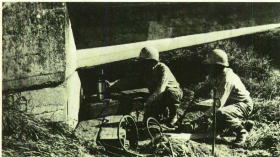
Auf festem Unterbau wird ein Öldruckheber unter der Brücke angesetzt – die Brücke wurde um 50 cm angehoben.
