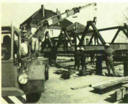
Beim Aufbau der D-Brücke werden die schweren Brückenteile mit Hilfe eines THW-Krans bewegt und an Ort und Stelle gebracht.
