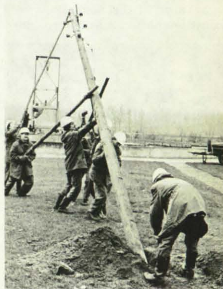
Der Instandsetzungszug des OV Halle errichtete übungsmäßig eine Freileitung.
