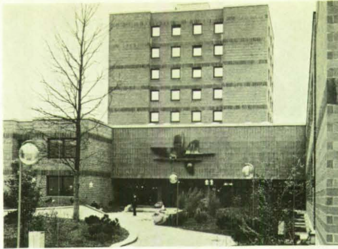
Der Eingangsbereich mit der von Künstlerhand geschaffenen Keramik über dem Portal. Im Hintergrund der sechsstöckige „Wohnturm“.
