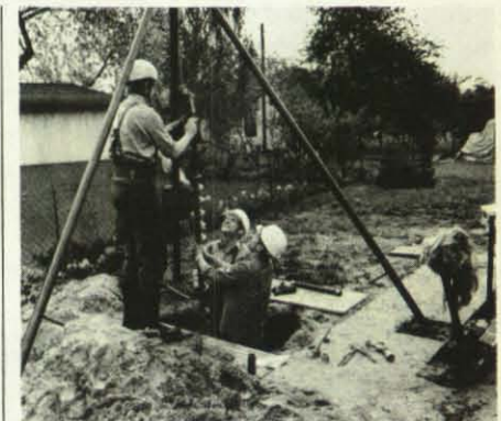
Die Berliner THW-Brunnenbohrspezialisten im Einsatz.
