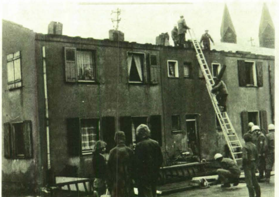
Zwei Gruppen des B-Zuges Völklingen waren im Einsatz, um das Dach des Häuserblocks in Püttlingen abzudichten.
