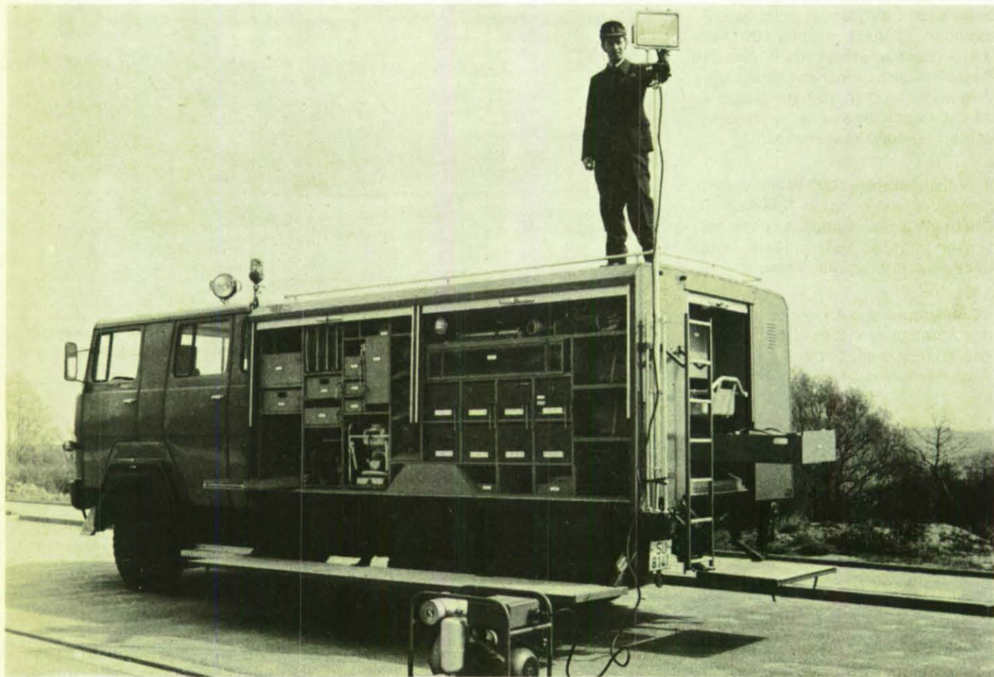
Die Rückseite des Kofferaufbaus des GWK 72, zweite Fertigungsserie, ist mit einer Halterung für ein auf 5 m ausziehbares Dreibeinstativ zur Aufnahme eines Flutlichtstrahlers versehen.
