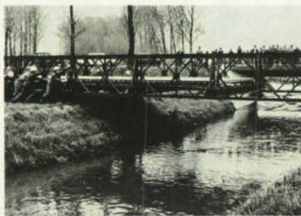
Auch ohne vorherige Probe klappte der Bau der Bailey-Brücke beim OV Landau bestens.
