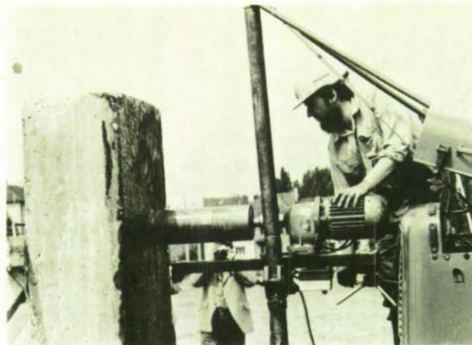
Oben: Das Diamantbohrgerät ist eine wertvolle Alternative zur Sauerstoffflanze. Betonwände sind kein Hindernis beim Bohren von Löchern unterschiedlicher Größe.
