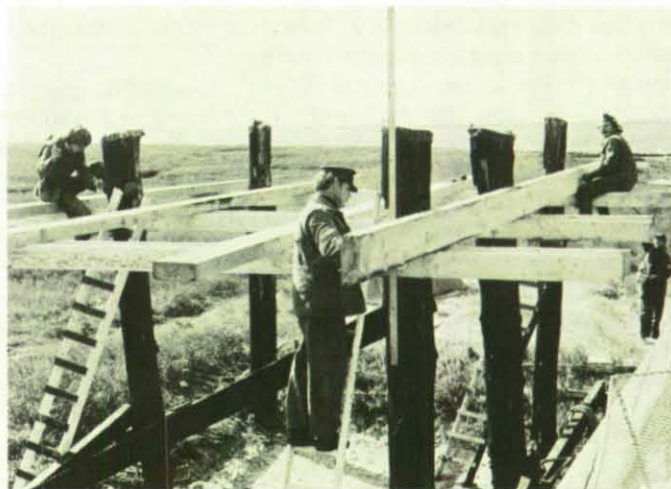
Die Unterkonstruktion für eine 4 t schwere Hütte wird errichtet.
