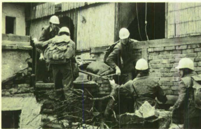
Ein zum Abbruch anstehendes Haus dient dem Bergungszug des OV Lahr als Übungskulisse.
