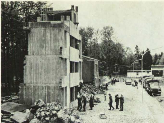
Das Fassadenhaus ist mit einer Höhe von ca. 11 m als viergeschossiger Betonskelettbau ausgeführt. Von der Rückseite her gesehen, stellt dieses Objekt ein „Puppenhaus“ dar, an dem sich im Obergeschoß ein „Schwalbennest“ gebildet hat, wie das in der Fachsprache heißt.
