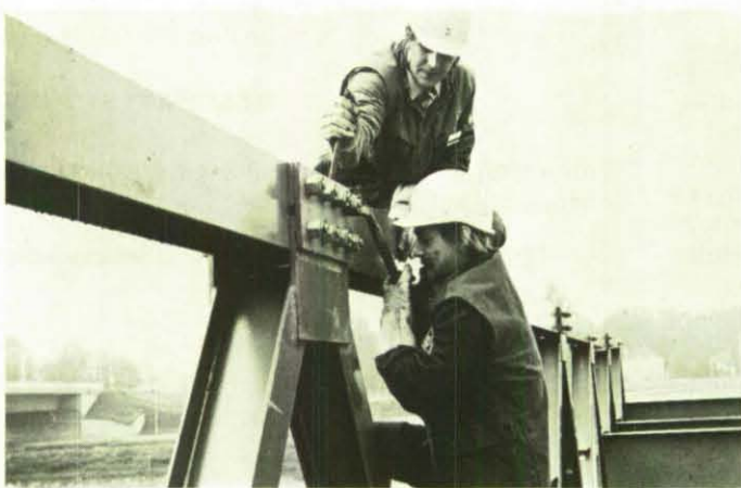
Helfer beim Bau der gewichtigen D-Brücke.
