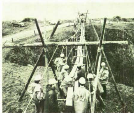
Die letzten Handgriffe am Hängesteg vor seiner Inbetriebnahme.
