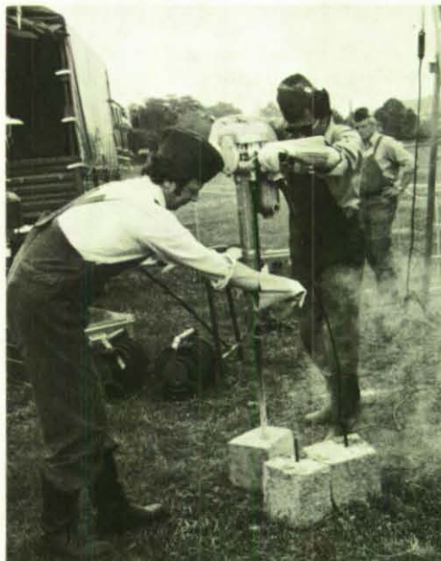
Oben: Das Diamantbohrgerät ist eine wertvolle Alternative zur Sauerstoffflanze. Betonwände sind kein Hindernis beim Bohren von Löchern unterschiedlicher Größe.
