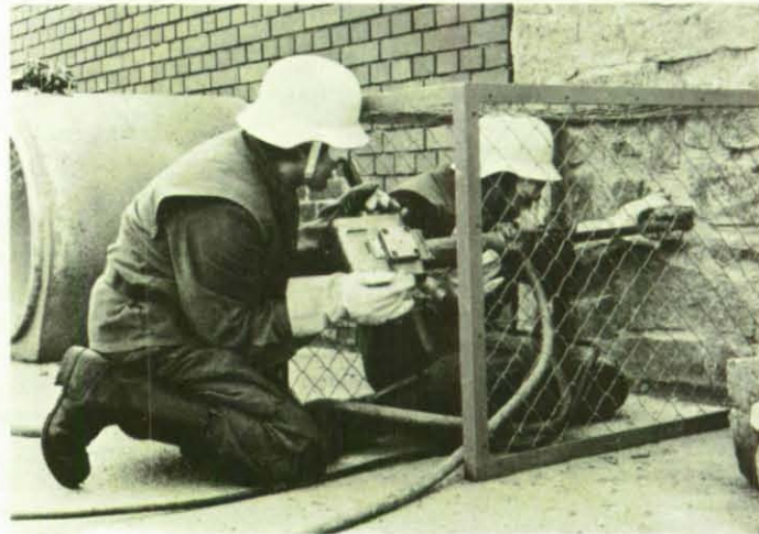
Bei den Stemmaarbeiten werden Werkzeuge und Geräte des Bergungszuges angewandt. Die Betonröhren und Maschendrahtkäfige vor der Mauer dienen der Erschwerung. Die Maschendrahtkäfige haben den Vorteil, daß die Helfer auf das richtige Vorgehen hin beobachtet werden können.
