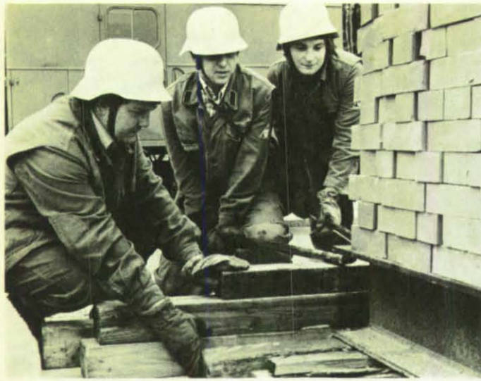
An der Übungsbahn „Hebel-Heber“ erwerben die Helfer einen Teil der Vorkenntnisse, die sie benötigen, um mit den Werkzeugen der Trageausrüstung in zerstörten Gebäuden liegende Mauerwerks- und Deckenteile anheben und verschieben zu können.
