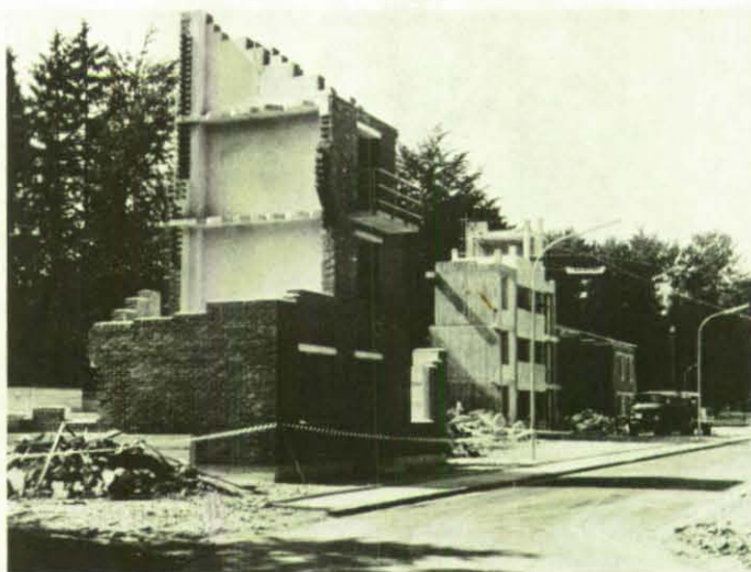
Blick auf einen Teil der Übungsanlagen der Katastrophenschutzschule Bayern in Geretsried, in denen Lehrgangsteilnehmer, insbesondere aus dem Fachbereich Bergung, nach neuesten Gesichtspunkten in der Praxis ausgebildet werden.
