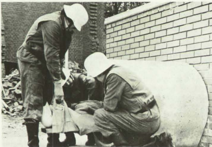
Hier wird das Bergen eines Verletzten durch Mauerdurchbruch und Betonröhre geübt. Auf der rückwärtigen Seite der Mauer unter einem Trümmerhang verläuft längs der Mauer ein teilweise vertrümmert Kriechgang, aus dem nach dem Durchbruch die Eingeschlossenen befreit werden müssen.
