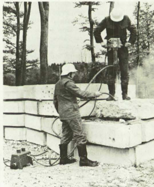
An diesen Betonklötzen wird das Arbeiten mit dem Motor-Aufreiß- und Bohrhämmer geübt.
