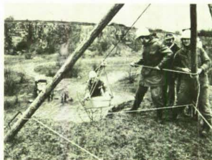
Die Seilbahn als Transportmittel für Verletzte.
