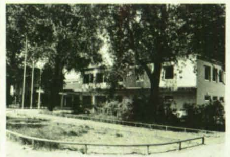
Das neue „Haus der DLRG Nordrhein“, das am 17. Juni seiner Bestimmung übergeben wurde.
