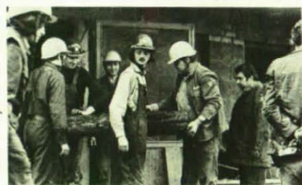
Die Garage des einsturzgefährdeten Hauses wird von Helfern des OV Mettlach abgestützt.
