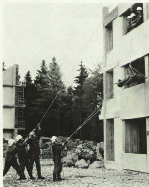
Das in seiner Grundfestigkeit erhaltene Fassadenhaus ist sehr gut zum Üben aller Bergungsmethoden aus Höhen geeignet, z. B. zum senkrechten Ablassen oder Ablassen über eine Rolle, zu Übungen mit Leitern oder zum Herstellen einer Seilbahn.
