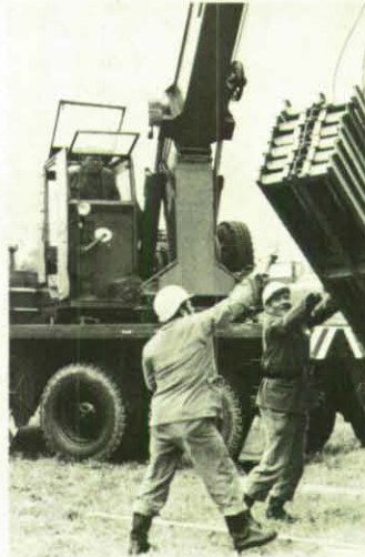
Brückenbaumaterial wird abgeladen und an der Baustelle gestapelt.
