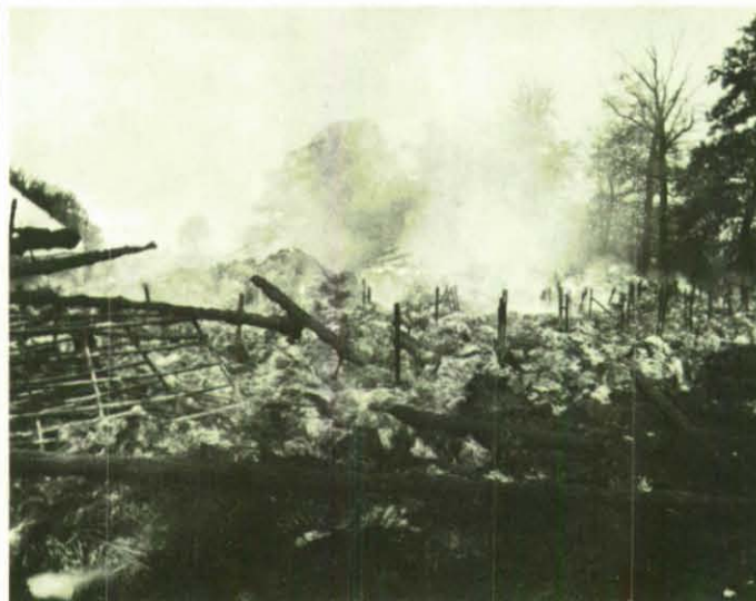
Eingeäscherte Gehöfte und verbrannte Erde – allein 1976 entstanden durch Waldbrände Schäden in Höhe von 27 Millionen DM.
