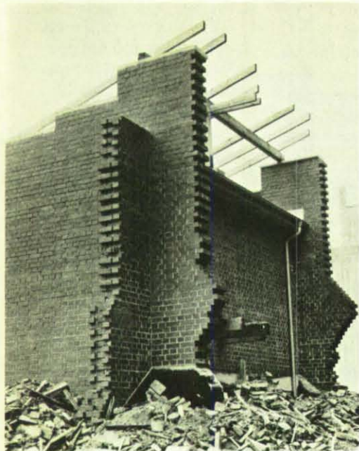
Dieses Übungsobjekt, ein Holzbalkendeckenhaus, stellt ein teilzusammengebrochenes Wohnhaus in der üblichen Bauart mit Ziegelmauerwerk und Holzbalkendecken dar. Es ist besonders für leichtere Bergungsübungen verschiedener Art geeignet.
