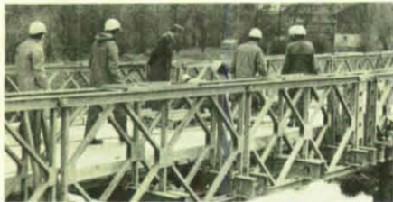
Im Landkreis Rottach-Inn wurden vom THW drei Bailey-Brücken als Behelfsbrücken errichtet.
