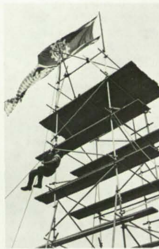
Vielseitig verwendbar ist das Rohrbaugerüst, mit dem hier Bergung aus Höhen demonstriert wird.
