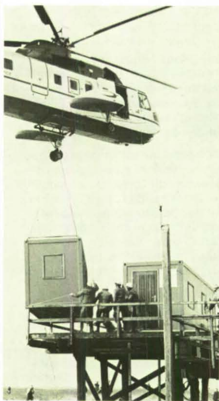
Fast zentimetergenau wurden die beiden acht Meter langen Wohnraum-Einheiten nacheinander aus der Luft vom Hubschrauber an die vorgesehene Stelle gesetzt.
